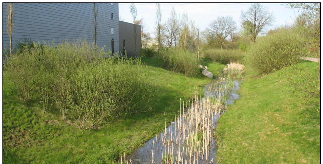
Kuva 8. Esimerkki hulevesien viivytyspainanteesta. 15
