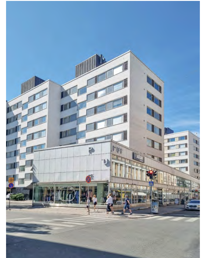
↑ Asuin-kiinteistöön liittyy pitkä ja matala katutilaa rajaava liiketilasipi.
