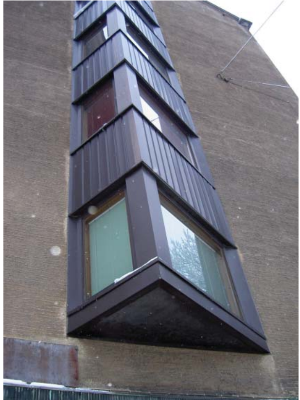
Länsipäädyn erkereiden arkkitehtuuri on kärsinyt taitamatto- masta korjauksesta. Nyt erkereiden pintamateriaalina on pin- noitettu teräsohutlevy.
