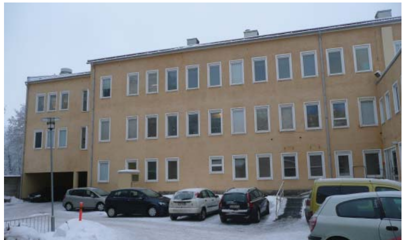
Sirkkalankadun siiven pihajulkisivu.
