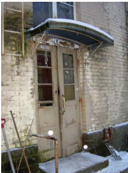
Porrashuoneen alkuperäinen ulko-ovi ovika- toksineen pohjoisjulkisivussa
