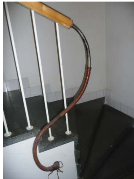
Keittiön porrashuoneen kaiteen alapäässä on alkuperäinen rottingilla päällystetty taivutus.
