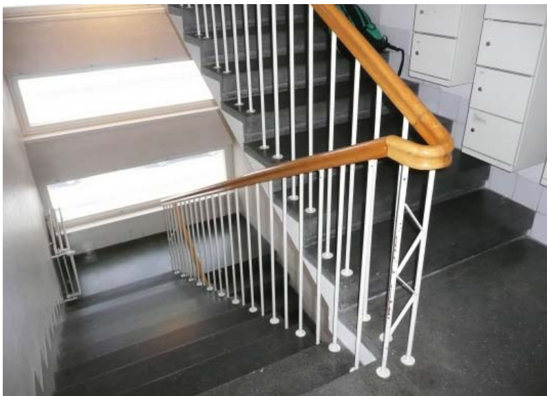
Keittiön porrashuoneen pinnakaide on pääporrashuoneen kaidetta yksinkertaisempi. Porrashuoneiden pintamateriaalit ovat samoja.
