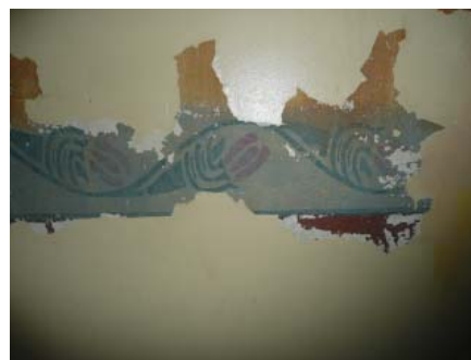
Käytävien seinissä, rapistuneiden maaliker- rosten alla, pilkottavat alkuperäiset koriste- maalaukset.
