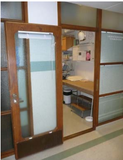
Sirkkalankadun siiven osastokäytävälläkin on säilynyt alkuperäisiä puurakenteisia lasiseiniä ja -ovia yksityiskohtineen.
