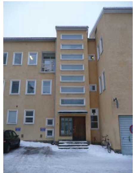
Sirkkalankadun siiven länsipäädyn porrashuone, ns. keittiön porras näkyy katujulkisivussa ulkonevana porrastornina. Ulko-ovi ja ovikatos ovat alkuperäiset, oveen liittyvä ikkuna muiden ikkunoiden tapaan uusittu
