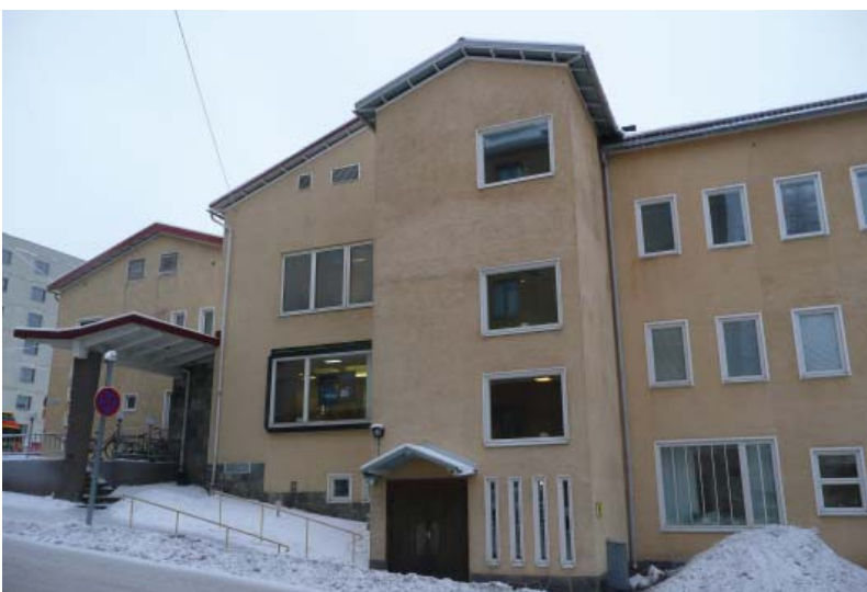
Sirkkalankadun siiven pääporrashuonetorni. Alkuperäinen ovikatos ja ulko-ovi johtavat pohjakerrokseen
