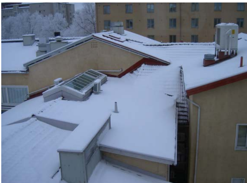
Näkymä tornista pohjoiseen. Etualalla näkyy vuonna 1996 tehty katulappeen korotus ja uusittu kattolyhty.
