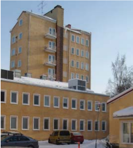
Vuoden 1972 peruskorjauksen näkyvin muutos ulkoarkkitehtuuriin oli Kaskenkadun siiven pihaterassin muuttaminen sisätilaksi. Yläkuva Suomen rakennustaiteen museon kuva-arkisto/ Heikki Havas, alakuva Jussi Laimi.
