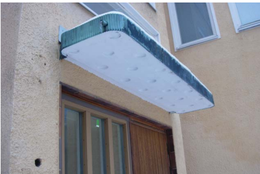
KUVA: Sirkkalankadun porrastornin ulko-oven betonikatokse
