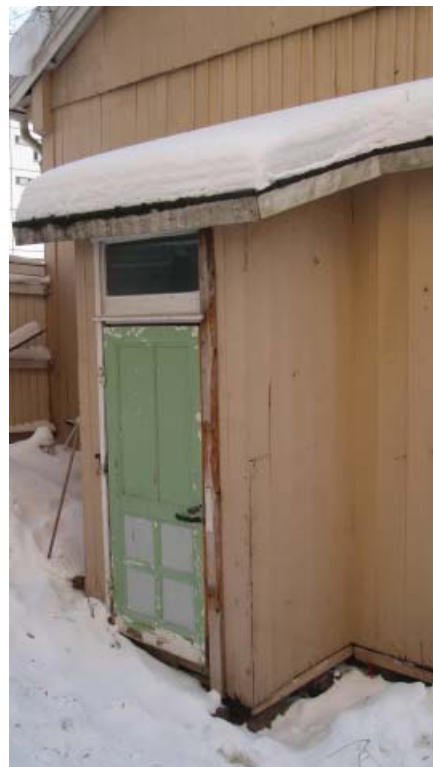
Pohjoispäädyn pikkukuistin sisäänkäynti. Kuva Jussi Laimi.
