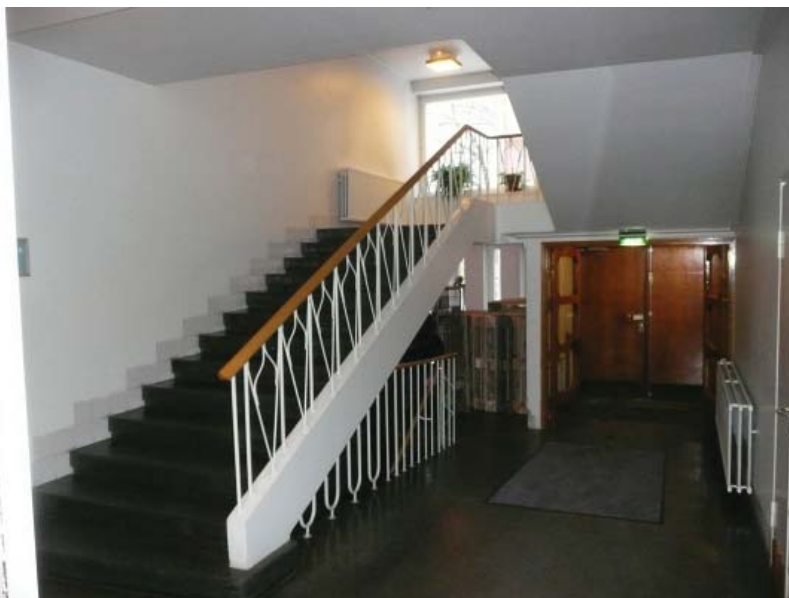
Pääporrashuone pohjakerroksessa. Perällä näkyy ulko-ovi Sirkkalankadulle. Porrashuoneiden pintamateriaalit, kaiteet, ja radiaattorit ovat alkuperäisiä.
