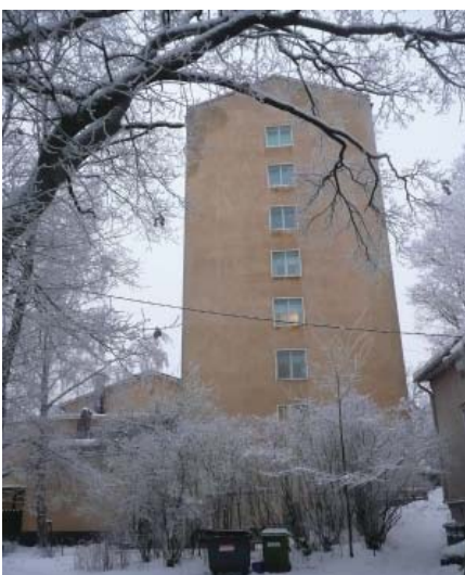
Tornin päätyjulkisivu etelään. Rautalankalasi-ikkunat ovat alkuperäiset.
