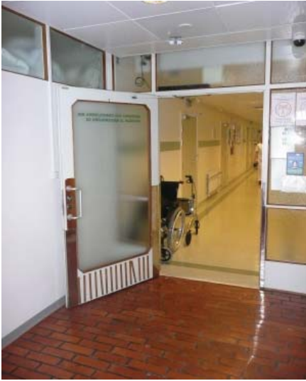
Alkuperäinen lasiseinä ja lasiovi pääaulasta Sirkkalankadun siiven osastokäytävään 3. kerroksessa.
