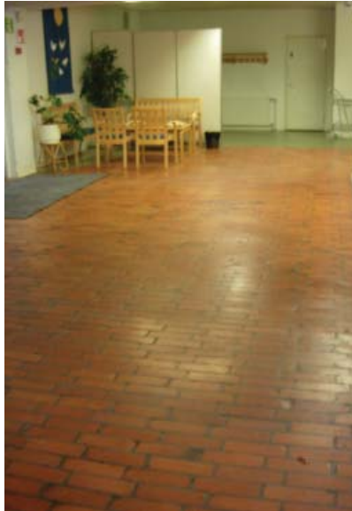
KUVA: yllä Turunmaan sairaalan 1. kerroksen aulan tiililattiaa
