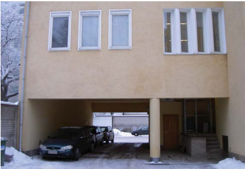
Sirkkalankadun siiven länsipäädyn porttikäytävä pihan puolelta.
