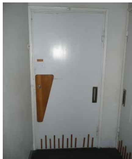
Asuntojen ovet ovat alkuperäisiä.
