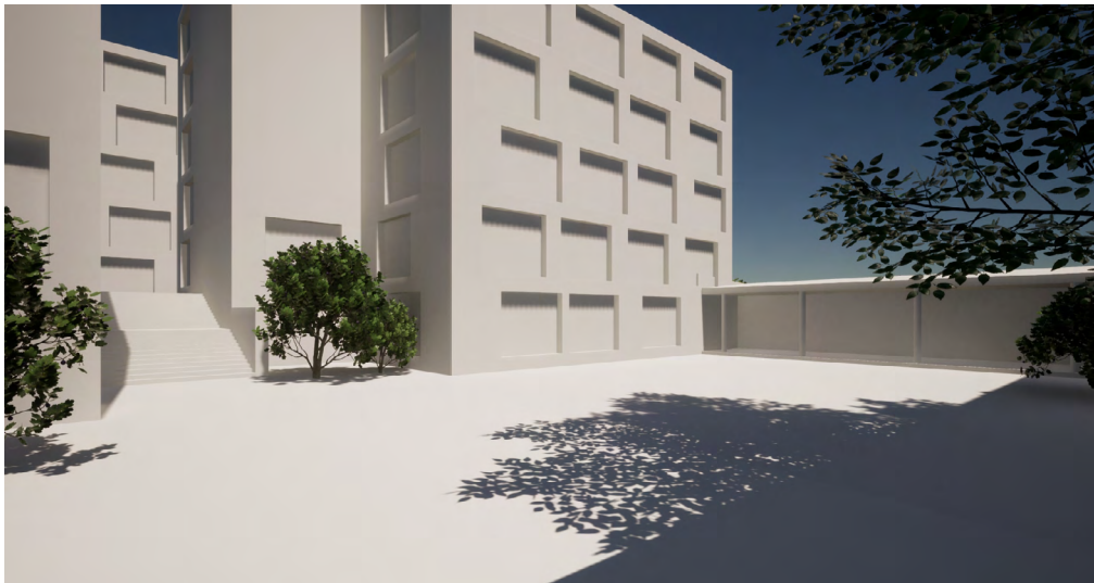
Näkymä tontin 2 pihalta, taustalla koulun entinen aula johon kytkeytyy voimistelusalin paikalle rakennettu uudisrakennus.
