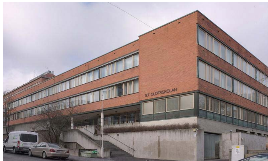
Arkkitehtuuritoimisto Pentti Arolan suunnittelema vuonna 1963 valmistunut St.Olofsskolan (Luostarinkatu 11) arkkitehtuurin aikakaudelle tyypillisiä aiheita ovat tasakatto, nauhaikkuna, betoninen jalusta, kappalemäinen muoto, jossa sisäänvedetty sisäänkäynti sekä pohjakerroksen julkisivuja korostavat kupari-pinnat. Kuva Sara Rönnqvist/SLS/ https://stadsnamn.sls.fi/
