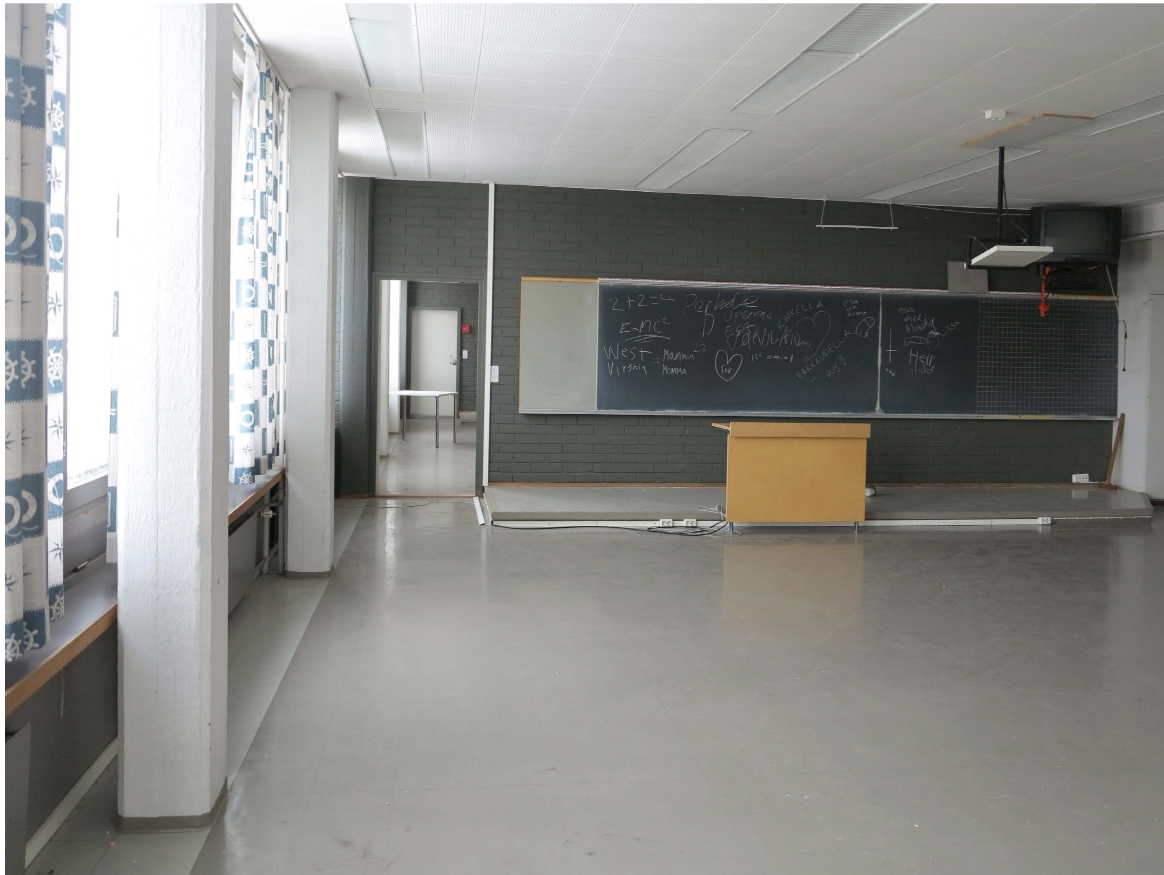
Näkymä ilmeeltään alkuperäisenä säilyneestä luokkahuoneesta. Myös alkuperäinen opettajan koroke sekä liitutaulu ovat säilyneet. Luokkahuoneiden välissä ulkoseinän puolella on tiloja yhdistävät ovet.
