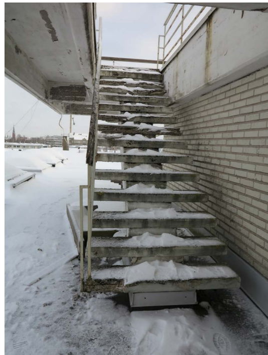
Havaintosillalle johtaa betonirakenteinen avoporras
