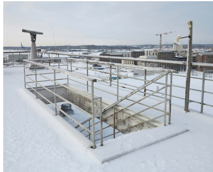
Havaintosillan rakenteet on toteutettu merihenkisin ratkaisuin käyttäen mm laivoilla yleisiä teräskaidetyyppejä.
