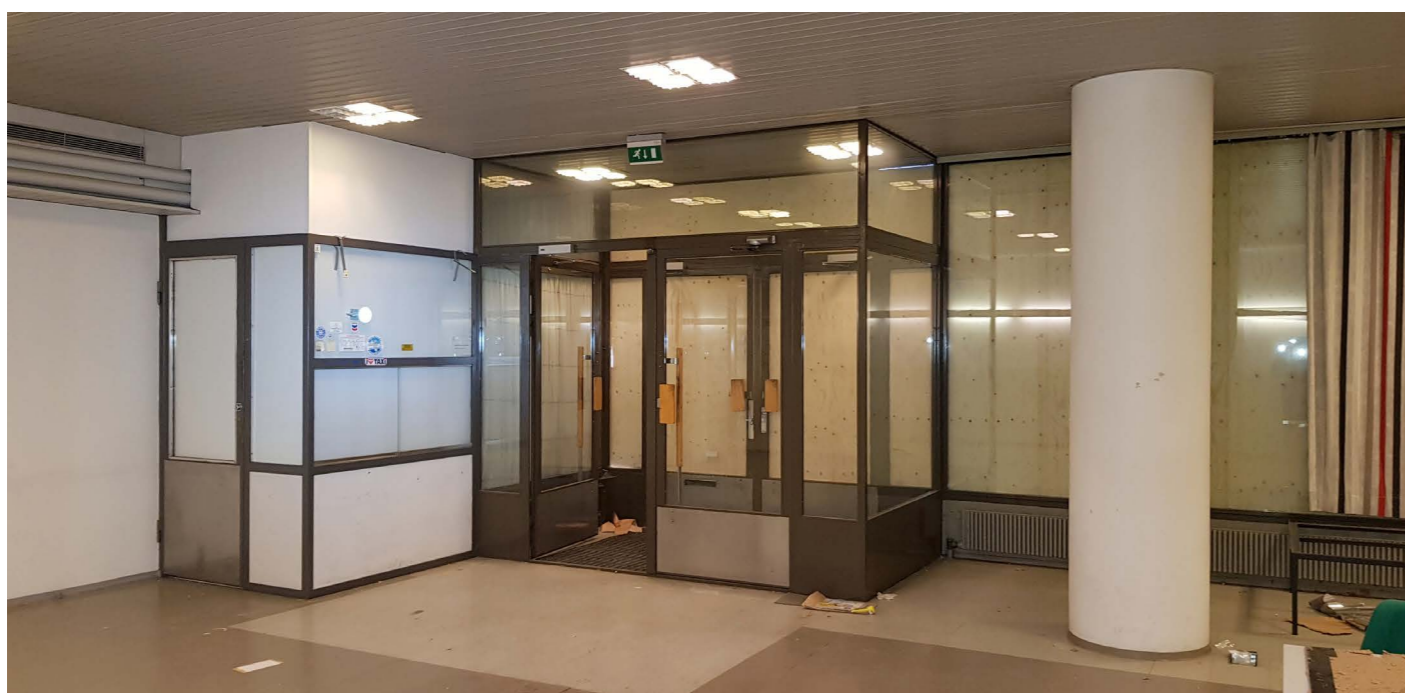
Alahallin takaosassa alkujaan sijainneen naulakon paikalle rakennettiin 1980-luvulla huone vahtimestarille. Ylemmässä kuvassa näkyvä lasiseinän rajattu näyttelytila on myöhempi lisäys.
