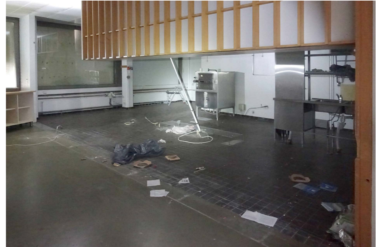
Keskiaulan reunalla sijaitsevan keittiötilan kalusteet ja laitteet on pääosin purettu. Keittiön suuret luoteeseen avautuvat ikkunat on peitetty vanerilevyin.
