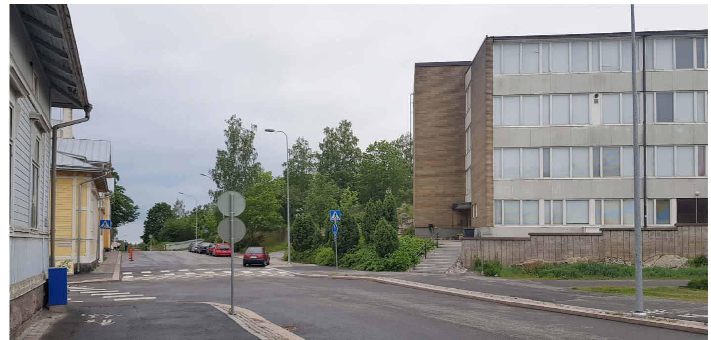
Malminkadun reunalla kallion laella on vanhoja puutaloja sekä Topeliuksen koulun vanhat rakennukset.
