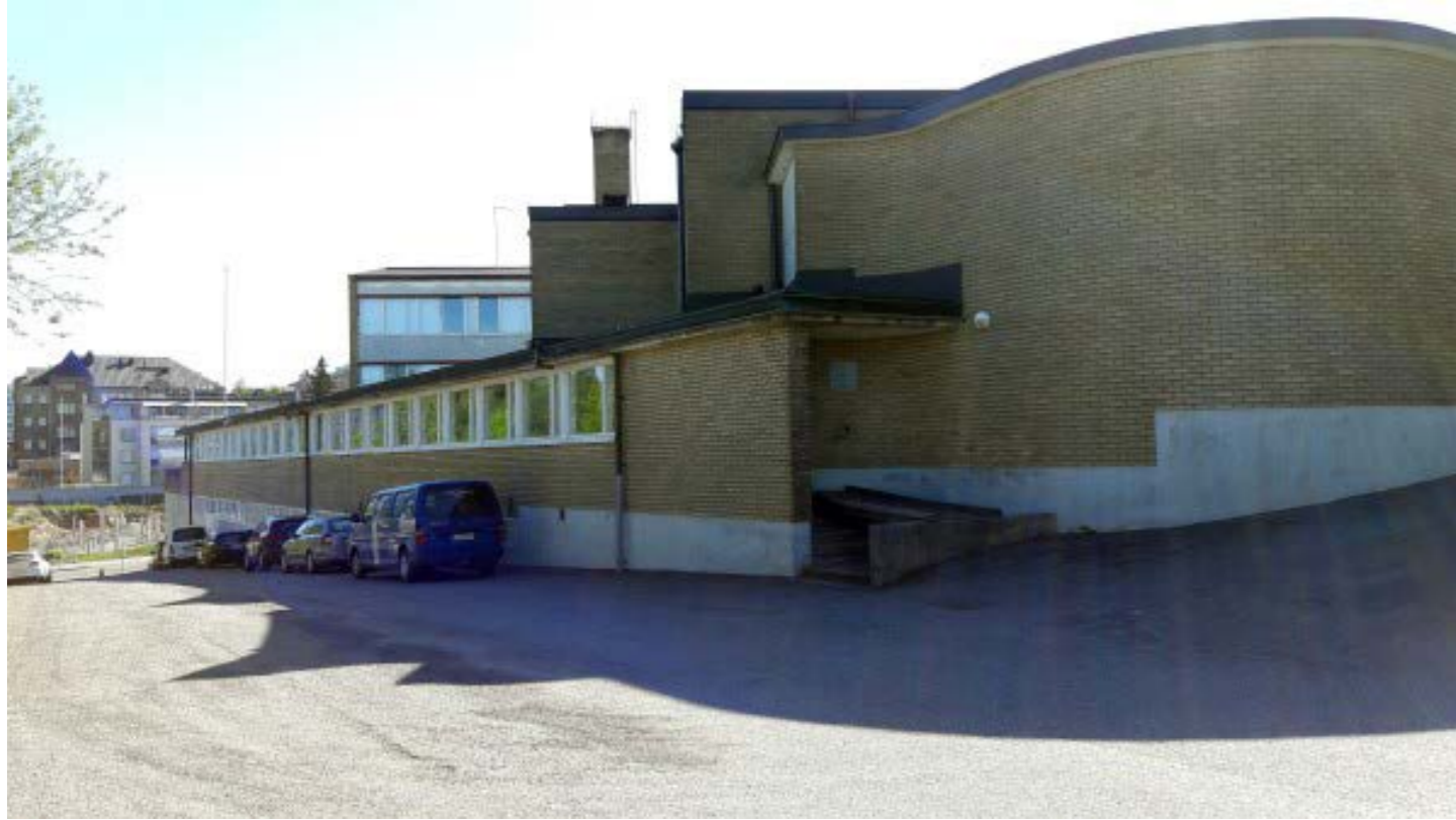
Luoteisjulkisivulla pitkä matala ala-aula muodostaa jalustan jolta toisella reunaa kohoavat voimistelusalin veistokselliset rakennusmassat ja toisella puolella korkea selkeälinjainen luokasiiipi. Kuva Kaarin Kurri/ Turun museokeskus 2018.
