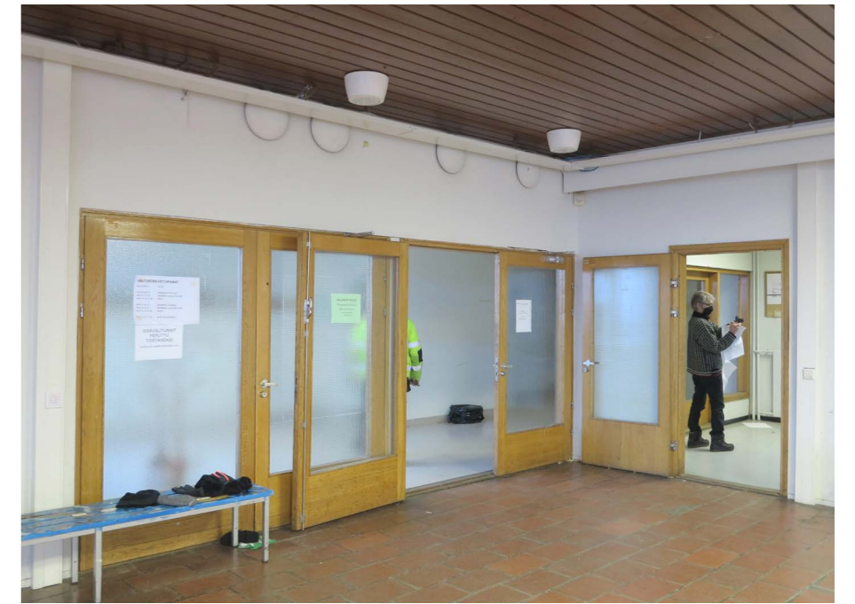
Aulan ja luokkahuonesiiven välissä sekä portaikon suuntaan on alkuperäiset lasiaukolliset tammiovet.
