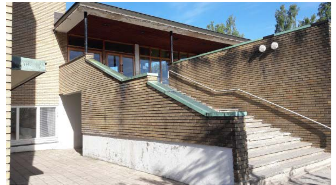
Pääsisäänkäynnin porras kesällä 2018. Sisäänkäynnin edustan katosta kannattavat ohuet teräspilarit. Kuva: Kaarin Kurri/ Turun museokeskus.
