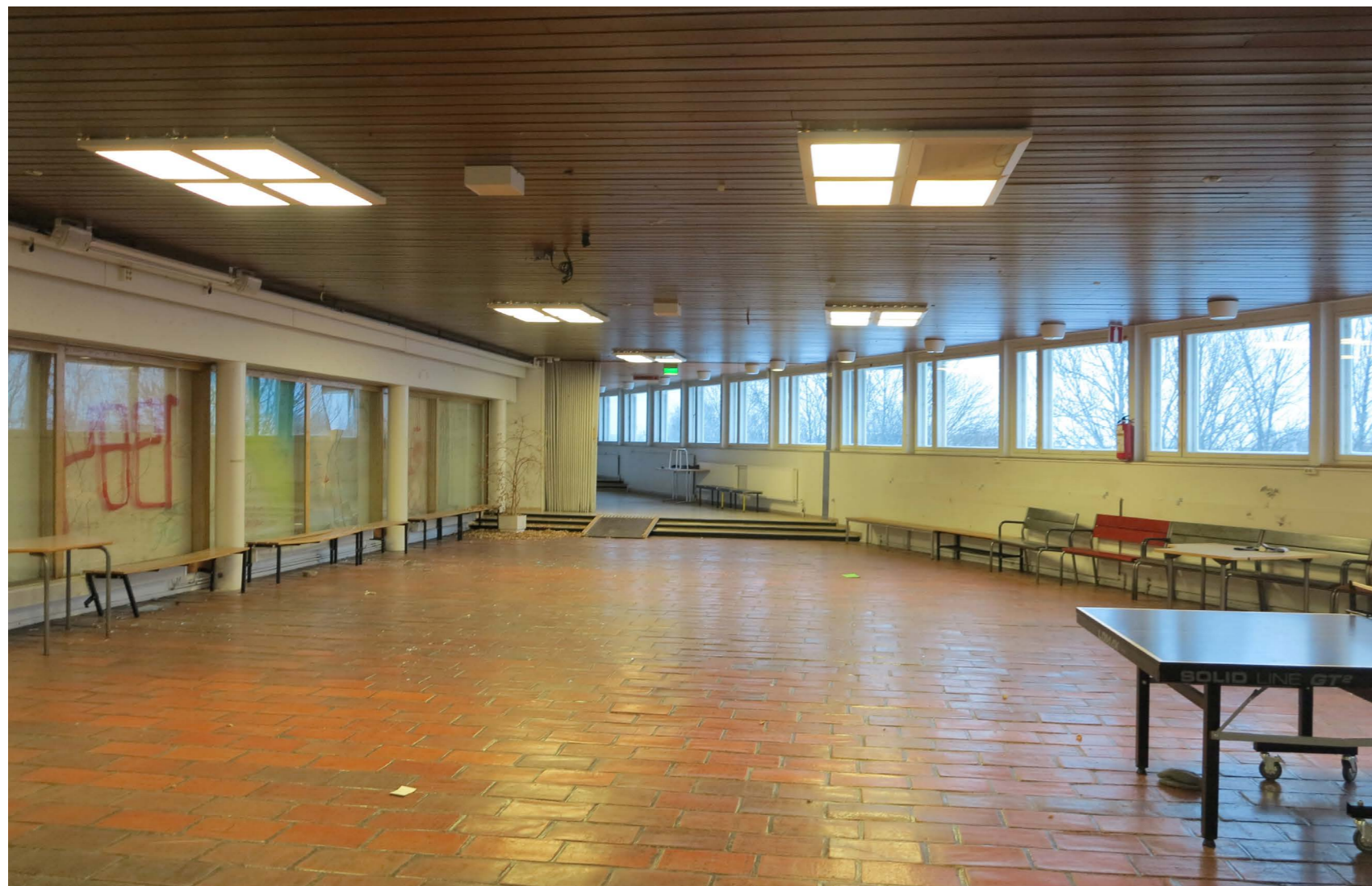
Aula vuonna 2022. Pihan puoleinen ikkunaseinä on ulkopuolelta suljettu levyin.
