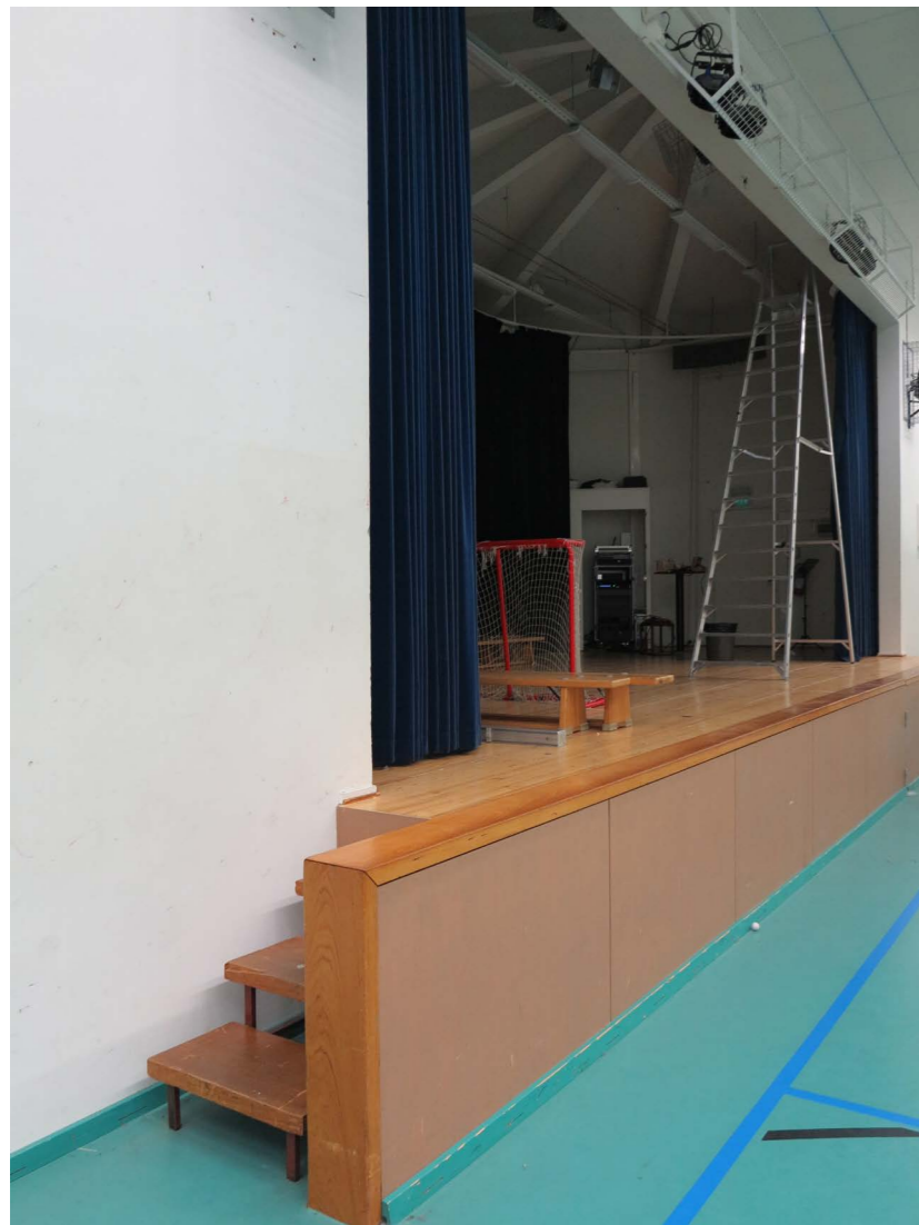
Näyttämön etuseinän rakenteet ovat alkuperäiset.
