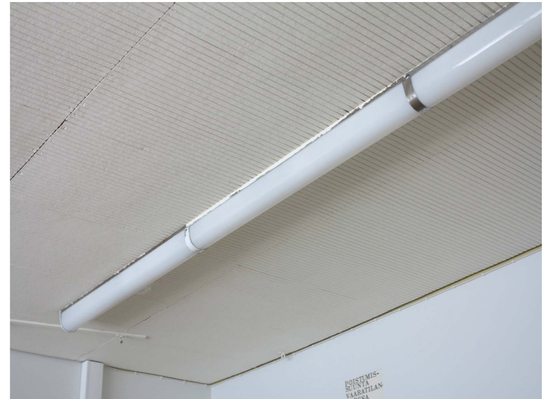
Osassa luokkahuoneita sekä opettajien huoneessa on säilynyt alkuperäinen uritettu Salpalevykatto. Alkujaan ruskea levy on pääosassa tiloja myöhemmin maalattu valkoiseksi. Opettajan huoneessa on säilytetty myös maalaamatonta levyä kuten myös alkuperäisiä loisteputkivalaisimia.
