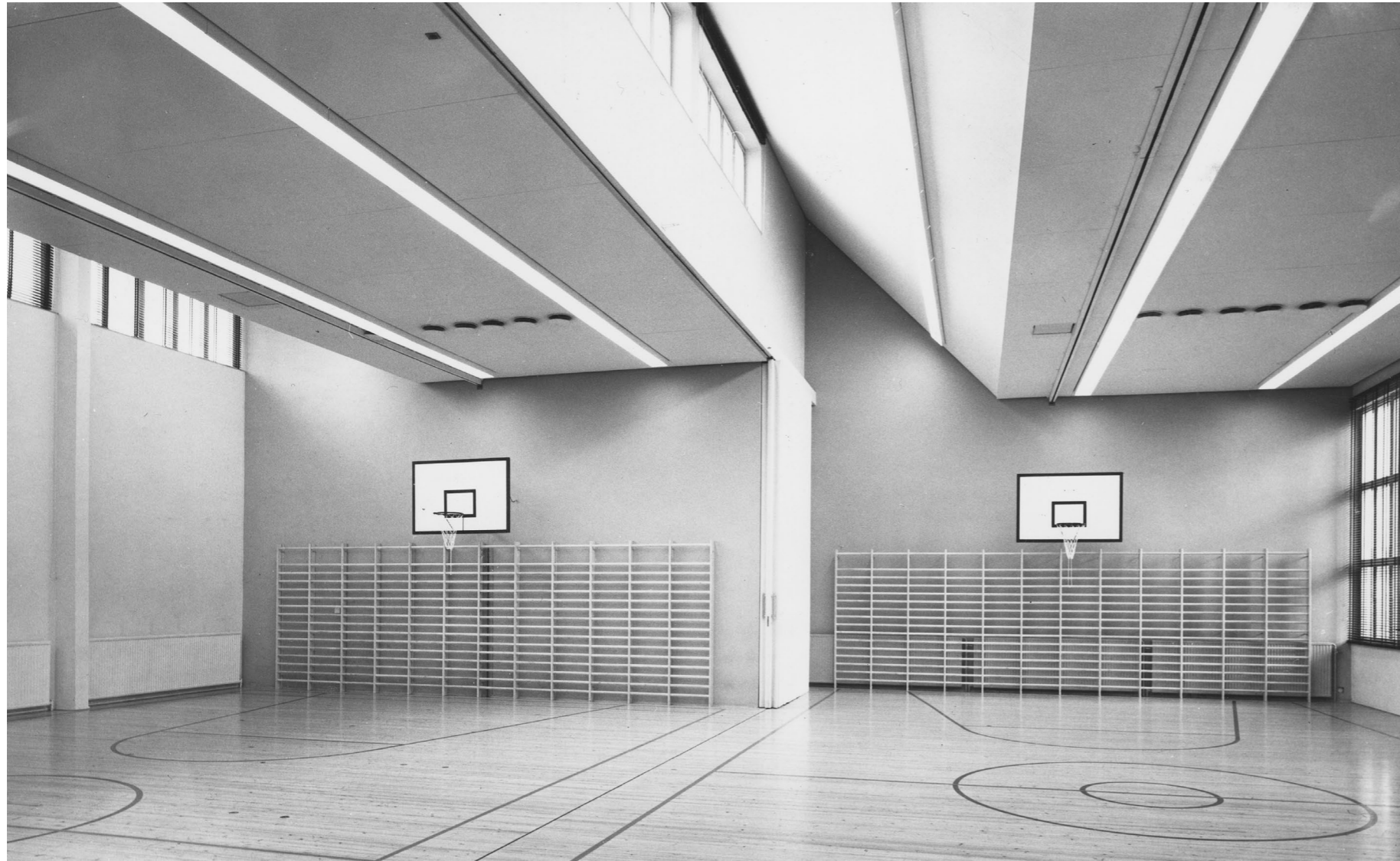
Suuri voimistelusalu on jaettavissa osaan, tyttöjen ja poikien saliksi. Saliin tulee luonnonvaloa yläikkunoista ja näyttämön viereisestä siviikkunasta. Katon loisteputkivalaisimet on sijoitettu kiinni toisiinsa muodostaen yhtenäistä valonauhaa. Vuonna 1960-1961 otetussa kuvassa näkyvä alkuperäinen puulattia, joka on myöhemmin uusittu ja muutettu. Valokuvaaja Rainer Johansson/ AM.
