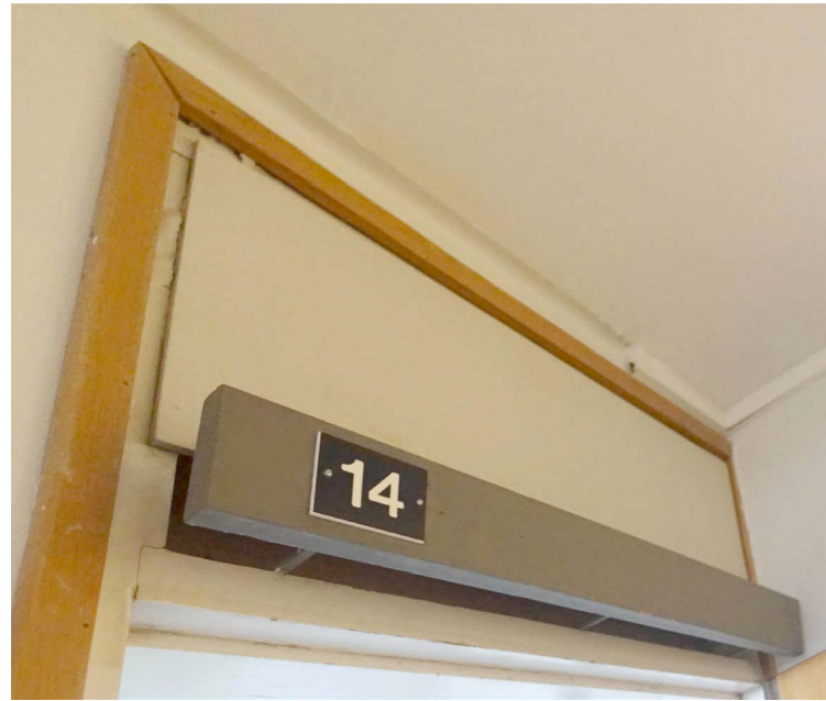
Luokkahuoneiden ovien yläreunassa on alkuperäiseen ilmanvaihtojärjestelmään liittyvä ratkaisu.
