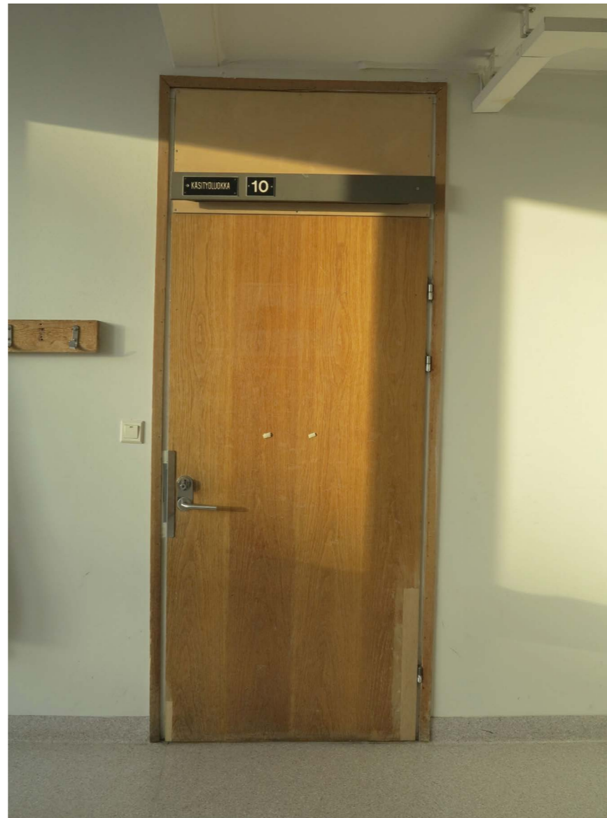
Alkuperäiset viilupintaiset luokanovet ovat säilyneet. Ovissa näkyy kulumisen jälkiä.
