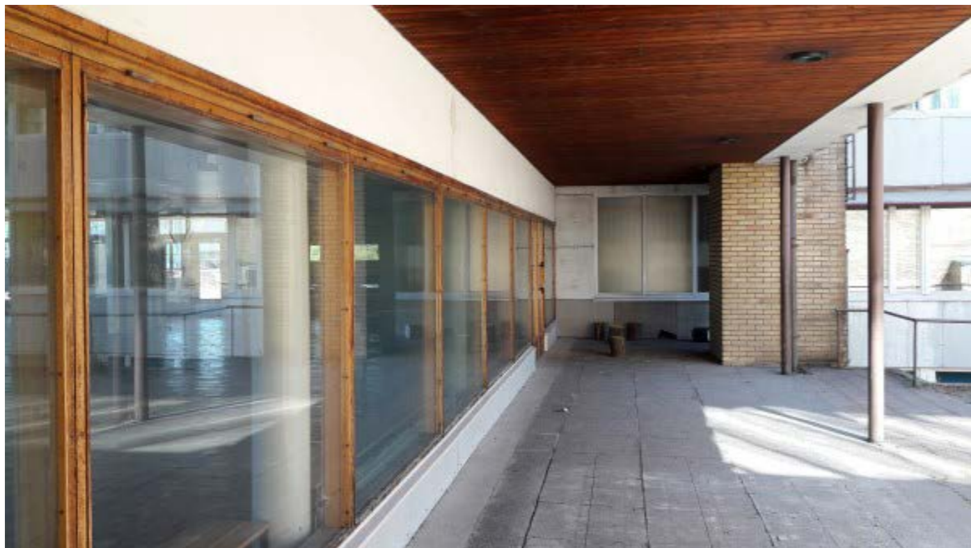
Sisäpihan katettu terassi puuverhoiltune kattopintoineen muodostaa tilallisen jatkumon pääaulalle. Kauniit lakatut tammi-ikkunat ja -ovent ovat alkuperäiset. Kuva Kaarin Kurri/ Turun museokeskus 2018.
