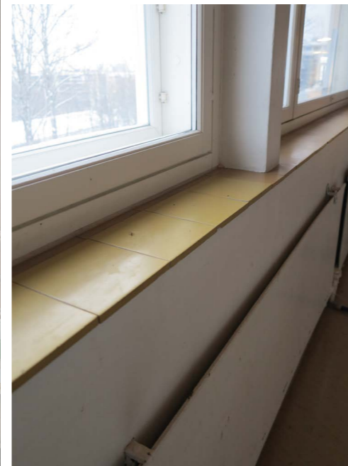
Ikkunapenkki on verhoiltu vaalean ruskeilla keraamisilla laatoilla. Ikkunaseinällä on ohuet levypatterit.
