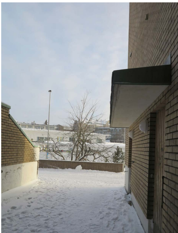
Talon nurkalla sijainneiden käymälöiden ulko-ovien päällä on kapea lippakatos, johon liittyy kuparinen reunus. Taustalla näkyy ala-aulan tamminen ulko-ovi.
