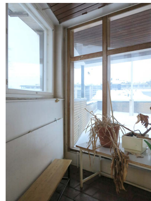
Aulan nurkan yksityiskohta. Puuverhoiltu katto jatkuu ulkopuolella terassin katoksena. Päädyn tammipuitteiset ikkunat ovat alkuperäiset.
