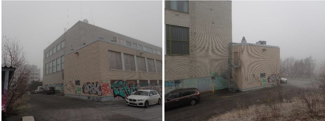
Kuva 5 ja 6. Koillispuolella rakennusta ei alimmissa kerroksissa ole ikkunoita.
