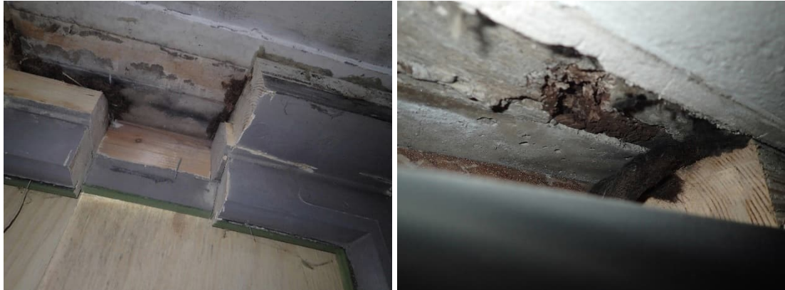
Kuva 40 ja 41. Rakenneavauksesta R14 otettiin näyte N20 puisesta apukarmista ja rakenneavauksesta R15 näyte N20 korkkieristeestä.
