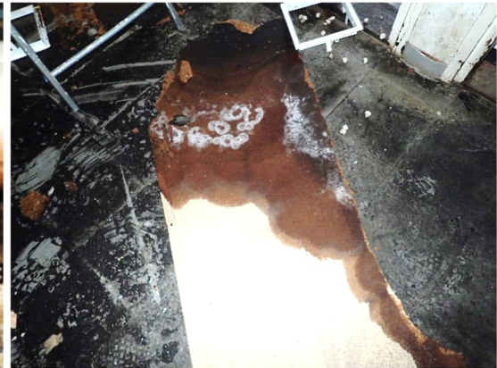
Kuva 21 ja 22. Kattovesiviemäri on vuotanut pitkään ja vuotovesi on aiheuttanut runsaasti kosteus- ja mikrobivaurioita. Oikeanpuoleinen kuva on vuotaneen kattovesiviemäriin kohdalta lattialta.
