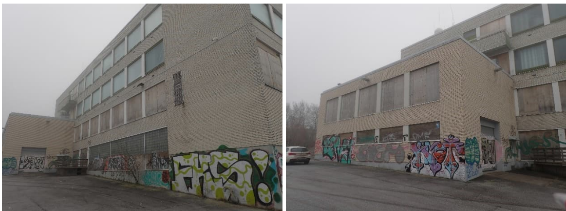
Kuva 3 ja 4. Luoteen puolen alimmat ikkunat on myös suojattu.
