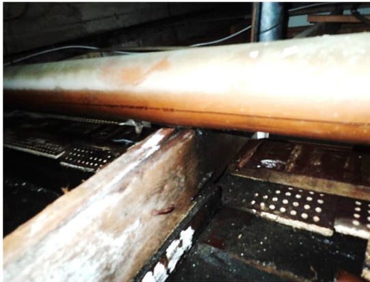
Kuva 21 ja 22. Kattovesiviemäri on vuotanut pitkään ja vuotovesi on aiheuttanut runsaasti kosteus- ja mikrobivaurioita. Oikeanpuoleinen kuva on vuotaneen kattovesiviemäriin kohdalta lattialta.
