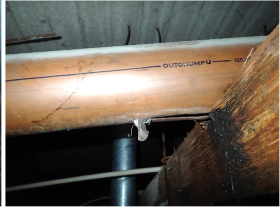
Kuva 19 ja 20. Haljennut viemäri neljännen kerroksen alakaton taustalla.
