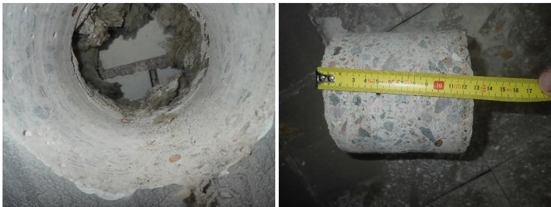
Kuva 34 ja 35. Mikrobimateriaalinäytteet N7 – N16 otettiin mineraalivillaeristeiseen ulkoseinään tehdyistä rakenneavauksista R1 – R10.
