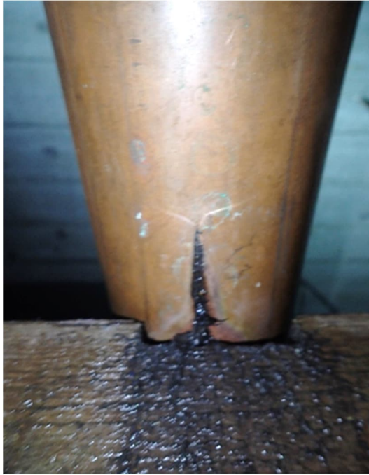
Kuva 19 ja 20. Haljennut viemäri neljännen kerroksen alakaton taustalla.
