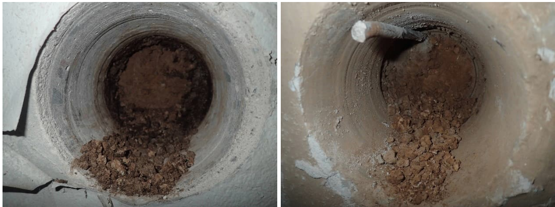
Kuva 38 ja 39. Kellarikerroksen ulkoseinissä oli rakenneavauksissa R12 ja R13 eristeenä korkkia.
