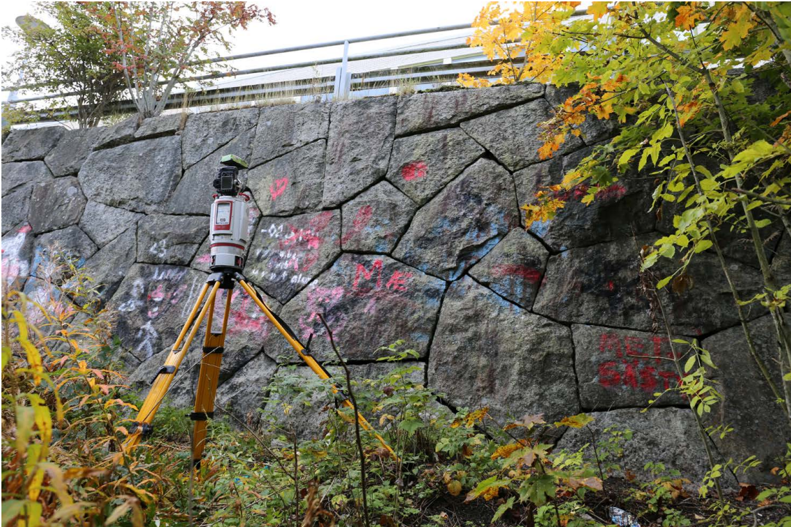
Kuva 8. Muurin luoteislaita on paikoin yli kolme metriä korkeaa, hyväkuntoista kylmämuurat- tua muuria. Koillisesta. 23.9.2022. J. Leppänen. (MuTu122061Dg_5).
