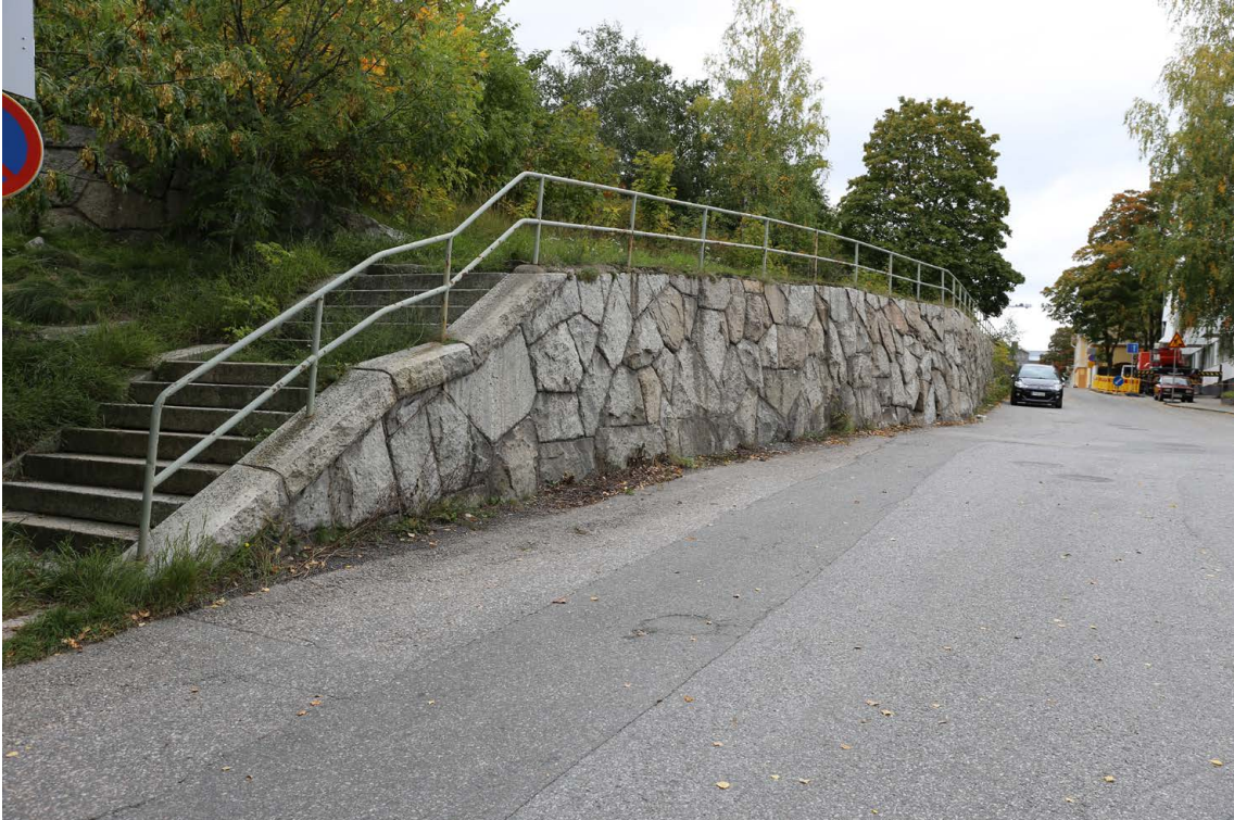
Kuva 13. Muurirakenteen kaakkoislaita on Malminkadun laidassa. Rakenteen sisäpuolella on jalkakäytävä. Etelästä. 23.9.2022. J. Leppänen. (MuTu122061Dg_10).
