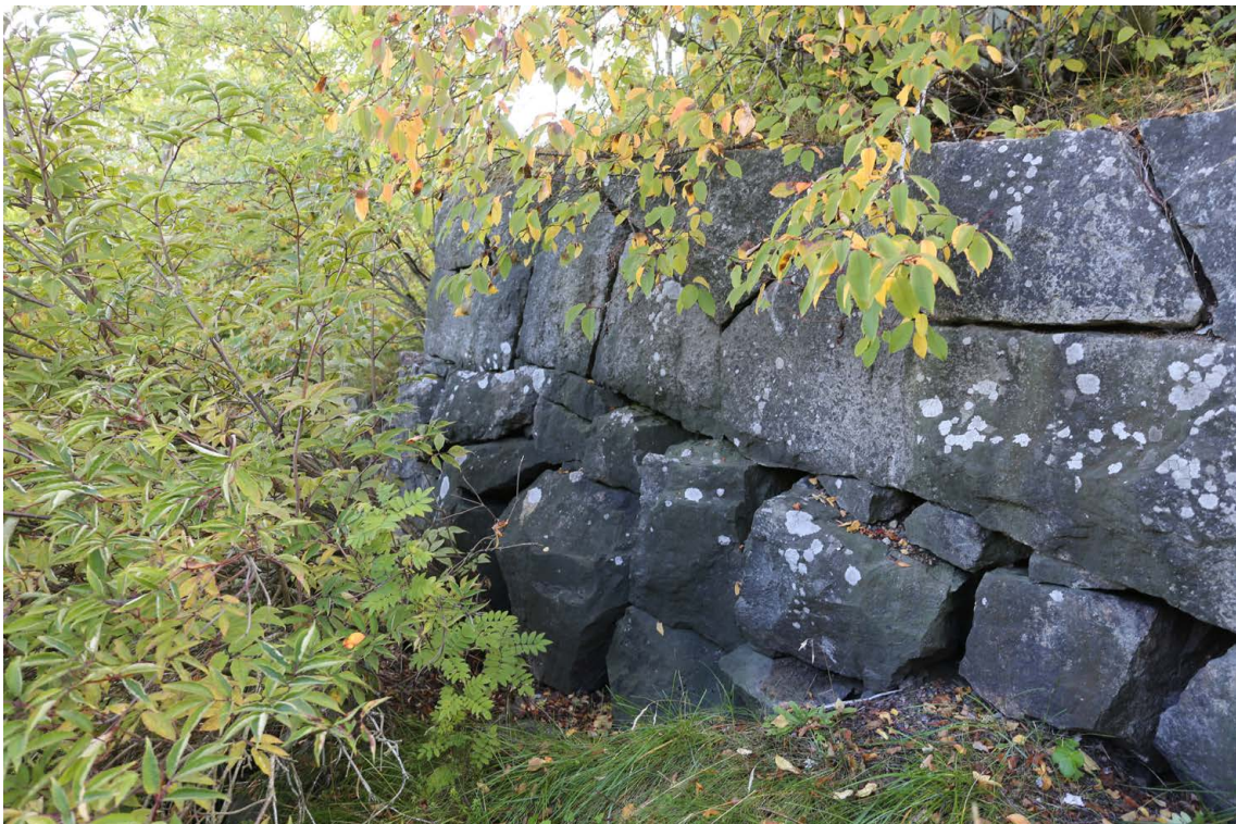
Kuva 7. Muurirakenteen länsikulmalla on siistiä kivoilatomusta yksi tai kaksi kivikertaa, ja tä- män alla on karkeampaa latomusta. Lounaasta. 23.9.2022. J. Leppänen. (MuTu122061Dg_4).
