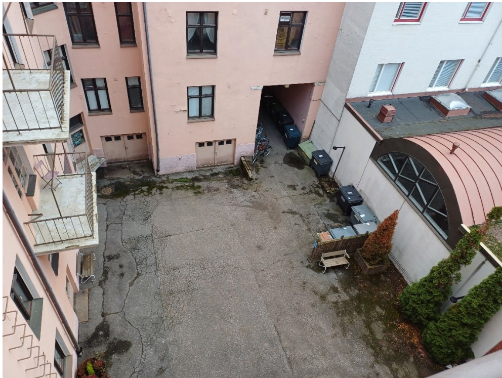
Kuva 3. Näkymä rakennuksen sisäpihalle tuuletusparvekkeelta. (valokuva 2023, Laura Virkki)
