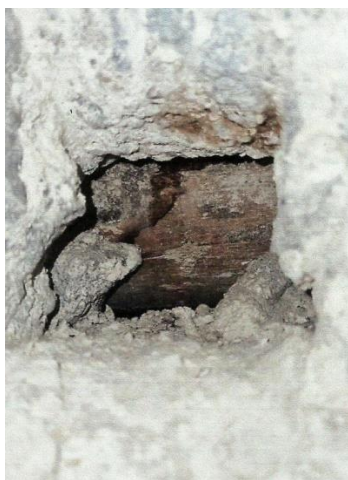
Kuva 10. Muottilautoja ulkoseinärakenteessa, CONTRO Oy , 18.12.2020
