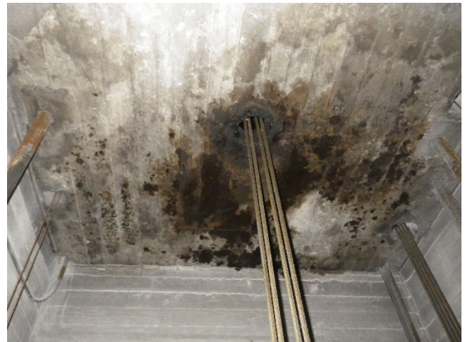
Kuva 8. Hissikonehuoneen lattia alhaalta kuvattuna.
