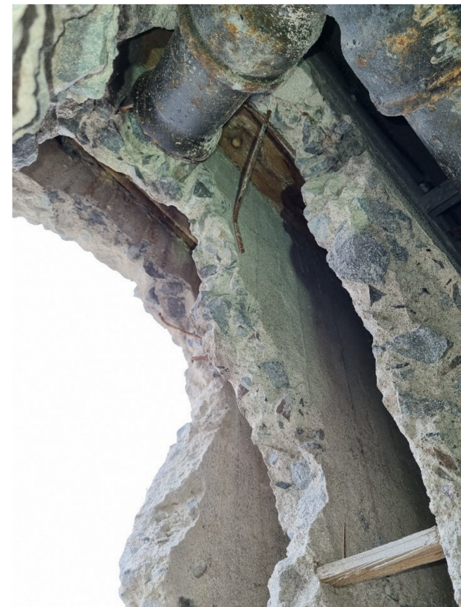
Kuva 28. Ulkoseinän ontelorakennetta kellarikerroksessa, jossa ylhäällä muottilautoja.
