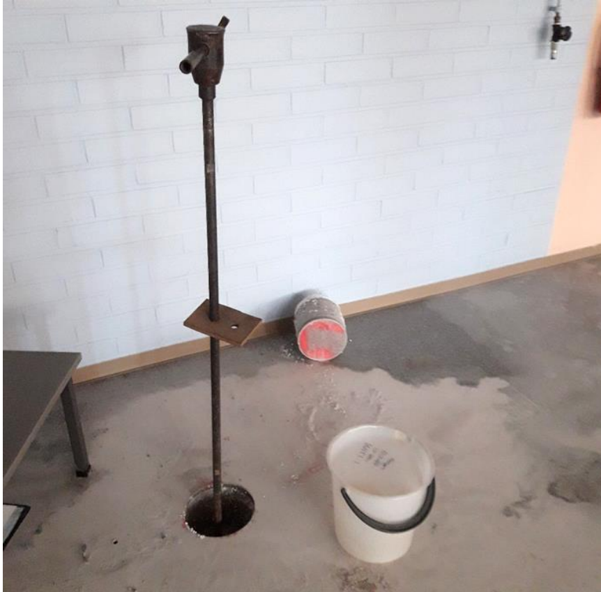
Kuva 5. Rakennusten alapuolelta otettiin näytteet hyödyntäen käsikairaa ja rakenteiden haitta-ainekartoituksissa tehtyjä porattuja reikiä. Kuvassa näytepiste R7.
