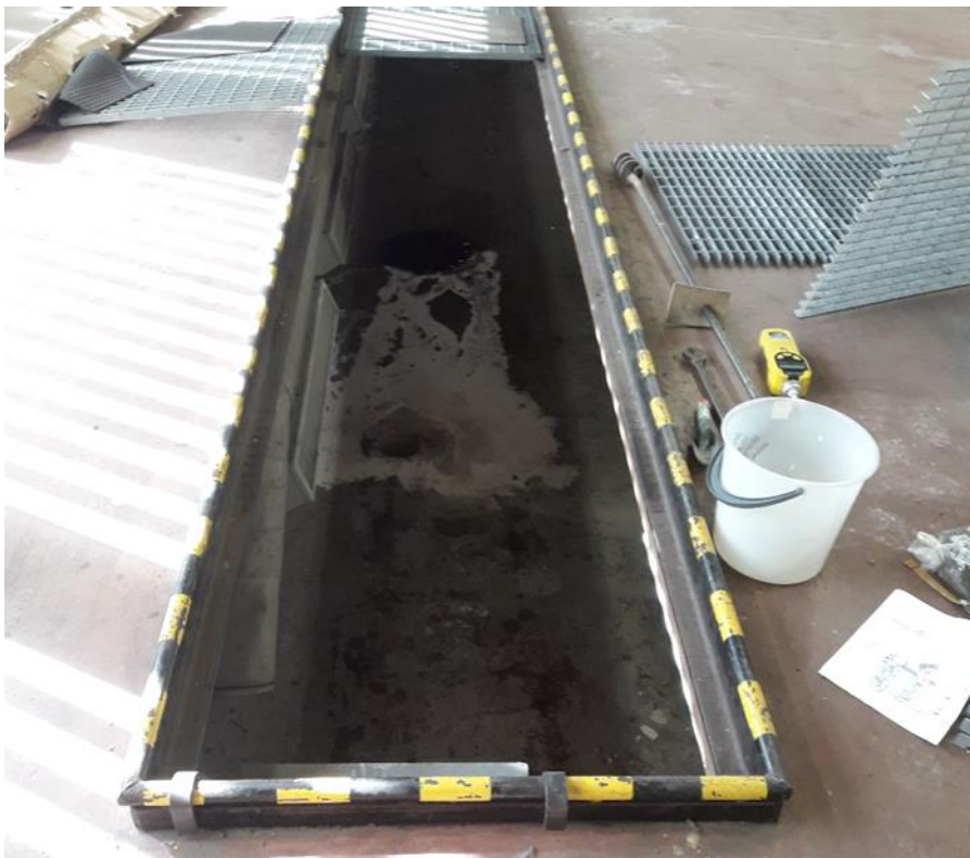
Kuva 6. Rakennusten alapuoliset näytepisteet pyrittiin sijoittamaan tunnistettuihin riskikohteisiin. Kuvan rasvamontun pohjalla on näytepiste R8.
