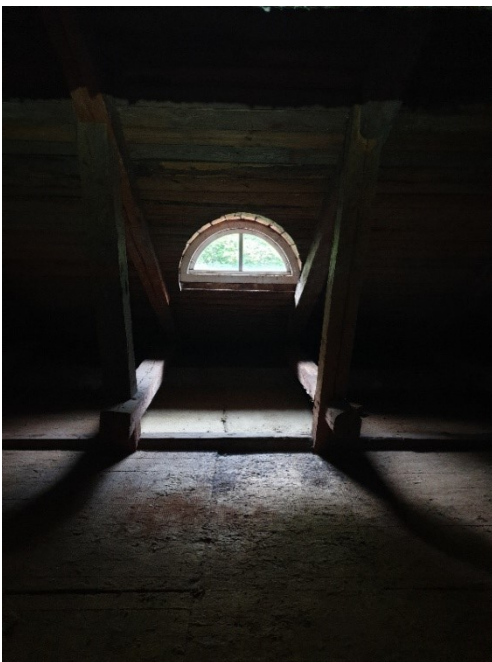
Kuva 2.3. Ullakko oli siisti ja helposti tutkittavissa. Merkkejä lepakoista ei kuitenkaan löytynyt.
