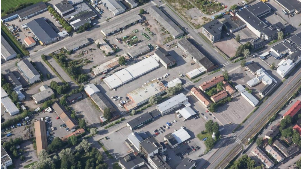
Kuva 3.1.1.1: Artturinkadun alue nykytilassaan etelästä nähtynä.
