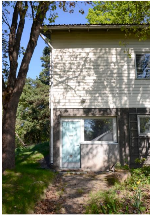
Vas.: Vanhan toimisto-osan pääsisäänkäynti rakennuskonakaisuuden keskellä olevassa nivelosassa. Oik.: Siipiosan sivu Ilpoistentien suuntaan. Kellarikerroksen autotallin pariovet on korvattu yksilehtisellä ovelta ja ikkunalalla.
