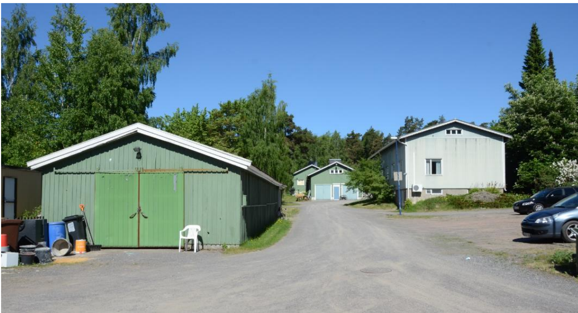
Vasemmalla lämpökeskus- ja varistorakennus, keskellä talousrakennus 1:n (1938) pääty ja oikealla konttori- ja huoltorakennuksen ruokala- ja sosiaalitilasiipi.
