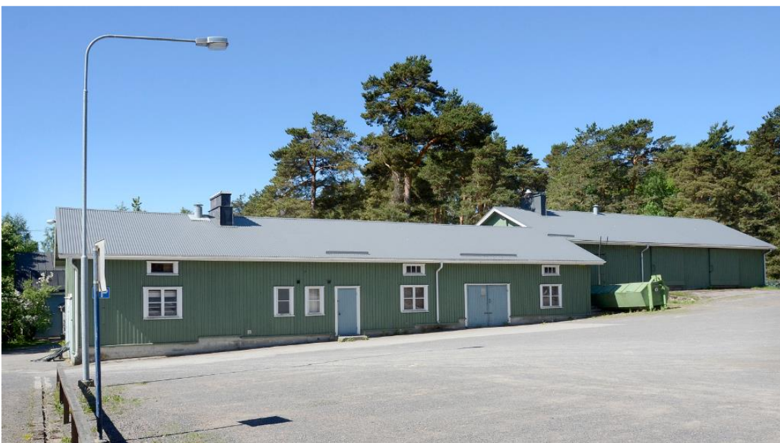
Talousrakennus 1. Vanha osa vuodelta 1938 vasemmalla, 1950-luvun laajennusosa oikealla.
