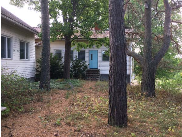
Entinen kaupunginpuutarhurin asunto (vas.) ja toimistorakennus.
