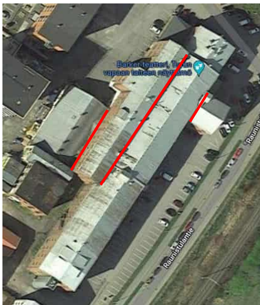
Kuvat 13. Punaisilla viivoilla on osoitettu kohdat, joissa kattopinnat kallistavat viereisille seinäpinnoille ja joissa havaittiin kosteusjälkiä tai vuotoja. Kuvan lähde: Google maps.
