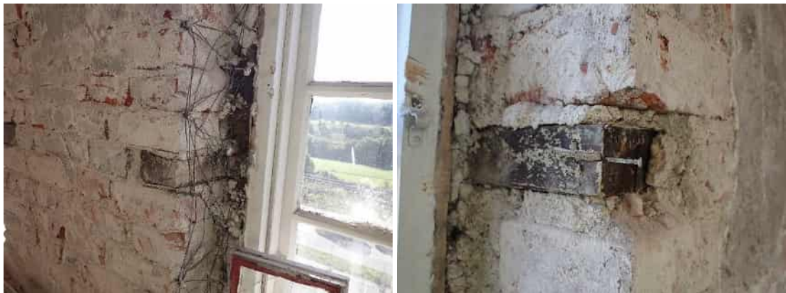
Kuvat 3 ja 4. Ulkoseinärakenteen sisällä on puuta ikkunoiden kiinnitystä varten.
