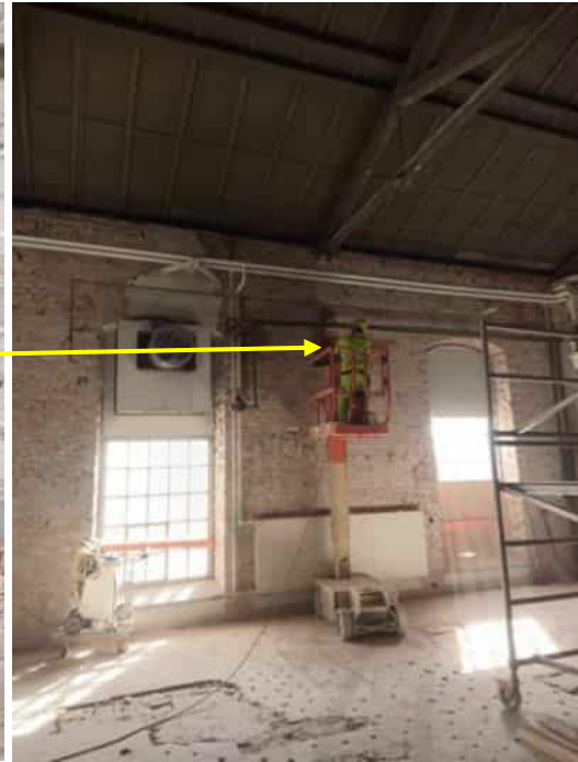
Kuva 7. Öljyisiä läikkiä oli eri korkeuksilla (kuvassa LIS1), jossa todettiin korkeita pitoisuuksia vielä 300 mm syvyydellä.
