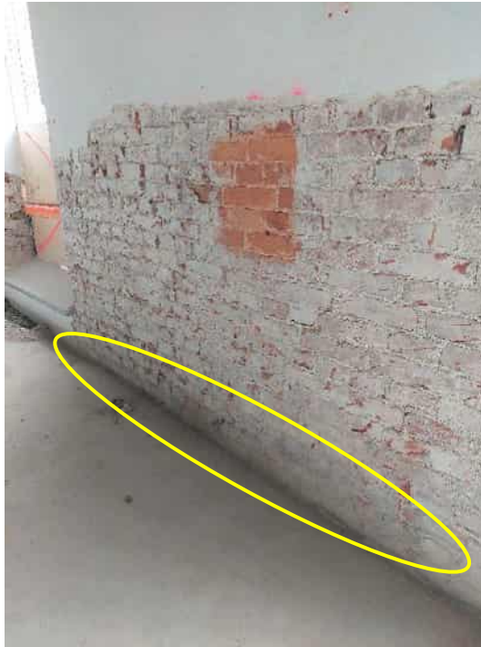
Kuva 4. Seinän alaosa, jossa on öljyhiilivetypilaantuneisuutta F4, 4. krs. Kohdasta otettiin lisänäyte 2, jossa todettiin sisäilmariskiä aiheuttavia pitoisuuksia vielä 150 mm syvyydessä. Näyte LIS2.
