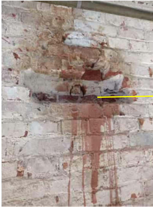
Kuva 6. Lohkon F4 4. kerroksessa havaittiin eri korkeuksilla joitain kellertäviä läikkiä, jotka haisivat selkeästi öljylle.
