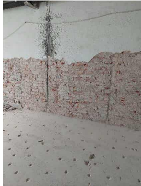
Kuva 5. Vastaavaa tummumaa ei havaittu kaikilla tiilipinnoilla, lohko F4 4. krs. Öljyhiilivedyt eivät kuitenkaan aina ilmene silmin nähtävinä läikkinä.
