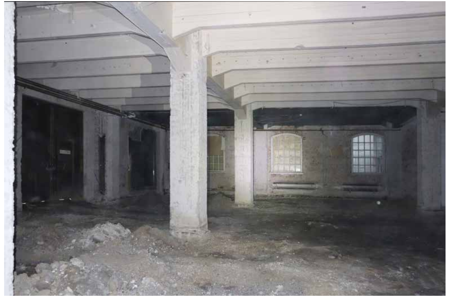
Betonirakenteista välipohjaa kannattavat betonipalkit ja -pilarit. Lattia on purettu.
