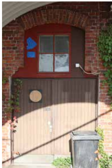
F8 -osan kaksi ulko- ovea ovat ainoat ovet, joita ei ole peitetty levyillä. Vasemmalla porrashuoneen ovi, jossa oviaukkoa on suurennettu, oikeanpuoleinen ovi on sijoitettu ikkuna-aukon kohdalle.
