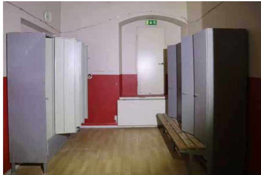
2. kerros nurkkahuoneen ikkuna on muurattu umpeen ja paikalla on F12 osan katolle johtava poistumistie ovi.
