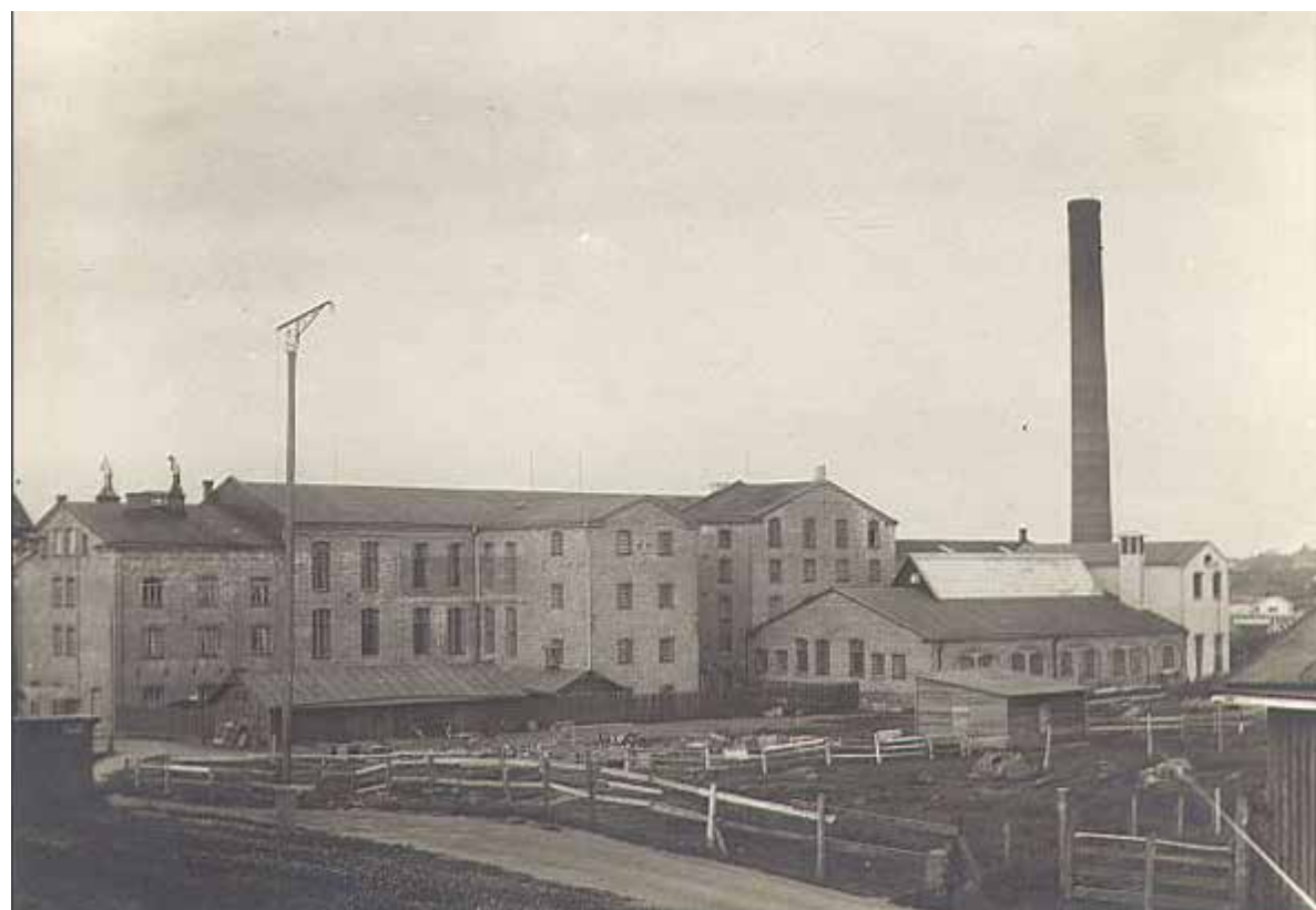
Valokuva pohjoisesta vuonna 1909, valokuvaaja tuntematon. F4 osaa on korotettu, F8 osa on lisätty, F5 osaa on madallettu, F2 -osaan on lisätty kattoikkuna. Åbo Akademi bildsamlingar/Finna
