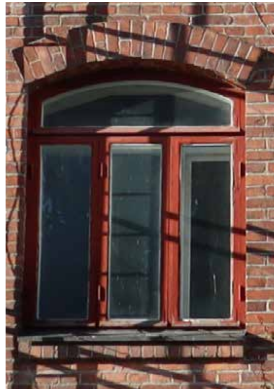
F8-osassa oli jo alkujaan yläikkunalla varustetut pystyjakoiset puuikkunat. Kuva päädyn 2.kerroksen ikkunasta.
