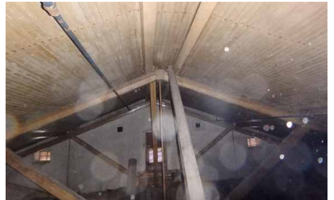
Katto-ontelo F2-osan koillispäädystä. Insinööritoimisto Lauri Mehto 2019
