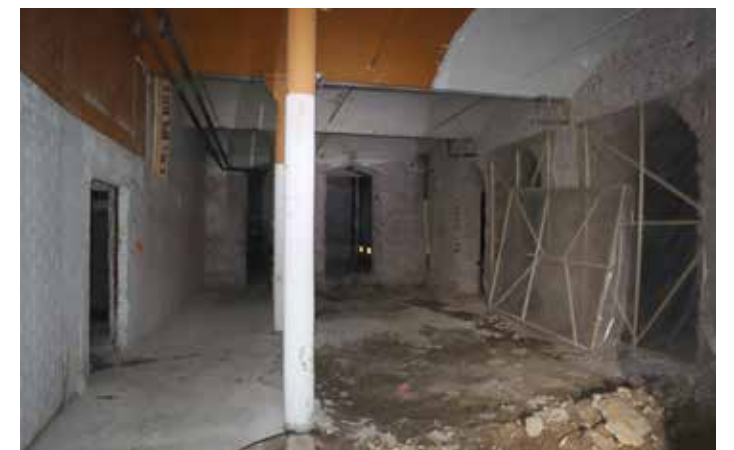
Osan F5 pohjakerroksen teräspilarein tuettu kappaholvikatto
