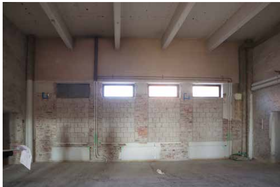
2.kerroksen ulkoseinän muurauksessa erottuvat myöhemmät ikkunamuutokset.
