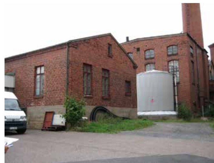
Tehtaan vanhimpiin rakennuksiin lukeutuva punatiilinen F10 muuntaja-asema vuonna 2006. Kuva TMK/ Sanna Kupila.
