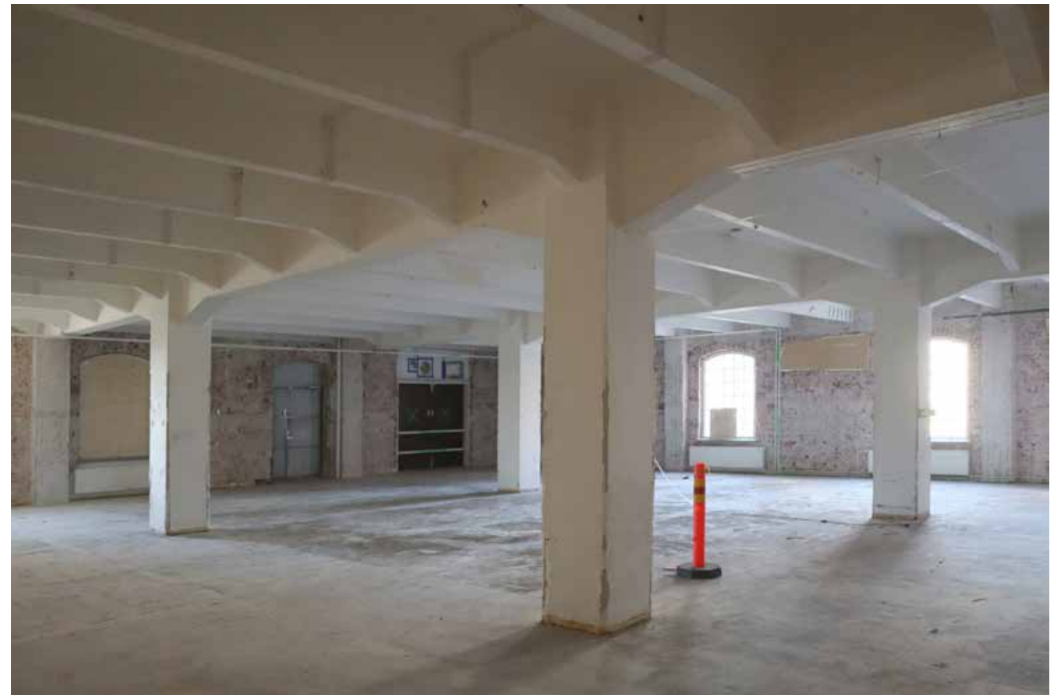
Tilaa hallitsee massiiviset betonipilarit ja palkistot.
