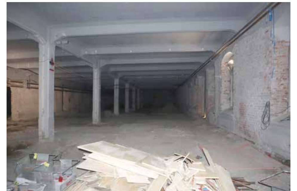
F4 salin luoteisseinällä olleet aiemmat ikkunat on avattu suuriksi holvatuiksi oviaukoiksi.
