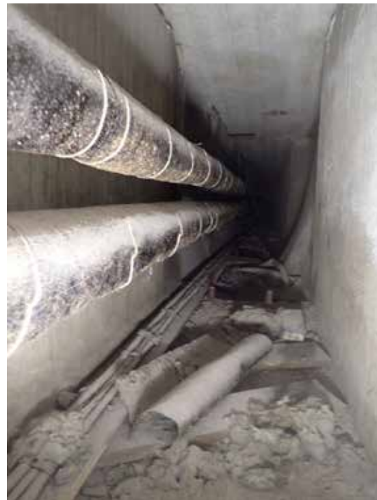
Valokuvia lattian alapuolisesta kanavistosta. Insinööritoimisto Lauri Mehto 2019
