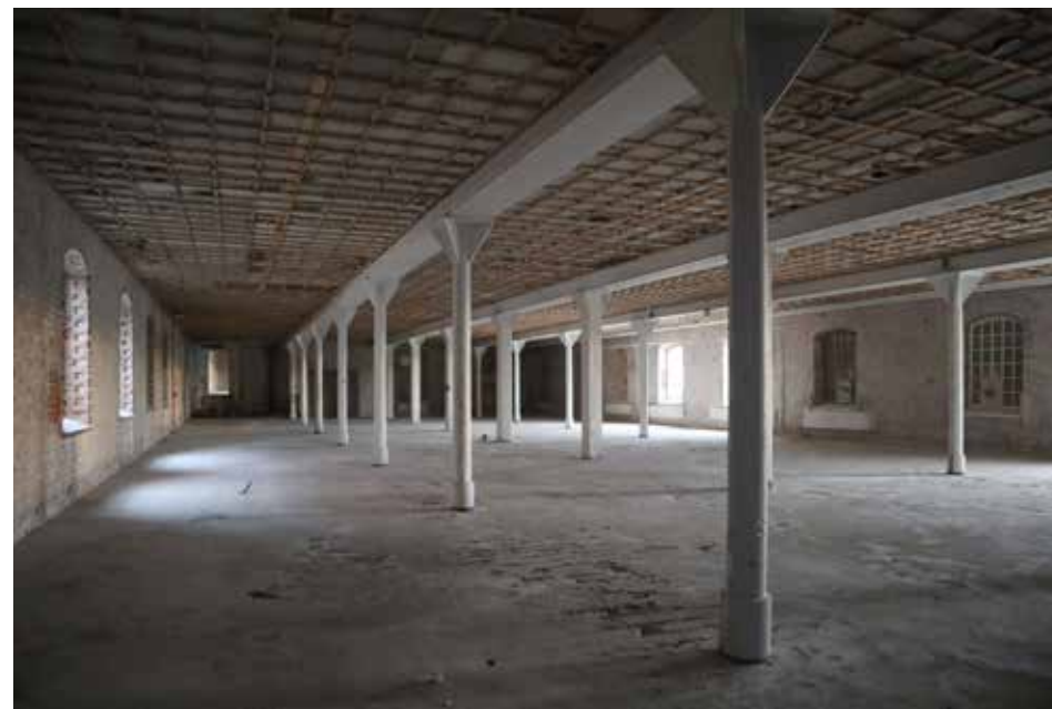
Ksekilinjalla pilarit ovat neliskulmaisia, muualla pyöreitä.
