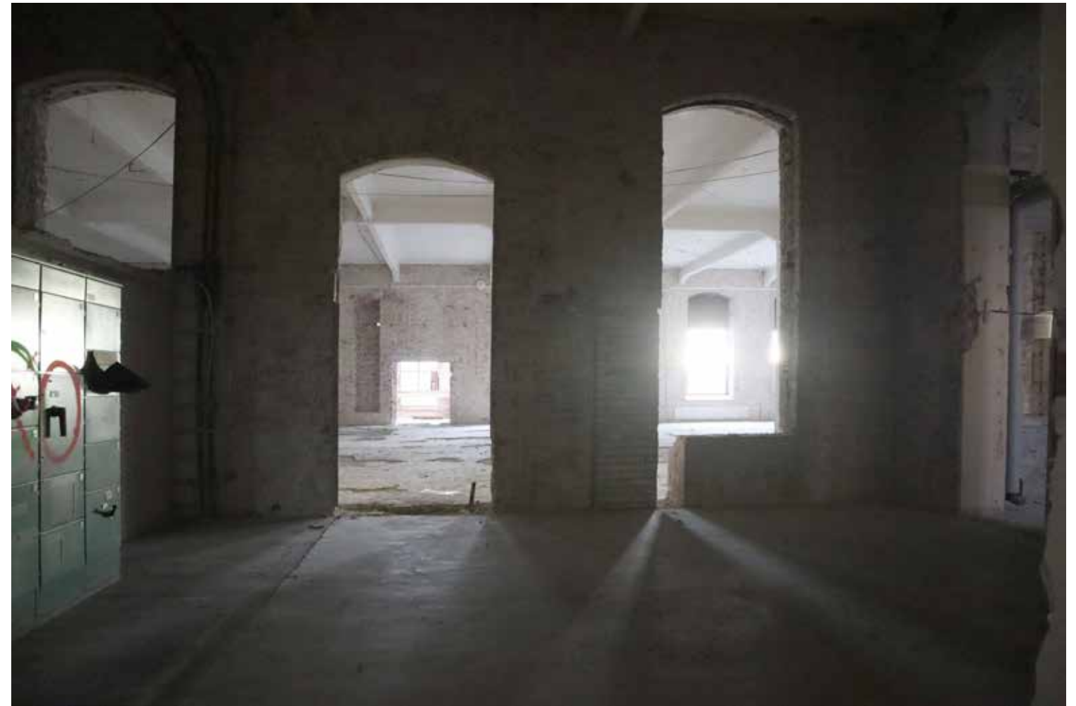
2. kerroksessa F7-tila avautuu korkeina holvikaariaukkoina F4 tilan suuntaan.
