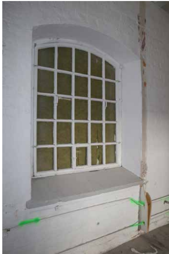
F5 osan ikkunaan liittyy syvät viistetyt smyygit.
