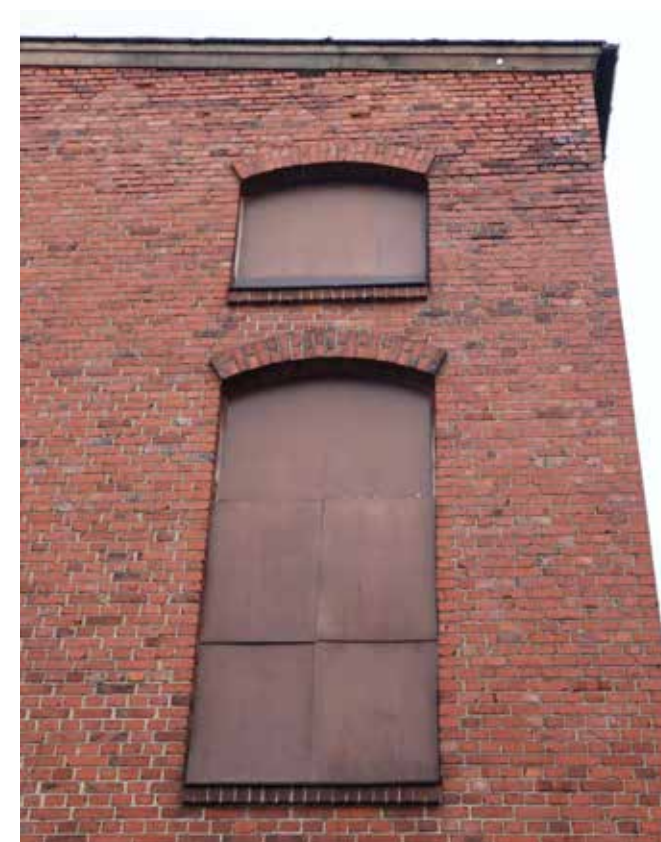
Pannuhuoneen F17 julkisivuissa on korkeat ikkunat joiden päällä erilliset yläikkunat. 1943 rakennetussa laajennuksessa toistuvat rakennuksen vanhimille rakennusosille tyypillisinä yksityiskohtina korkeat holvikaari-ikkunat. Satulakaton muoto on vanhempia osia selvästi loivempi.
