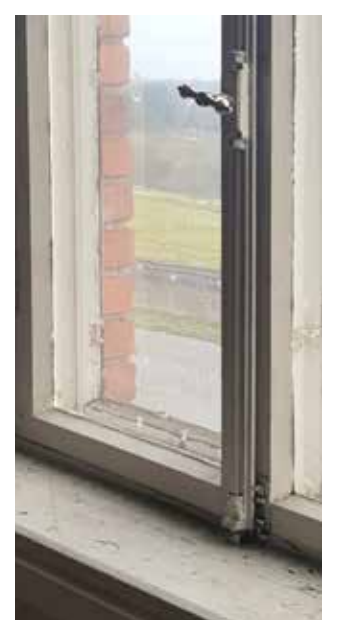
F8 osan ikkunoissa on vanhat espanjoletti-salvat.
