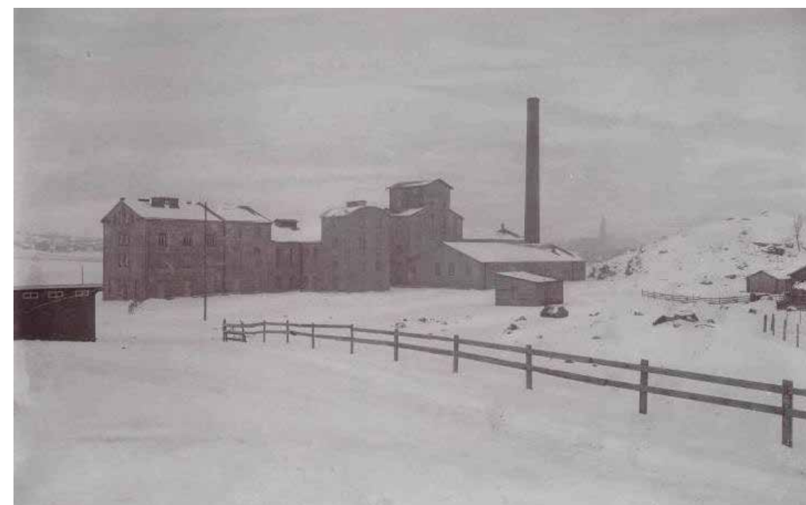
Tehdasrakennus ennen vuoden 1906 muutoksia. F5 osaan liittyy myöhemmin purettu korkea osa. F7 osaan katto on kaarevamuotoinen. Tuntematon valokuvaaja. Turun museokeskus/Finna
