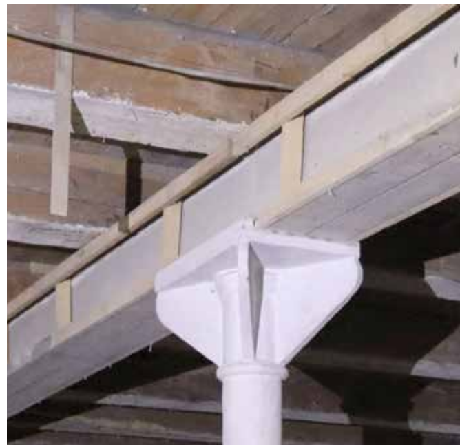
Teräspalkin ja palkiston liitos.
