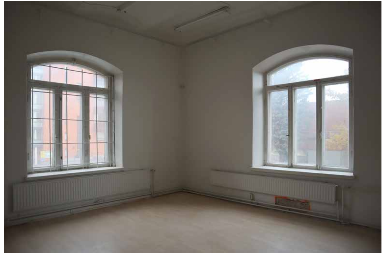
2. kerros pohjoisnurkan huoneen lattiapäällysteenä on laminaatti, F12 osan katon suuntaan avautuvan ikkuna-aukkoon on asennettu kalteri. Katossa on näkyvillä kappaholvi.
