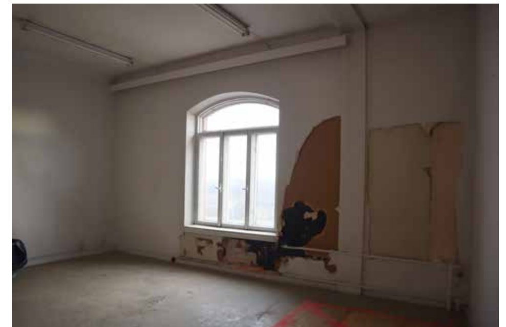
Itäkulman huoneessa, on säilynyt vanhempia pintarakenteita.
