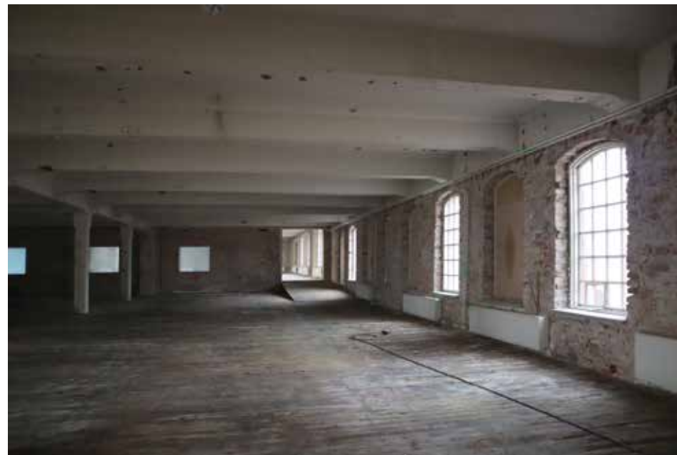
Ikkunoita luoteeseen avautuvalla seinällä.
