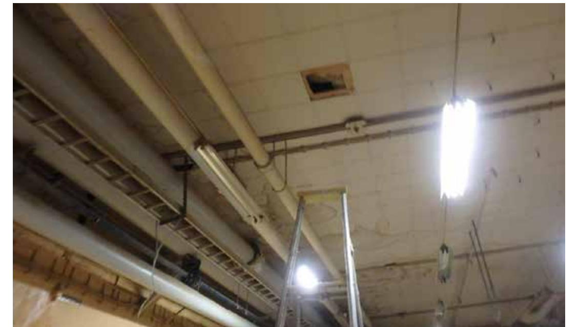
F2-osan sisäkatto. Insinööritoimisto Lauri Mehto 2019
