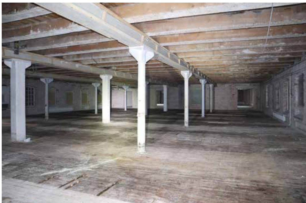
Näkymä salin läpi kohti F14 tilaa.
