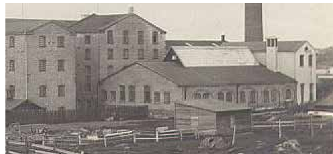
Valokuva pohjoisesta vuonna 1909. F4 osaa on korotettu, F8 osa on lisätty, F5 osaa on madallettu, F2 -osaan on lisätty kattoikkuna. Valokuvaaja tuntematon, Åbo Akademi bildsamlingar/Finna
