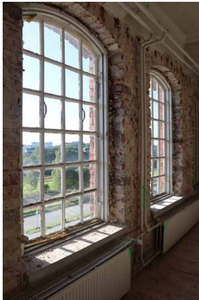
Holvatuissa puuikkunoissa on 24 ruutua. Sisempi puite yleensä puuttuu.
