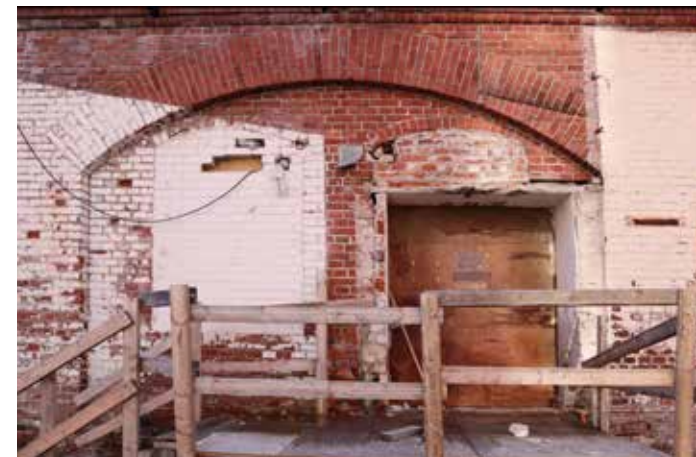
Vuonna 1899 valmistuneen F2 osan julkisivuissa näkyvät useat muutosvaiheet umpimuurattuina aukkoina, sisäkkäisinä holvauksina, ja betonivahvisteisina kulkuaukkoina.
