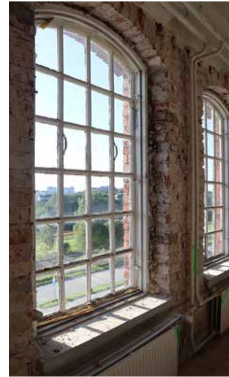
Ikkunat on kiinnitetty sormihaoin ja niihin liittyy nostokahvat. Kuva F5 osan 3. kerroksesta
