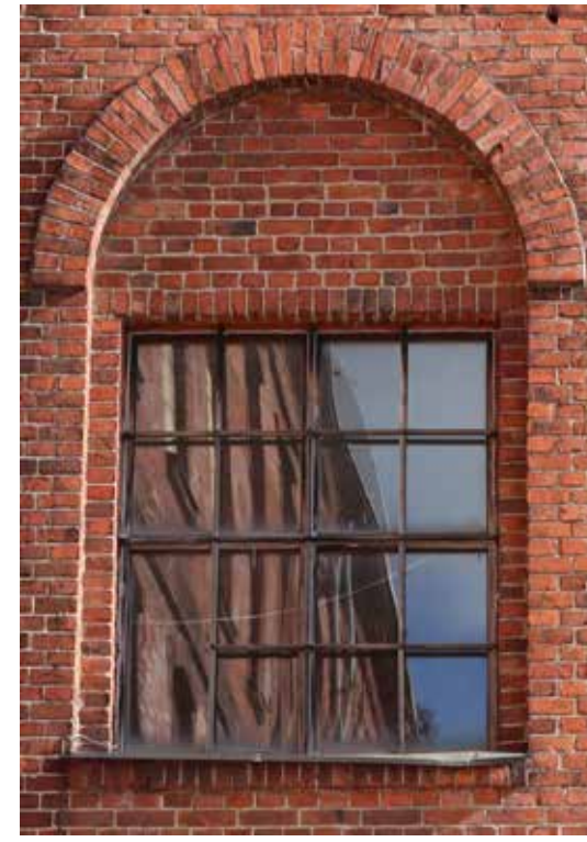
F6 osan myöhemmin uusitussa ja muutetuissa ikkunoissa on ulkopuoliset valeristikot. Ikkunaholvaus on tässä osassa poikkeuksellisesti puolikaaren muotoinen.
