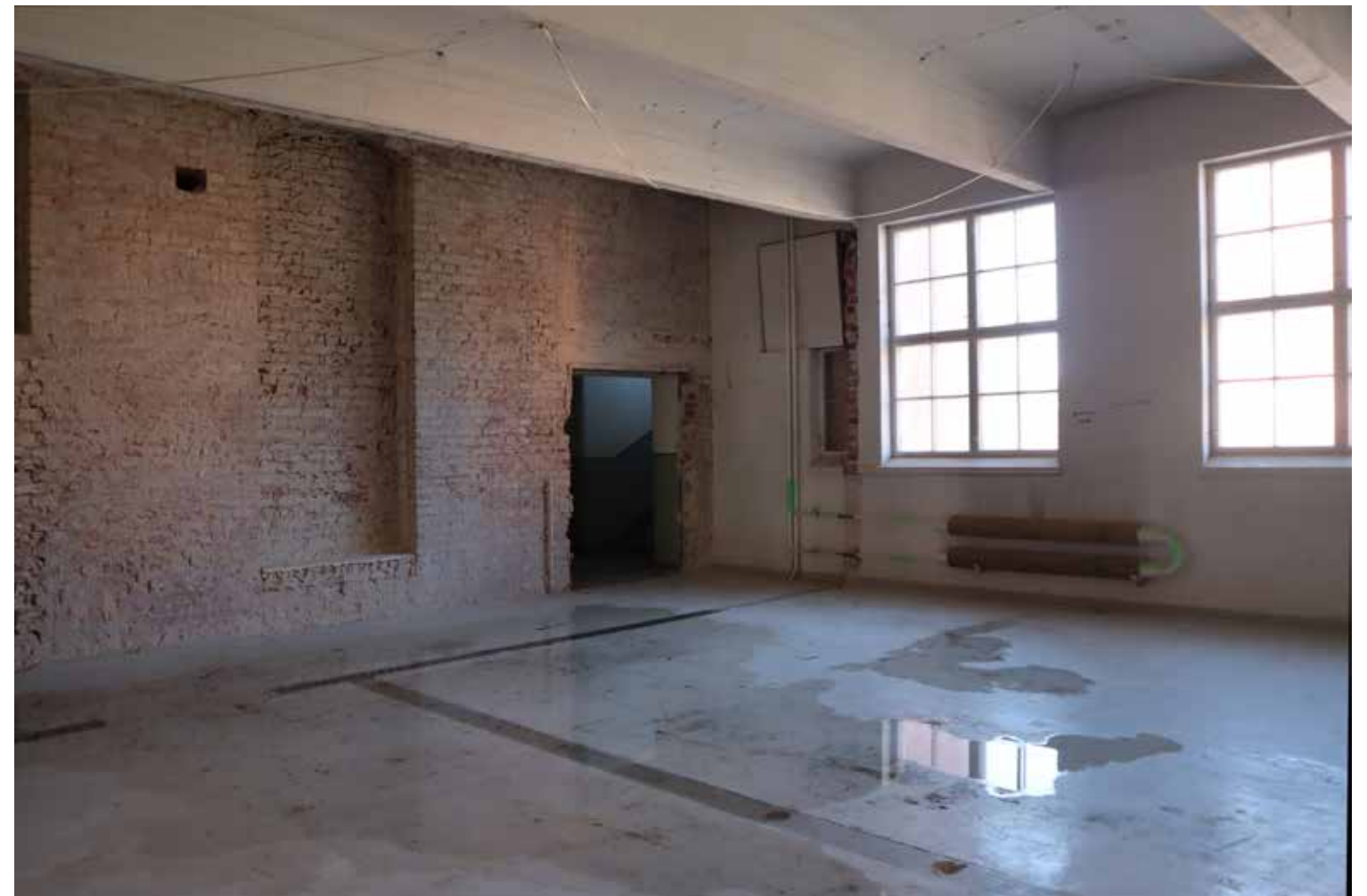
3. kerroksen salitila, taustalla porrashuone F7
