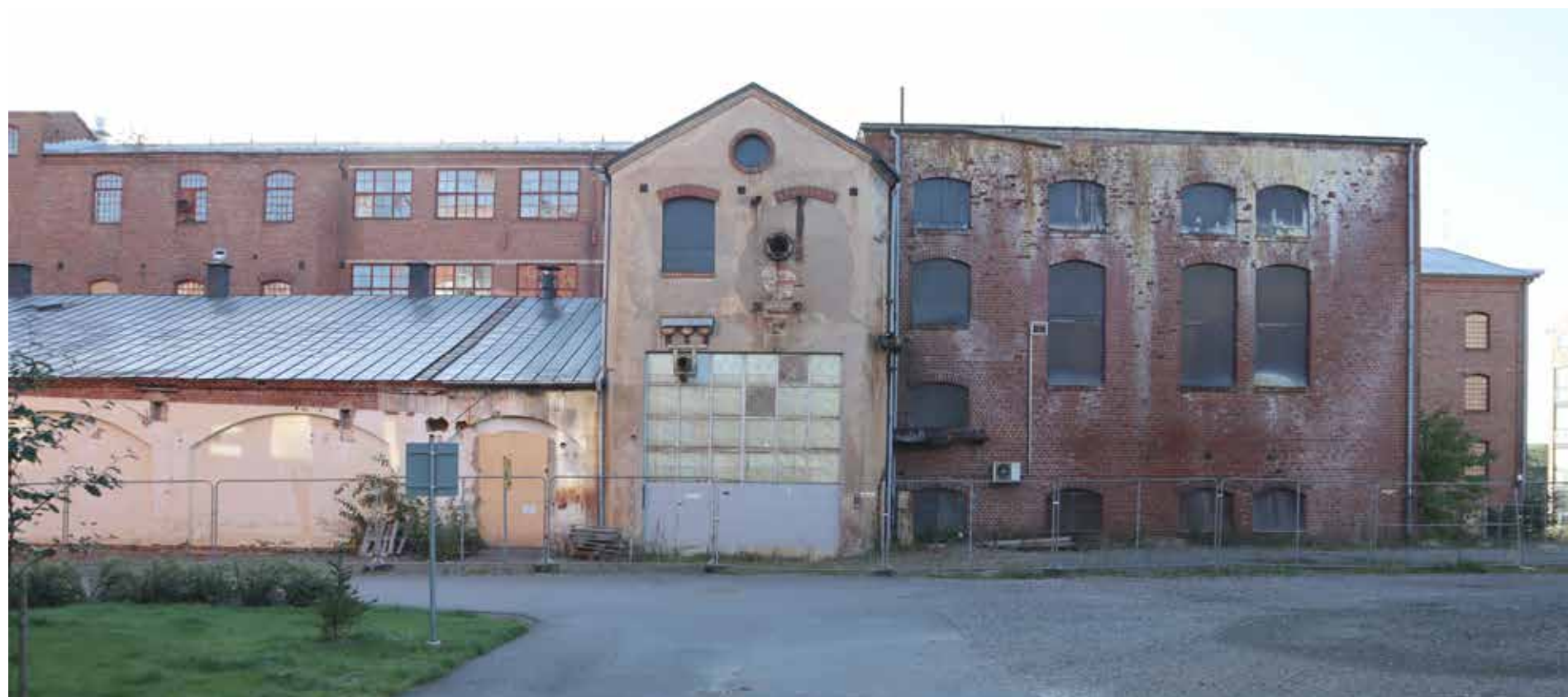
Pannuhuoneen F1 -osan alkuperäisestä julkisivusta on jäljellä lähinnä vain fragmentteja. Levyillä suojatuissa ikkuna-aukoissa on säilynyt vanhempia puuikkunoita. Varhaisimpaan rakennusvaiheeseen kuuluvan F1-osan julkisivut poikkeavat rapattuina muusta rakennuksesta.
