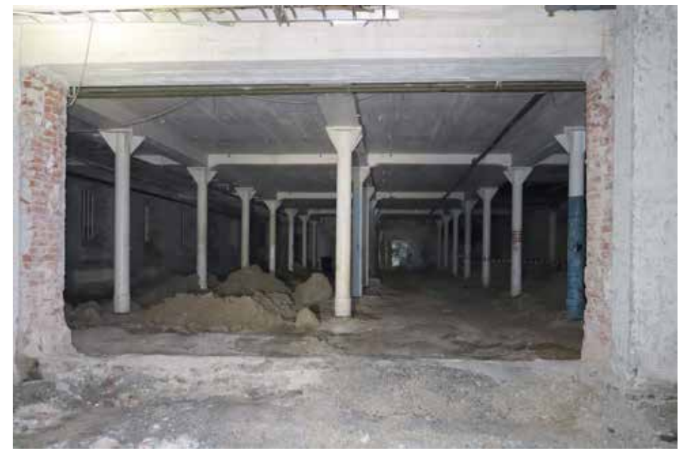
F14 ja F3 tilan välille on avattu leveä oviaukko.
