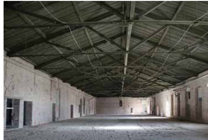
Osan F4 puu- ja teräsrakenteinen kattoristikko
