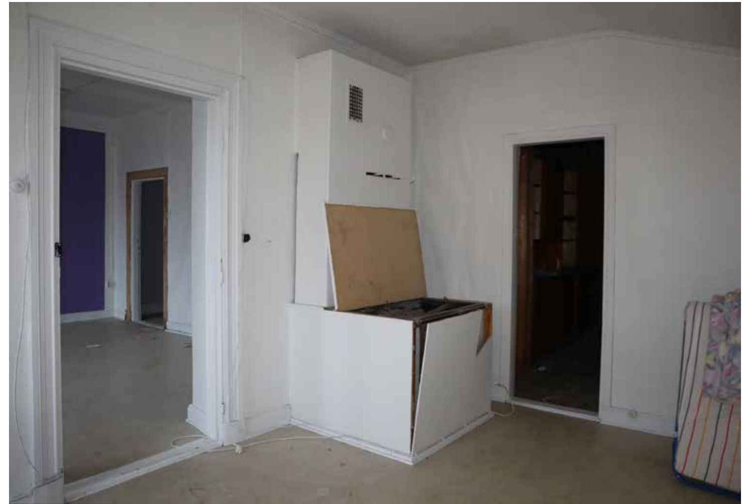
4. kerroksessa on säilynyt vanhoja peiliovia sekä profiloituja vanhoja peite- ja lattia- listoja. Vanha puuhella on koteloitu levyillä.
