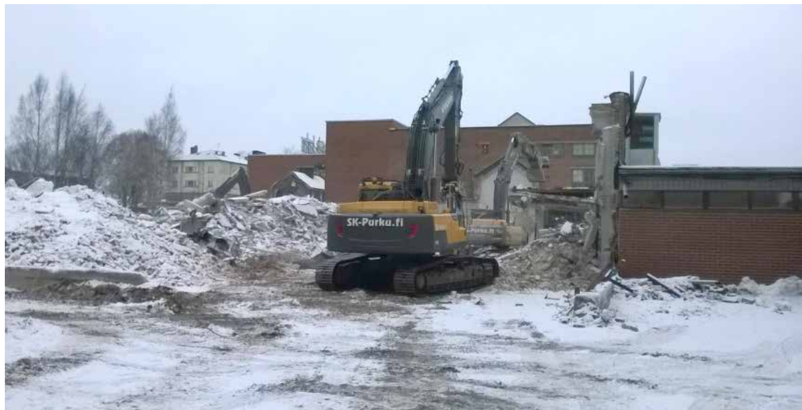
Tehtaan takana olleet laajennusosat purettiin vuonna 2017. Kuva TMK/Sanna Kupila.
