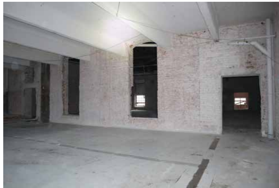
F4 salin vastainen seinä.
