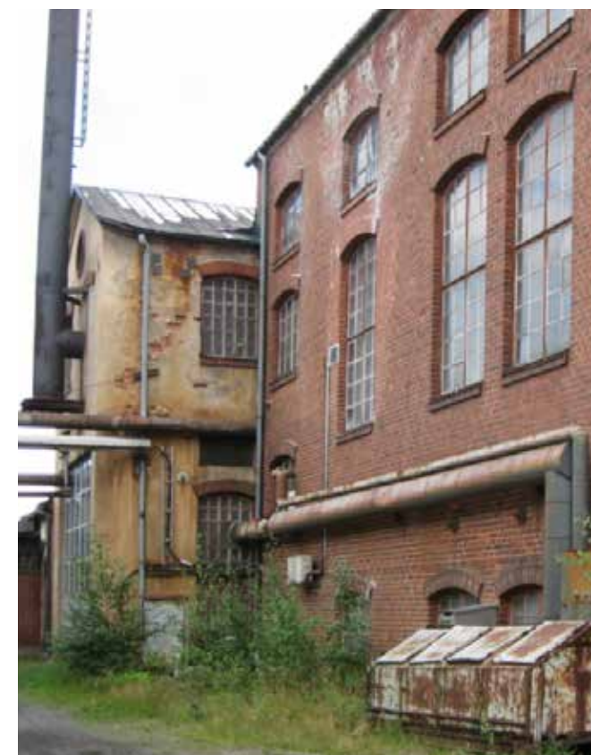
Valokuvassa vuodelta 2006 näkyvät pannuhuoneen(F17) levytetyjen ikkunoiden takana edelleen säilyneet vanhat puuikkunat. Taustalla näkyy myös vanhimman osan F1 pieniruutuiset holvatut ikkunat. Kuva TMK/ Maarit Talamo-Kemiläinen.
