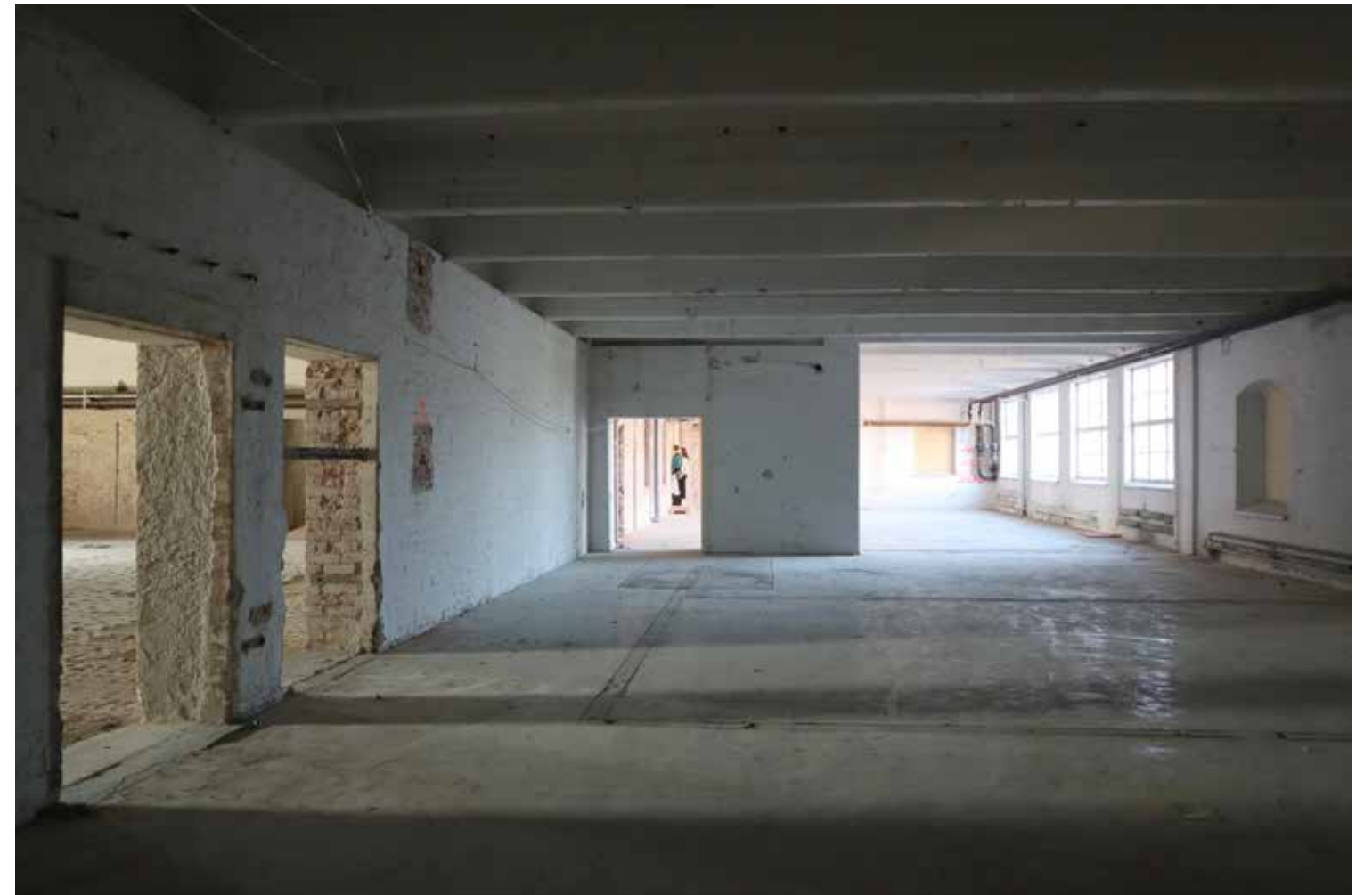
3. kerros, vasemmalla oviaukot F4 tilaan, taustalla F21 tila
