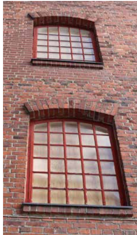
Holvatut 30 ruutuiset kitatut puuikkunat ovat yleisin ikkunatyyppe. Kuva F14 päädyssä.
