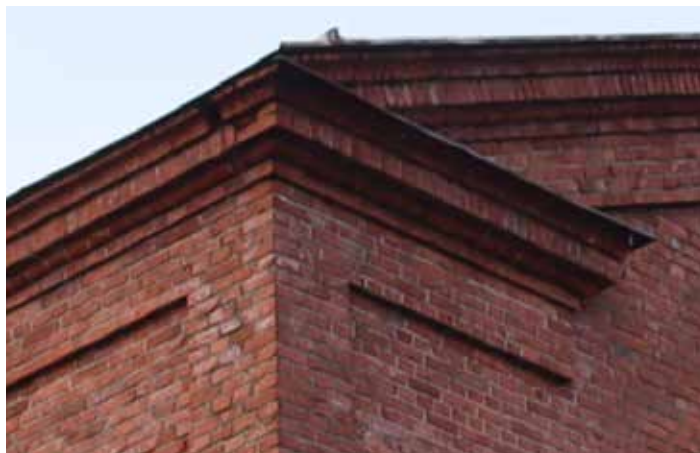
Varhaisimpiin rakennusvaiheisiin kuuluvassa F8-osassa on porrastuen muurattu räystäs päädyille kääntyvinen ns. kissanpenkkiaiheineen. Ulkonurkalla on lisäksi ulkoneva koristemuuraus.
