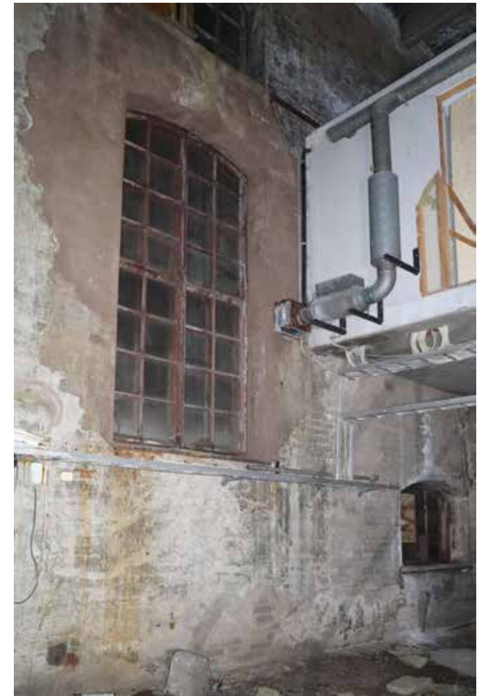
Ulkoseinissä säilyneet vanhat puuikkunat on ulkopuolelta peitetty vanerilevyin.
