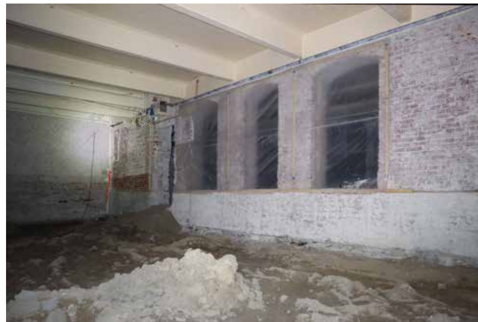
1. kerroksen väliseinä, taustalla F4- salitila
