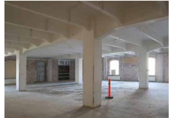
Välipohjan tukeva betonipalkisto ja runkopilarit F14-osassa
