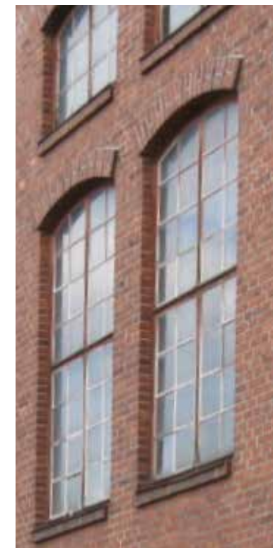
Vuoden 2006 valokuvassa näkyvät pannuhuoneen(F17) nykyään levytettyjen ikkunoiden takana edelleen säilyneet korkeat vanhat puuikkunat. Oikealla kuva sisäpuolelta.
