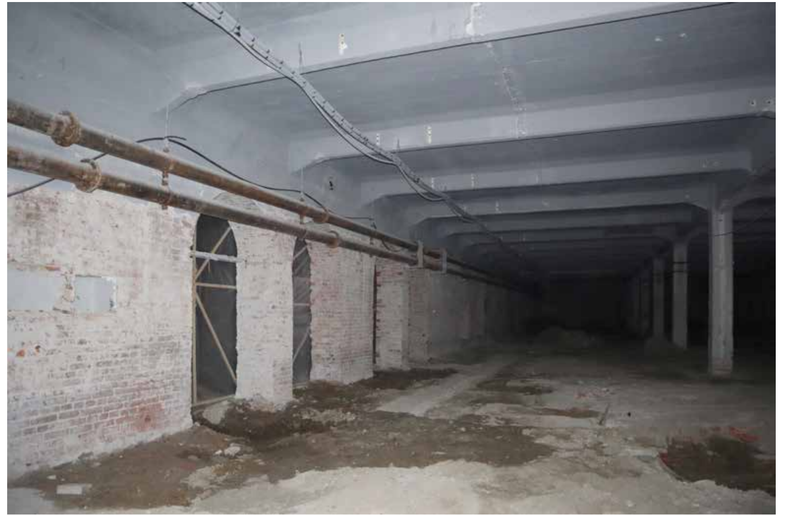
F4 salin luoteisseinällä olleet aiemmat ikkunat on avattu suuriksi holvatuiksi oviaukoiksi.
