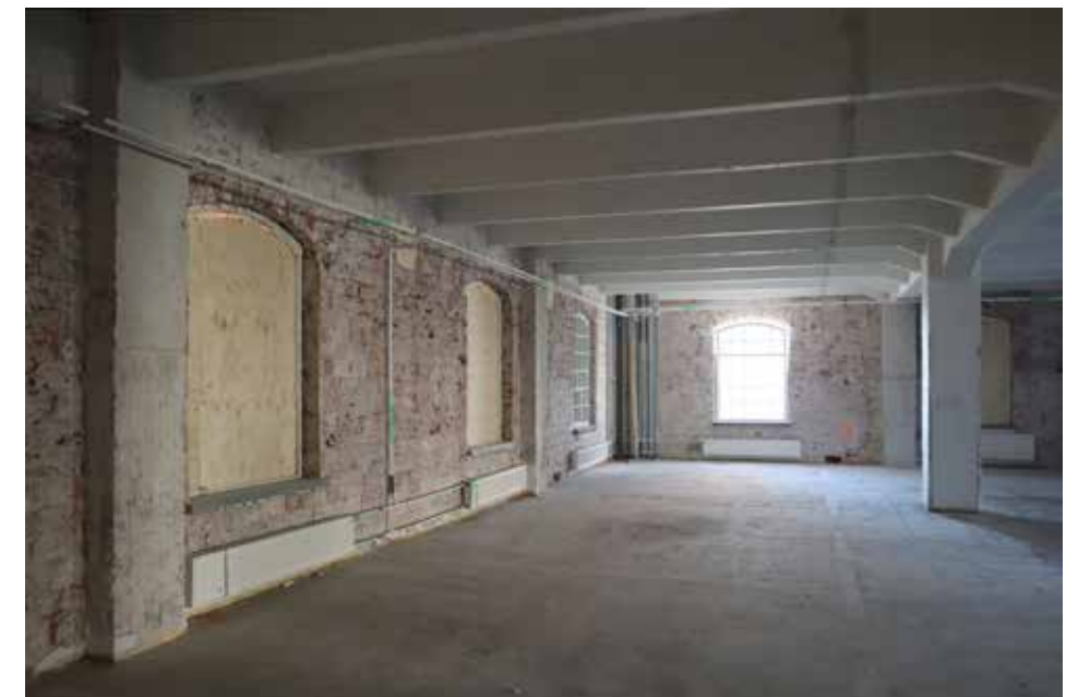
Ulkoseinän betonipilarit ovat osa runkorakennetta.
