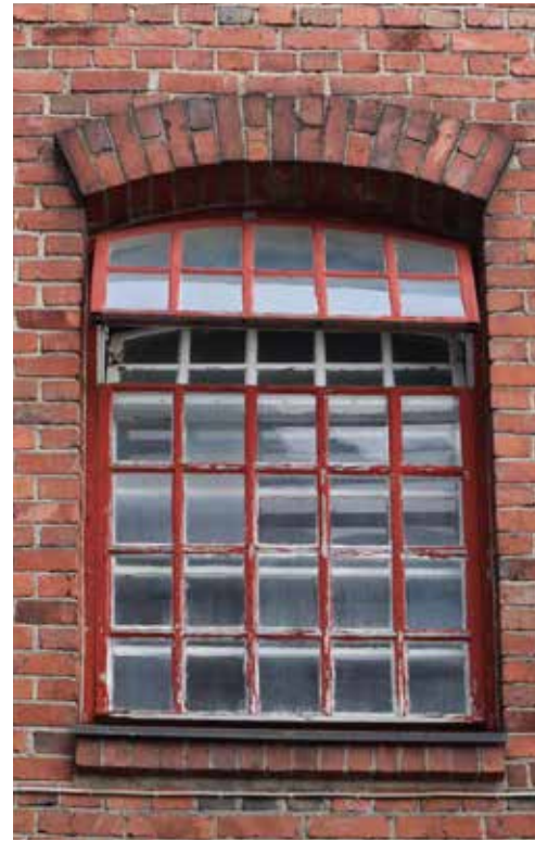
Osa ikkunoista on yläosastaan avattavia. Kuva F14 päädyssä.
