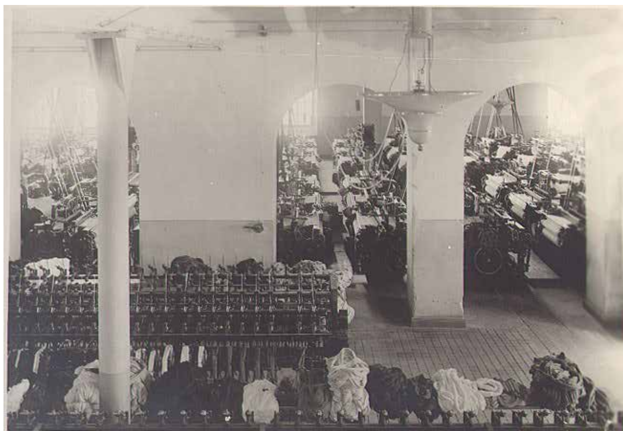
Kuva F5-osan 1 kerroksesta, holvattujen oviaukkojen takana F4 osan kutomosaliin. Valokuvaaja August Snickars. Åbo Akademin arkistokokoelma.
