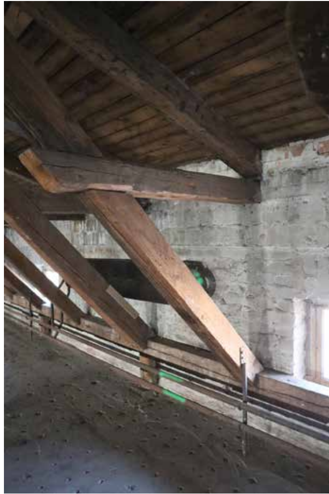
Kattotuolin liitos ulkoseinään.
