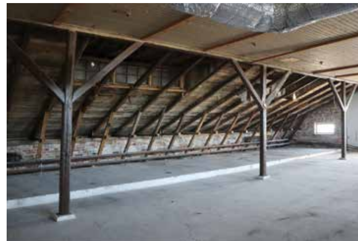
Osan F14 vapaakantoinen, niin kutsuttu ruotsalainen katto-tuolirakenne.
