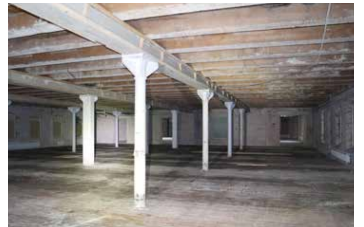
F3-osan 3. kerroksessa näkyy teräspilarein kannatellun puurakenteisen välipohjan rakenteet ja puinen lattia.
