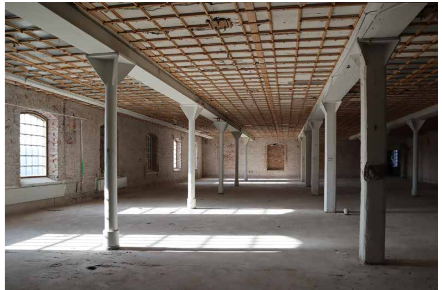
2. ja 3 kerroksessa on säilynyt teräspilarien ja -palkiston kannatteleva vanha puurakenteinen välipohja. Päätysseinällä, joka alkujaan oli ulkoseinä, näkyy umpeen muurattuja ikkuna-aukkoja.
