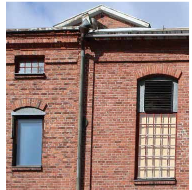
F3 ja F4- osan saumakohdassa näkyy vaihteittainen toteutus muurauksen sävyerona. F4 osalla(oikealla) on ulkoneva räystäs, johon liittyy vain ohuesti porrastuva muuraus. Räystään yksityiskohtia on mahdollisesti muutettu vesikaton uusimisen yhteydessä.
