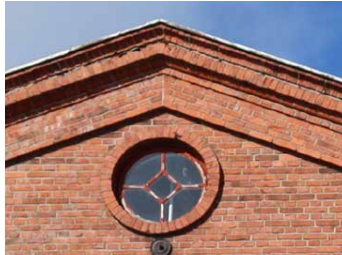
Räystäällä on käytetty myös muototiiltä. F6- osan päädyssä on pyöreä ikkuna.
