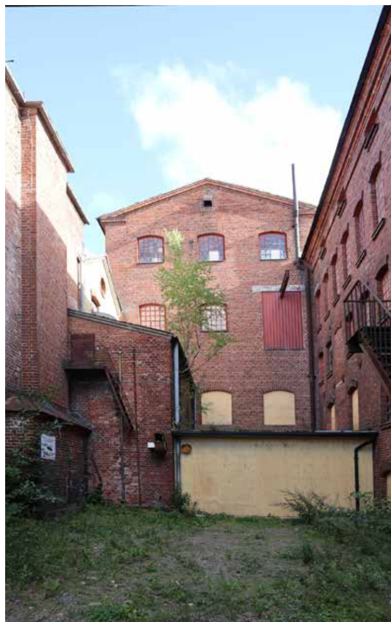
Näkymä F3-osan ja pannuhuoneen F17 välitilaan. Taustalla F21 osan lounaispääty.
