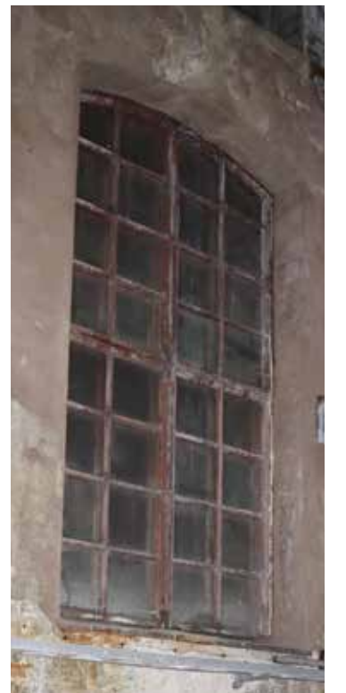
Vuoden 2006 valokuvassa näkyvät pannuhuoneen(F17) nykyään levytettyjen ikkunoiden takana edelleen säilyneet korkeat vanhat puuikkunat. Oikealla kuva sisäpuolelta.
