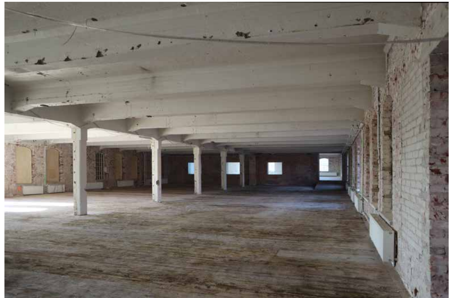
Salitila liittyy pienen rampin välityksellä F14 osaan, joka on 340 mm korkeammalla tasolla. Tilassa on vanha kulunut lautalattia.
