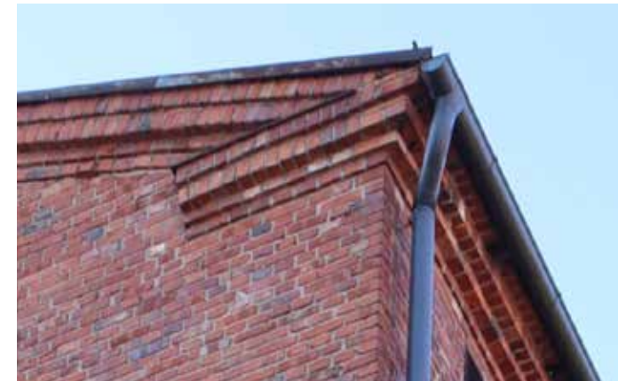
Myös vuonna 1947 rakennetun F22-osan räystäissä toistuvat vanhempien osien vastaavat räystäiden yksityiskohdat.
