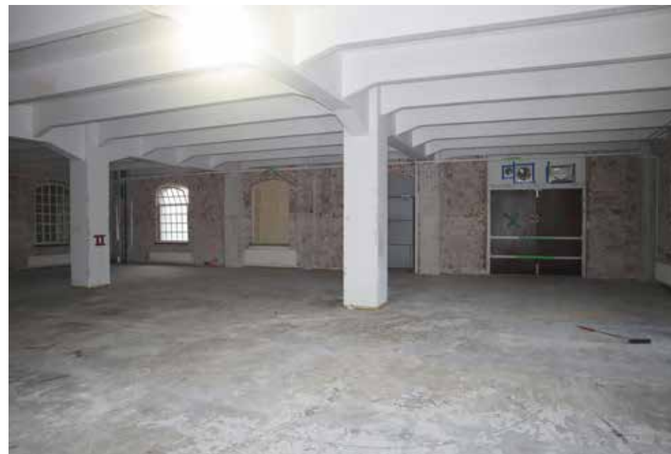
Päätyseinällä on haalausovet ja poistumistieporras.
