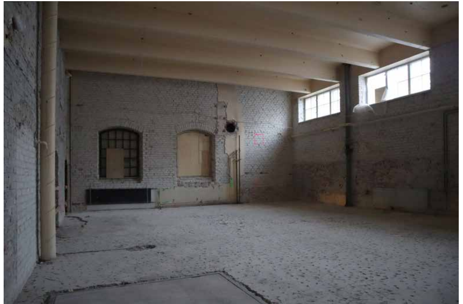
2.krs tila, taustalla lounaaseen suuntautuva ulkoseinä.
