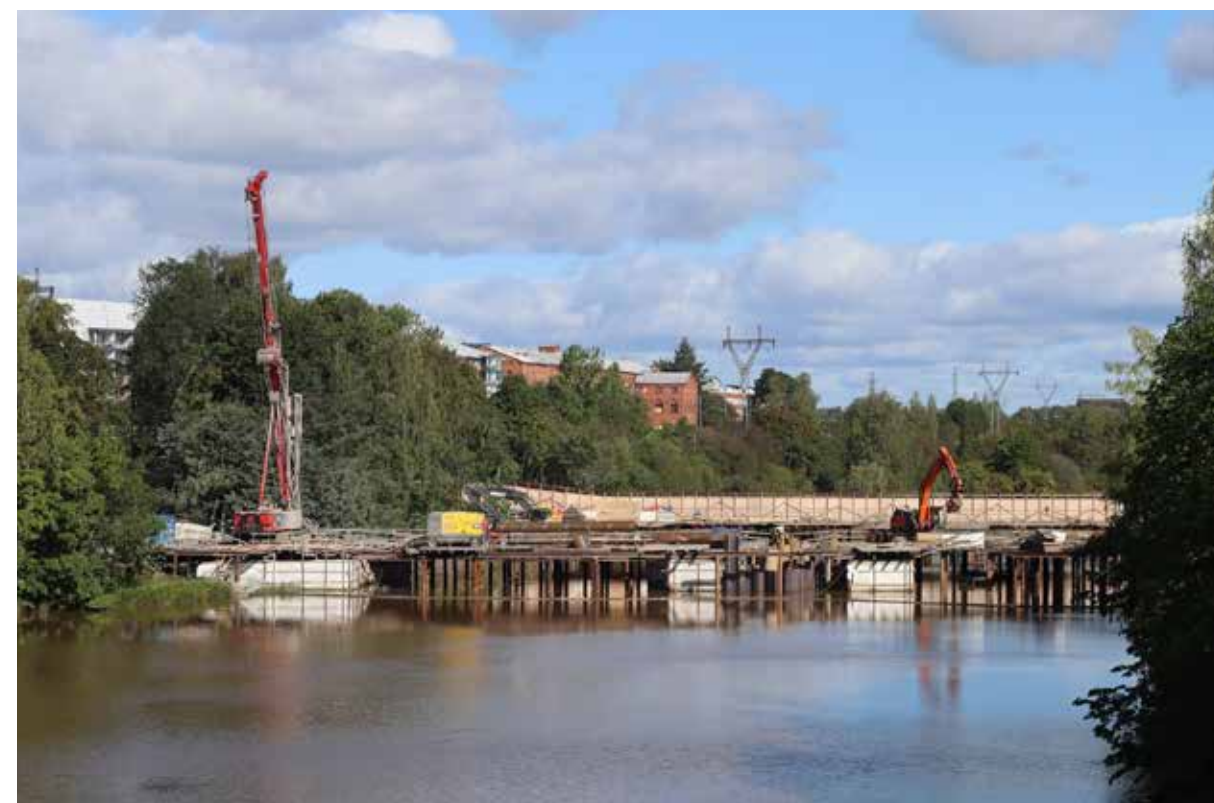
Näkymä Tuomaansillalta, edustalla rautatiesillan työmaa, taustalla näkyy Barkerin punatiilinen tehdasrakennus.
