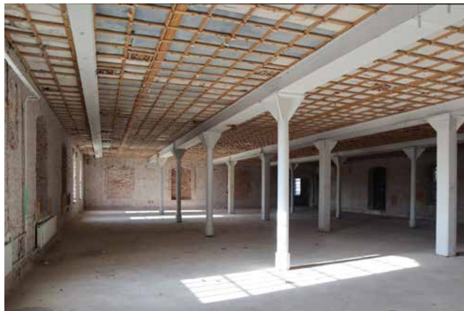
Keskilinjalla pilarit ovat neliskulmaisia, muualla pyöreitä.
