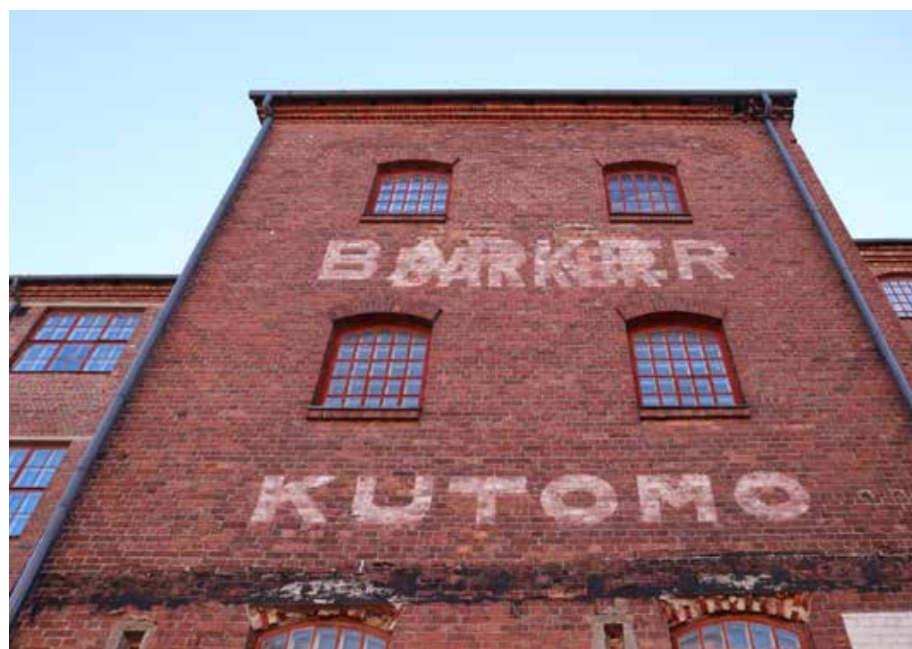
F7 osan pääty jossa sijaitsee porrashuone. Julkisivuun on maalattu tekstinä Barker kutomo. Julkisivun edustalta on purettu myöhempiä laajennusosia.
