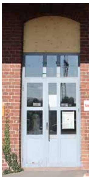
F8 -osan kaksi ulko- ovea ovat ainoat ovet, joita ei ole peitetty levyillä. Vasemmalla porrashuoneen ovi, jossa oviaukkoa on suurennettu, oikeanpuoleinen ovi on sijoitettu ikkuna-aukon kohdalle.
