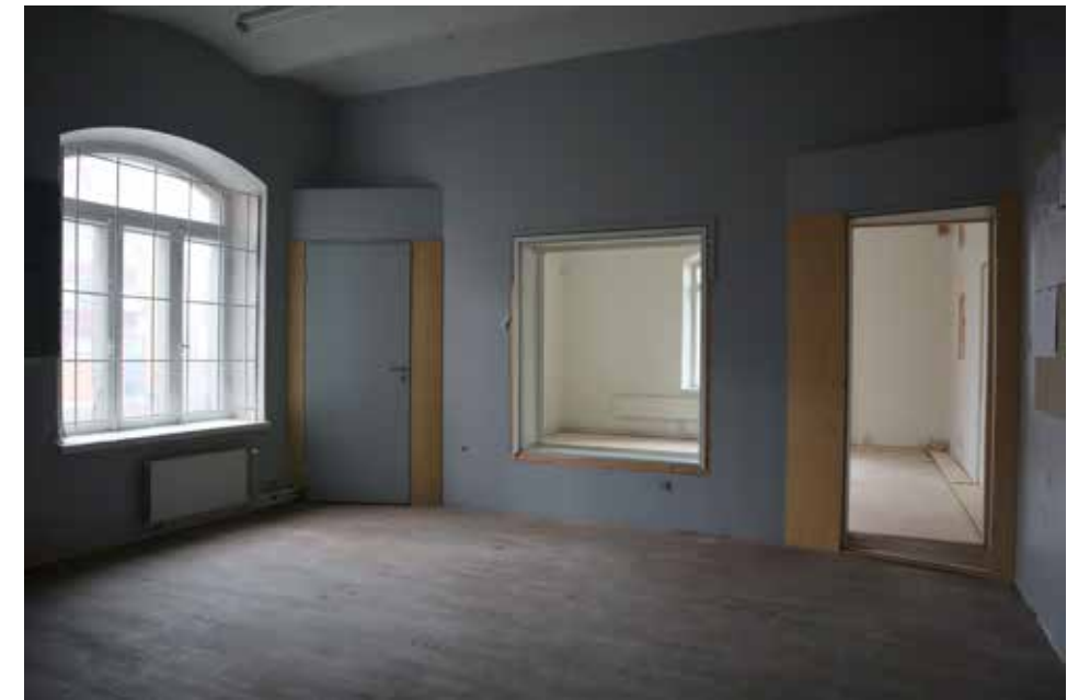
Studiokäytössä olleissa 2. kerroksen huonetiloissa on äänieristettyjä seiniä ja ikkunoita.
