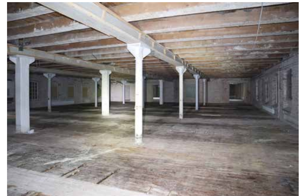
2. ja 3 kerroksessa on säilynyt teräspilarien ja -palkiston kannatteleva vanha puurakenteinen välipohja. Päätysseinällä, joka alkujaan oli ulkoseinä, näkyy umpeen muurattuja ikkuna-aukkoja.
