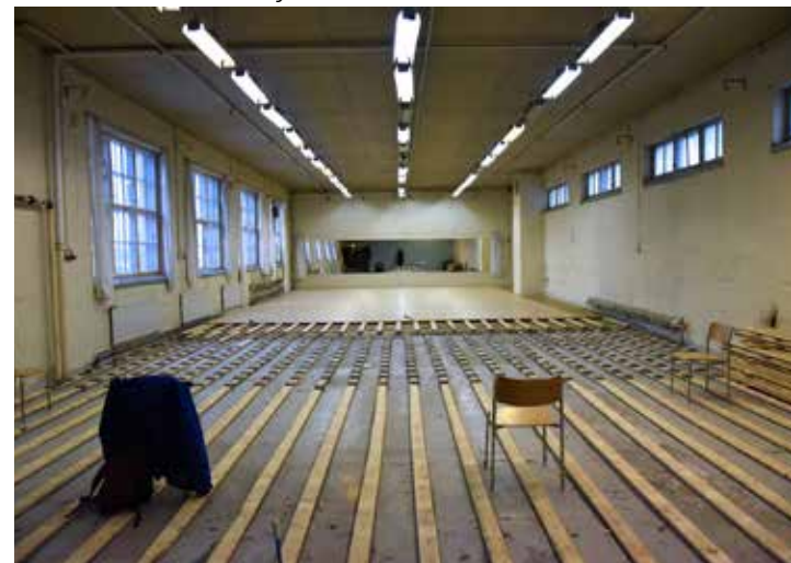
4. kerroksen studio- ja harjoitussalin lattiaa puretaan vuonna 2022. Valokuvaaja Reino Koivula/ www.barkertheatre.fi .
