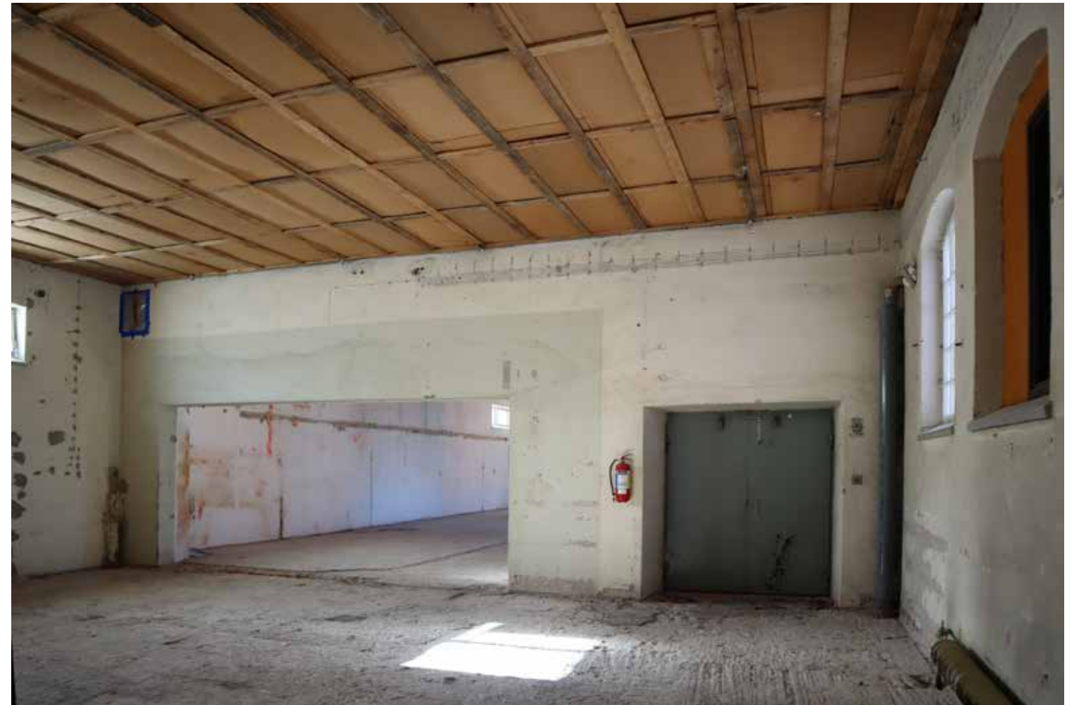
4. kerroksessa F15 ja F5-tilan välissä on leveä oviaukko. Sen vieressä on tavarahissi. Ikkunapenkit ovat korkealla
