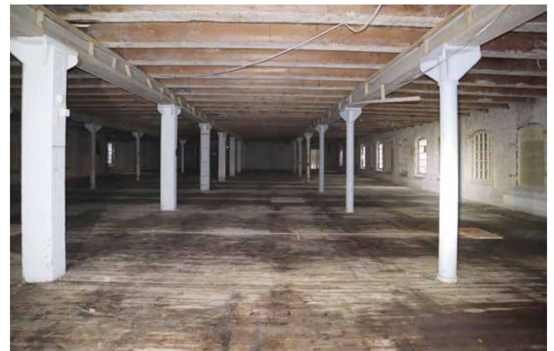
Näkymä salin läpi kohti F4 tilaa.
