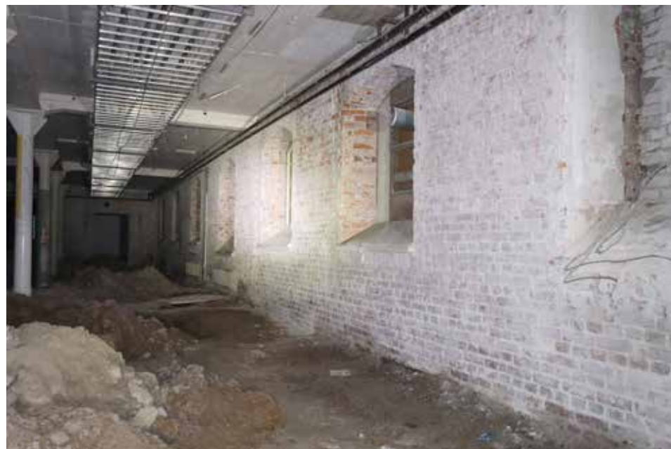
F3 ja F4 osan väliseinän vieressä on tavarahissi.
