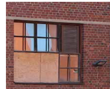
1947 valmistuneessa F22 osassa on suorakulmaiset ruutuikkunat. 3. ja 4. kerroksissa on alkuperäiset puuikkunat, 2 kerroksessa on myöhemmin uusitut valeristikoin varustetut ikkunat.
