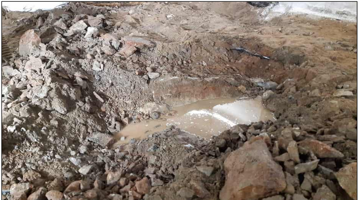
Kuva 6. Koekuopassa KK11 saavutettiin kallion pinta noin 0,3 metrin syvyydessä, kaivantoon kertyi hieman vettä.
