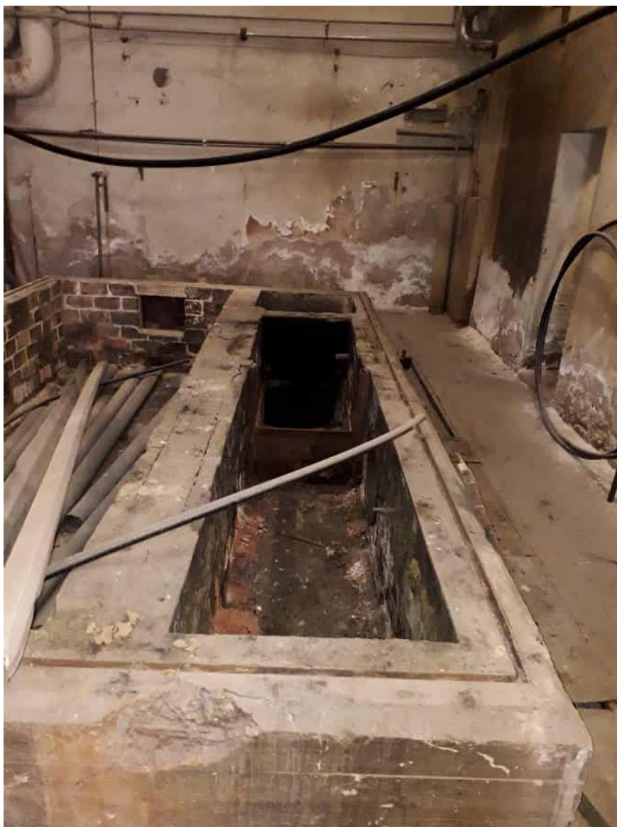
Kuva 4. Betonibunkkeri. Näyte L7 bunkkerin pohjalta.
