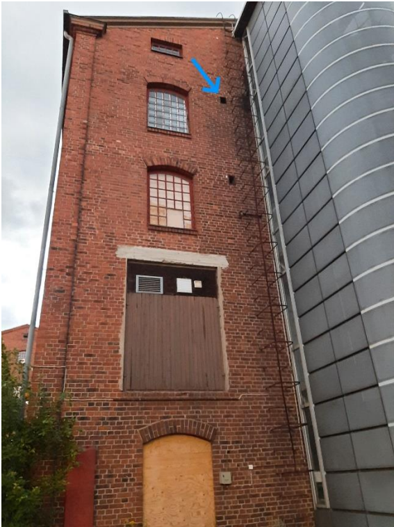
Kuvat 3 ja 4. Nuoli osoittaa lepakoiden kulkuaukkona toimivan tuuletusritilän. Kanava on sisäpuolelta suljettu vanerilla.
