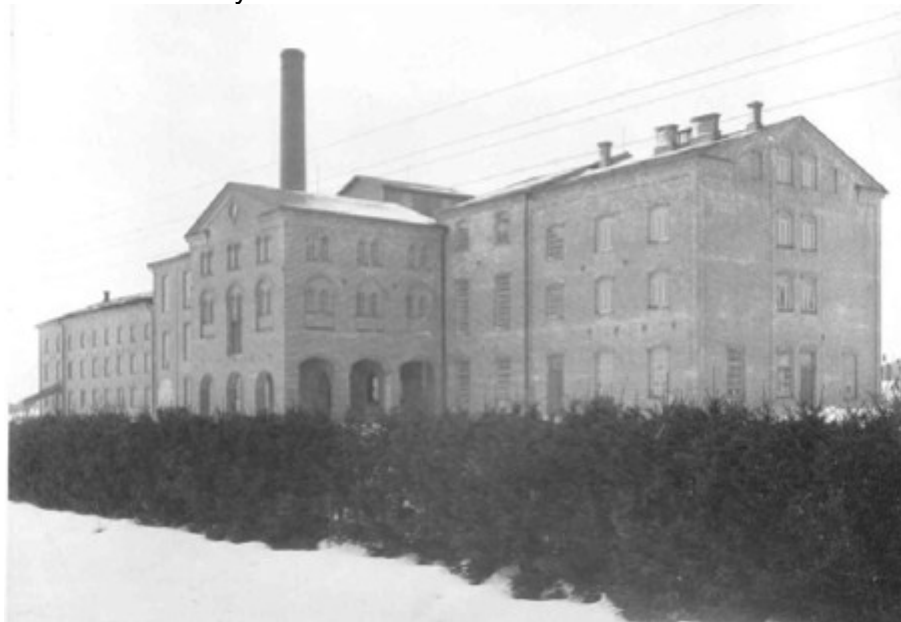
Kuva 11. Tehdasrakennus vuoden 1906 muutosten jälkeen. Tuntematon valokuvaaja. Turun museokeskus/Finna
