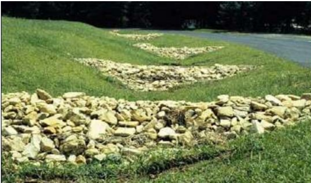
Kuva 13. Esimerkki avo-ojan yhteyteen rakennetusta murskepadosta. (lakesuperioirstream.org)
