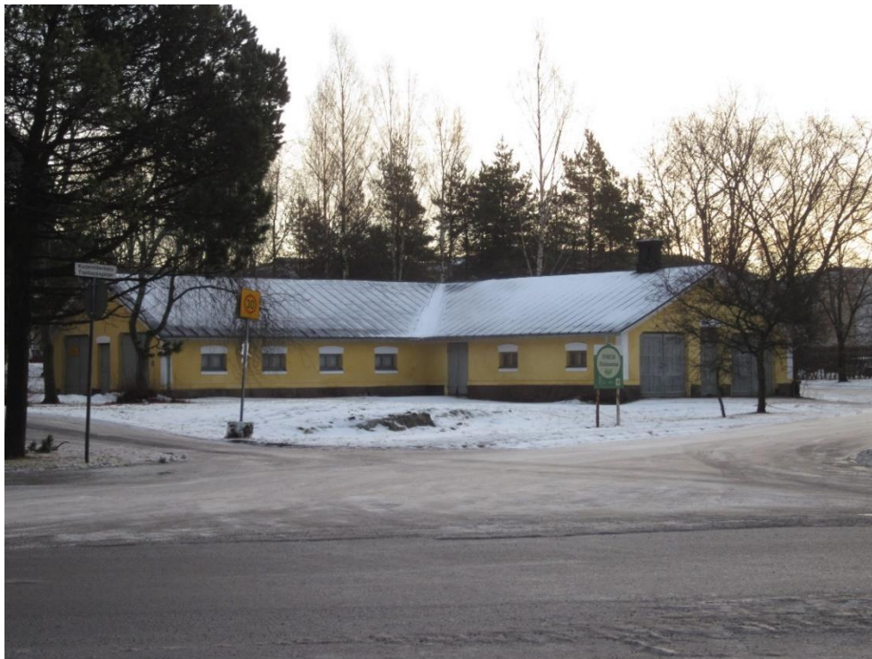
Kuva 9. Rakennuksen nro 36 länsijulkisivu.
