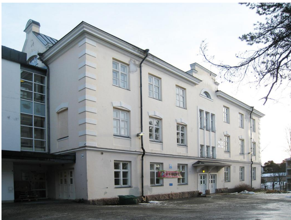
Kuva 8. Rakennuksen nro 34 länsijulkisivu.
