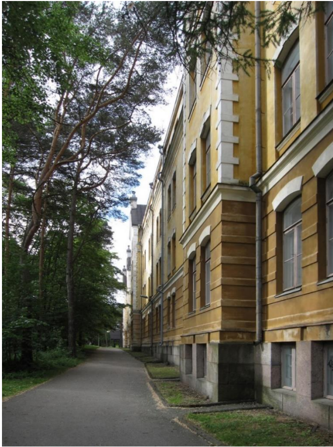
Kuva 5. Rakennuksen nro 33 itäjulkisivu. © Sanna Kupila, 11.6.2014
