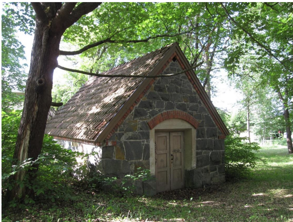
Kuva 10. Rakennuksen nro 35 julkisivu pohjoiseen.
