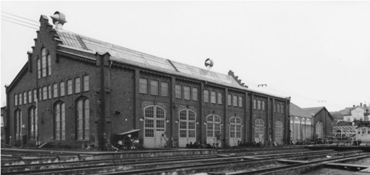
↑ Bruno Granholmin suunnittelema 1800-luvun lopun konepajan laajennus. Kuva on otettu vuonna 1966 ennen rakennuksen yhdistämistä koillisen puoleisiin pajarakennuksiin. Olavi Karasjoki. RM.
