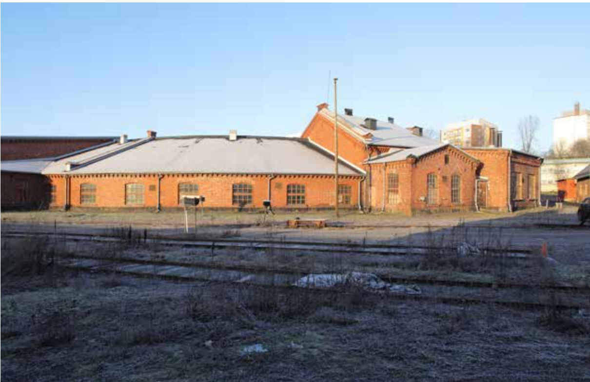
↑↑ Veturitallin vanhimpien osien tiilijulkisivuis- sa on käytetty kaariholvauksia sekä erityyppi- isiä koristemuurauksia räystäslinjan alla.
