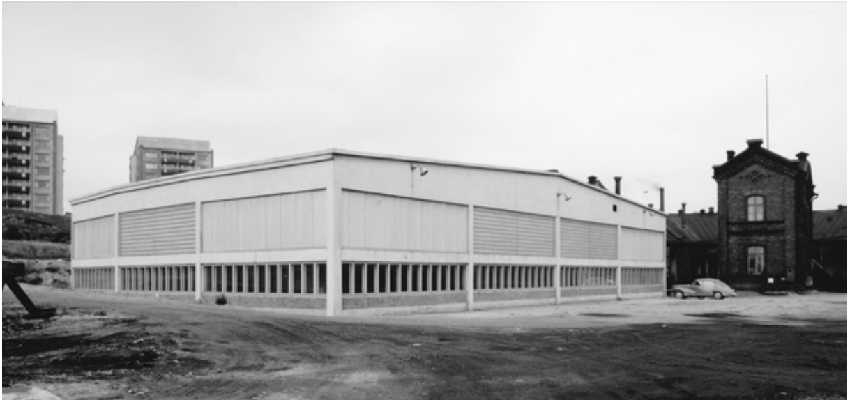
↑ Dieselveturitalli kuvattuna oletettavasti paikoin valmistumisen- sa 1950-luvun lopulla jälkeen. Rakennuksen julkisivuja on sittemmin muutettu, esimerkiksi lasitiilet on korvattu tavanomaisilla ikkunapin- noilla. Kuvan oikeassa laidassa on nähtävissä myös veturitallin pää- tyosa, joka aluksi erotettiin itse veturitallista pilttuilla purkamalla ja sittemmin purettiin kokonaan. Olavi Kaurasjoki. RM.
