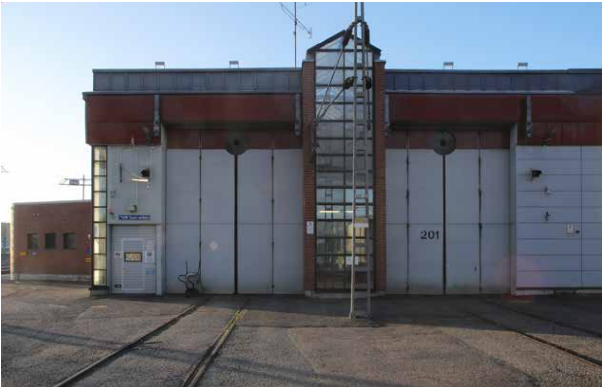
↑↑ Henkilövaunujen huoltohallin pitkänomais- ta sisätilaa valaisee ylhäältä kolmiomainen kattolyhty.
