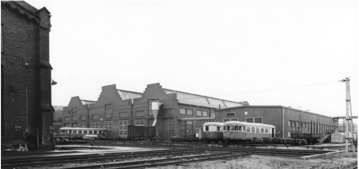
↑ Konepajan koillisen puoleinen julkisivu kuvattuna vuonna 1966. Olavi Karasjoki. RM.
