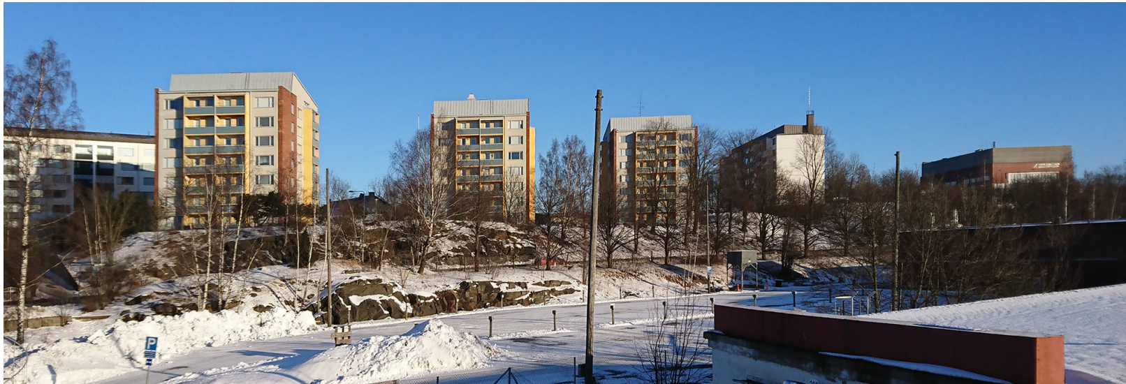
Kuva 8. Köydenpunojankadun varren rakennuksia. Ylhäällä vasemmalla: Pohjolan 1920-30-lvuilla valmistuneita puutaloja. Ylhäällä oikealla: Kaunen kulman asuinkerrostaloja (2008). Alhaalla: Juhannuskukkulan kerrostaloja (1957) ja Juhannuskukkulan vesisäiliö (1958).
