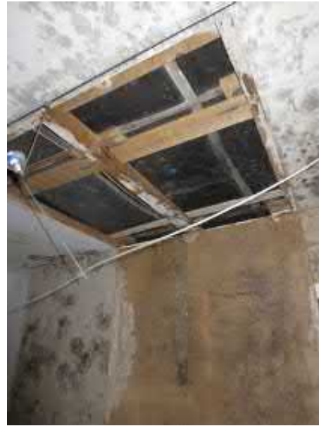
Kuva 5.20 1. kerroksen avattu alakatto
