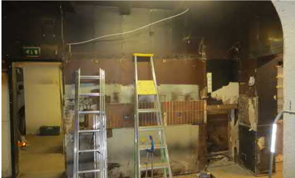
Kuva 4.28 Tarjoilutilan ja keittiön välinen seinä
