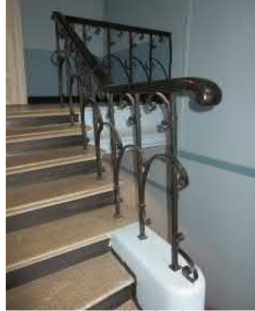
Kuva 3.87 As 35: portaikko 2. kerroksessa
