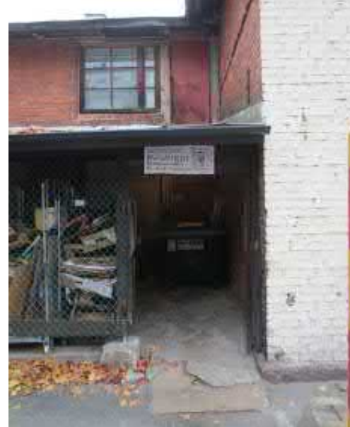
Kuva 5.23 Näkymä ent. pajan poistetun portaan kohdalta. Pihatason vanha porrasaskelma säilynyt.
