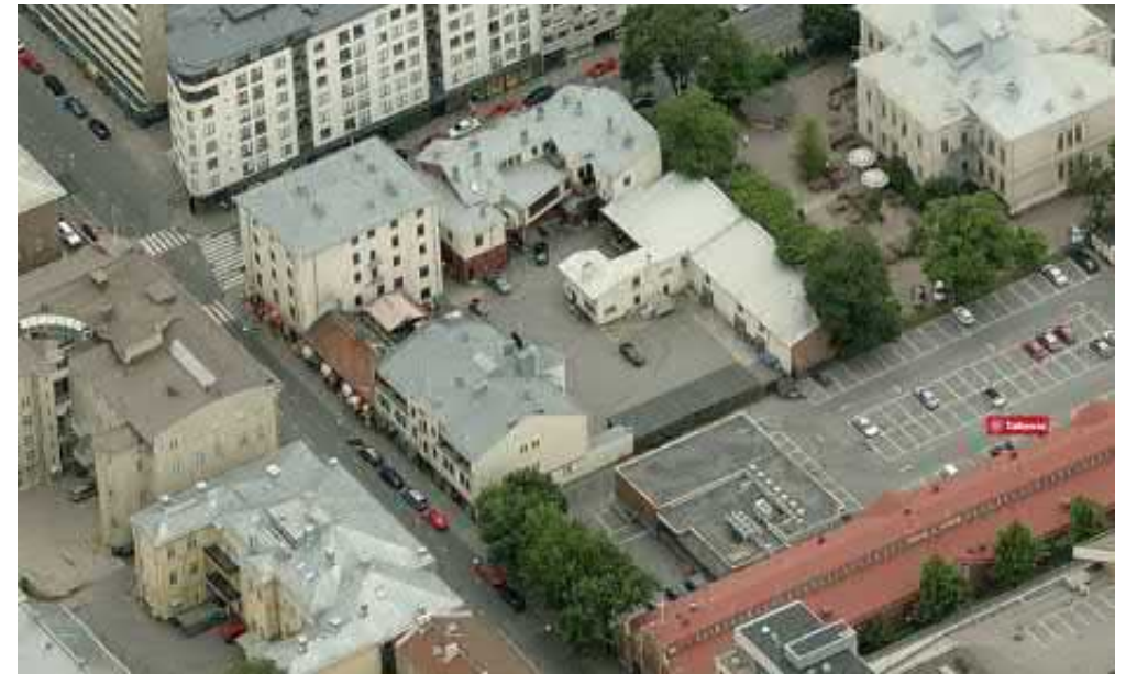
Kuva 3.12 Kattonäkymä sisäpihan puolelta
