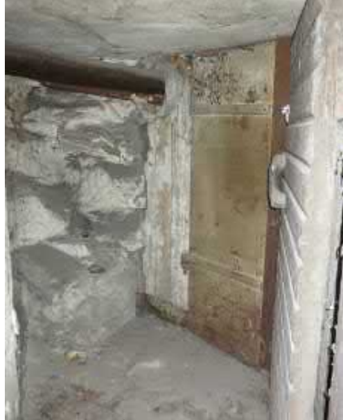
Kuva 3.32 Kellari/liike 33: kellarin ulko-ovi ja sisäosan rautaovi
