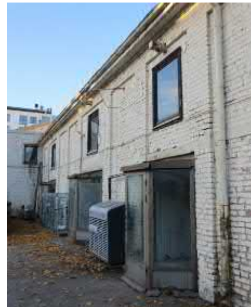
Kuva 6.9 Sisäänkäyntien ovimuutos tehty v. 1983
