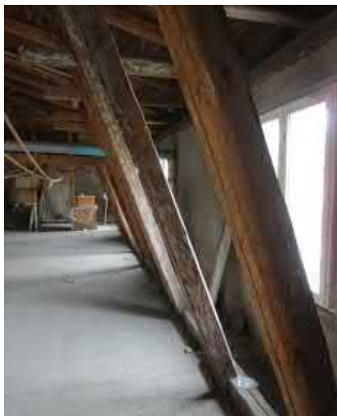
Kuva 2.30 Ullakon ja asuntojen ikkunat on uusittu
