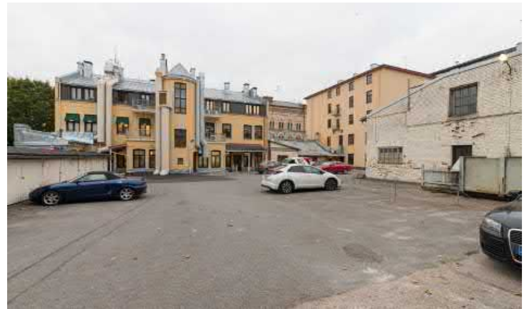
Kuva 1.2. Garnin julkisivu sisäpihan suuntaan. Uusien ravintolatilojen iv-laitteet on sijoitettu pihanpuoleiseen julkisivuun.
