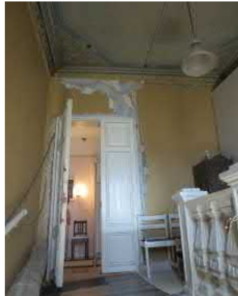
Kuva 3.67 As 34: porrashuoneen 2. kerroksen taso
