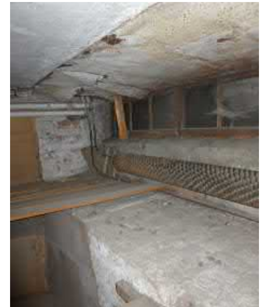
Kuva 3.22 Kellari/liike 29: kellarin ulkoseinää Kristiinankadun puolella
