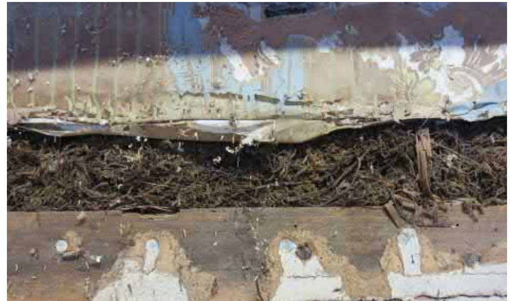
Kuva 4.31 Tarjoilutilan ja keittiön välisen seinän vanha tapetti
