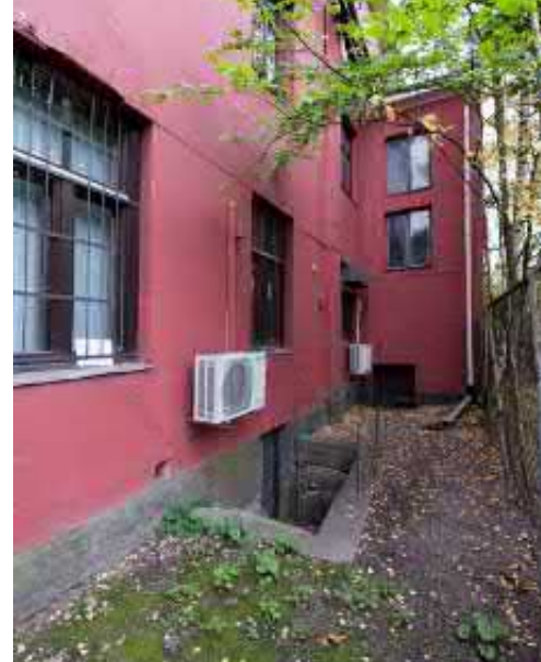
Kuva 3.35 Kellari/liike33: toisen kellarin sisäänkäynti porrashuoneen kohdalla
