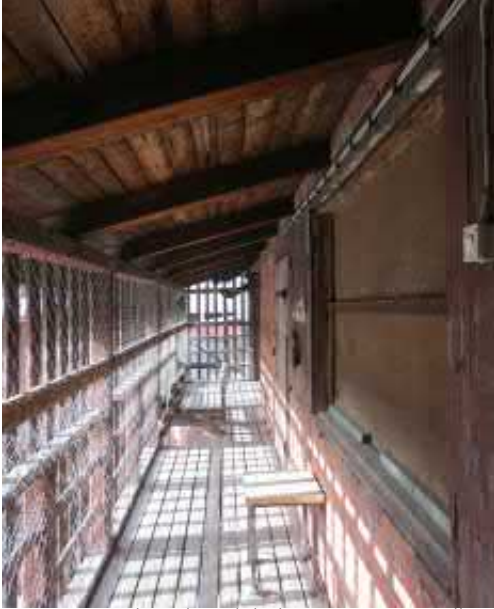
Kuva 5.11 2. kerroksen luhtikäytävä: vasemmalla näkyvässä alkuper. kaidejako, lisätty myöhemmin verkko ja sisäpuolen yläkaide.
