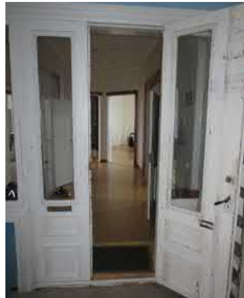
Kuva 3.89 As 34: porrashuoneen 2. kerroksen ovi
