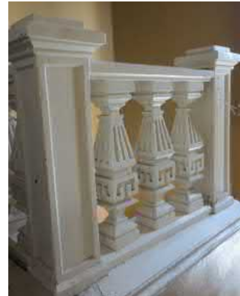
Kuva 3.68 As 34: 2. kerroksen portaan kaide
