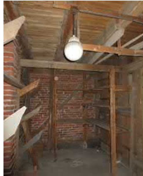
Kuva 5.17 Luhtiaitan 1. kerroksen varasto
