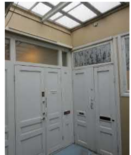
Kuva 1.24 Garnin 3. kerroksen asuntojen sisäänkäynnit, yläosassa kattoikkuna
