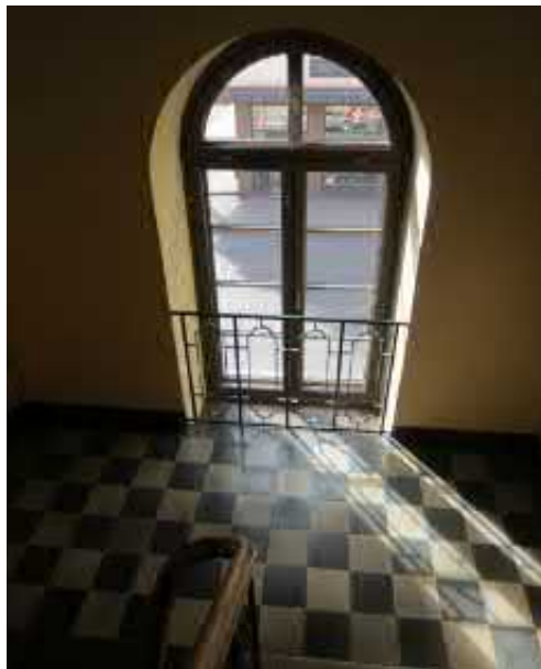
Kuva 2.20 Porrashuoneen välitasanteen ikkuna suojakaiteineen
