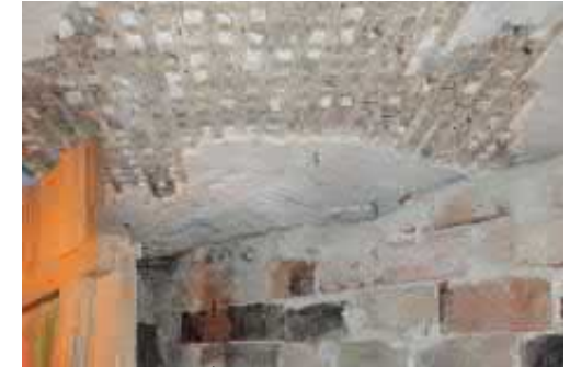
Kuva 3.36 Kellari/liike33: kellarin katto
