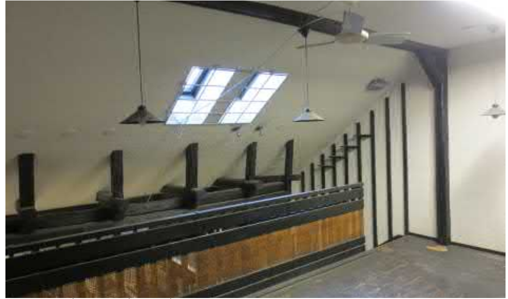
Kuva 4.52 Näkymä parvelta sisäpihan suuntaan
