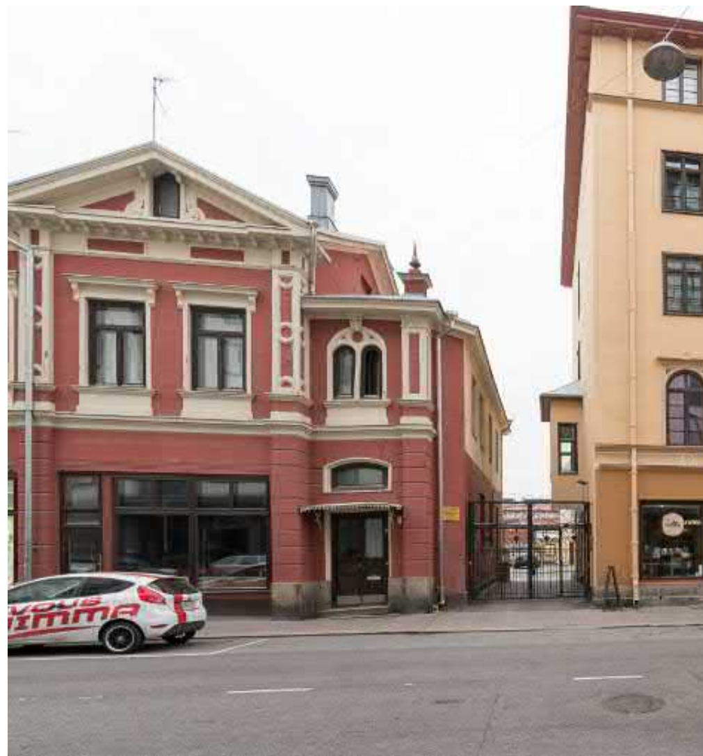
Kuva 3.58 Osa Kristiinankadun julkisivusta
