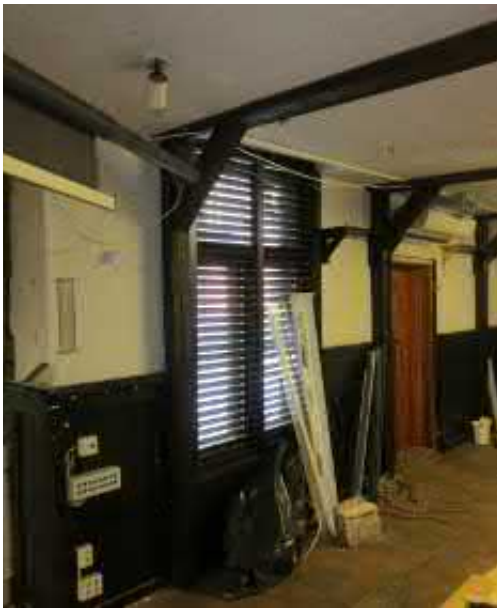
Kuva 4.39 Kabinetti ikkuna ja ulko-ovi sisäpihalle
