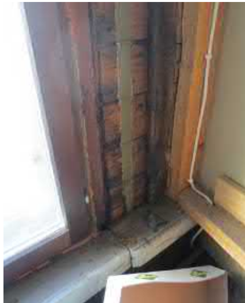
Kuva 3.78 As 34: vanha ikkunapenkki
