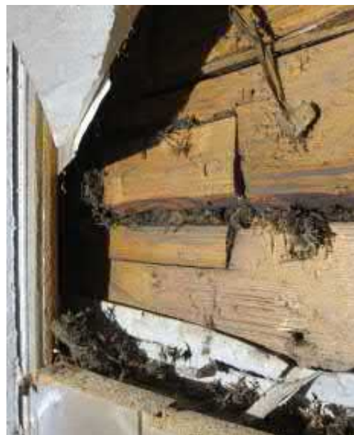
Kuva 4.23/4.24 Seinärakenne kulmatalon suuntaan: kipsilevy, helmiponttilauta, koolaus, tapetti, pinkopahvi, hirsi
