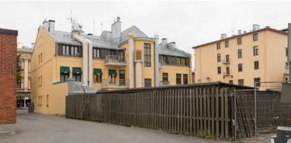
Kuva 1.4 Garnin julkisivu ja pääty Kauppahallin sisäpihan suuntaan. Uusien ravintolatilojen iv-laitteet on sijoitettu pihanpuoleiseen julkisivuun.
