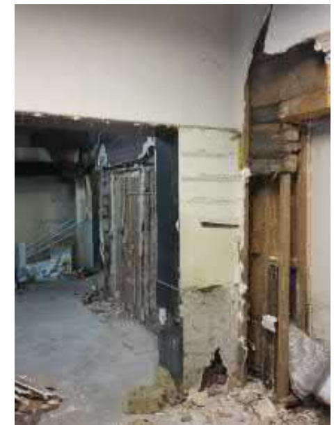
Kuva 4.37 Tarjoilutilan viereinen väliseinä purettu osittain
