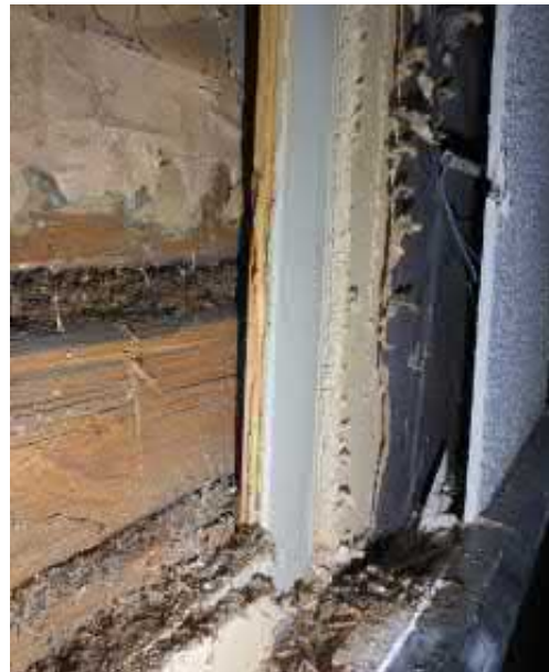
Kuva 4.45/4.46 Avattu seinää Garnin suuntaan, seinärakenne: kipsilevy, kolaus, huokoinen puukuitulevy, helmiponttilausta, hirsi
