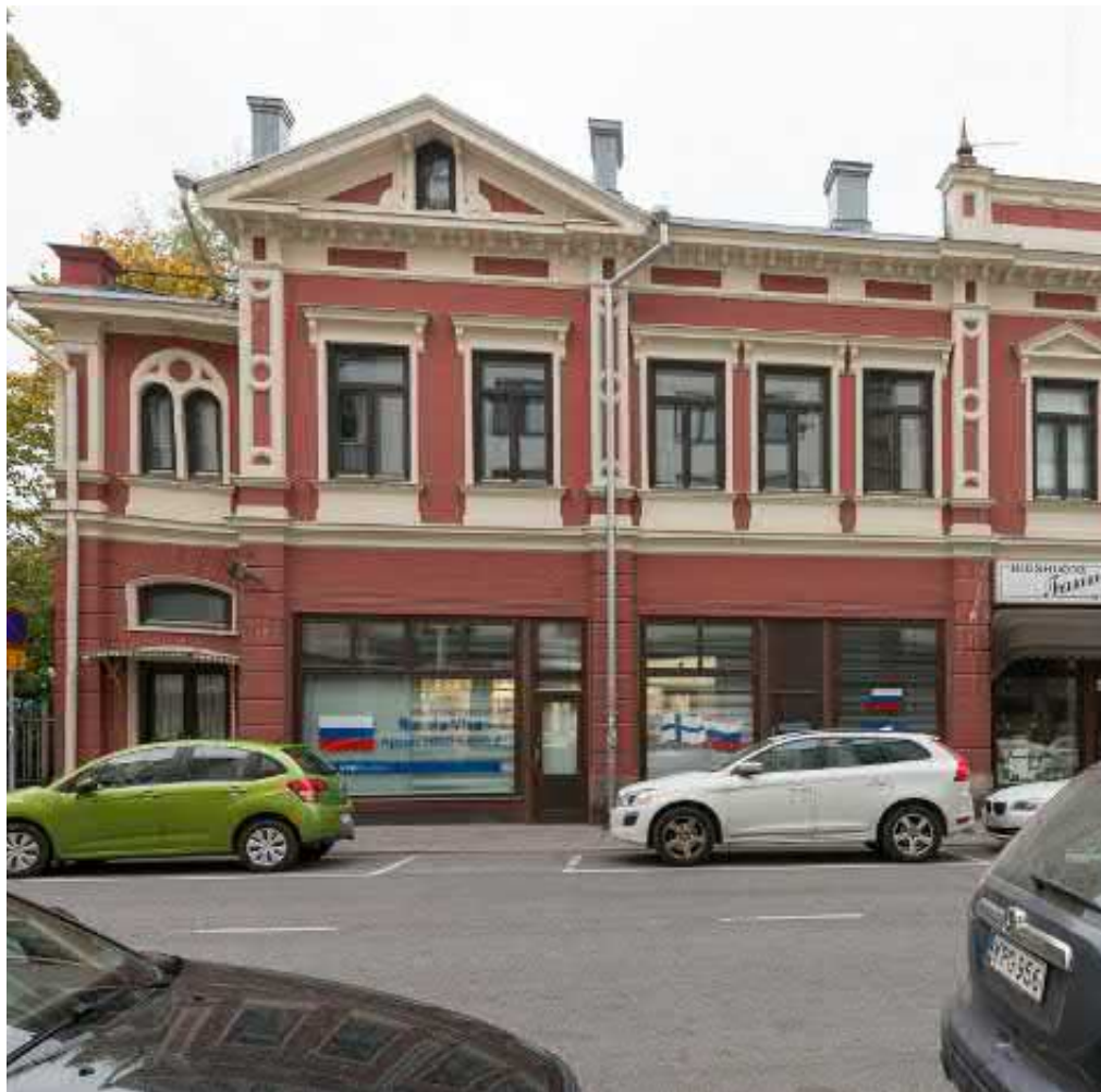
Kuva 3.57 Osa Kristiinankadun julkisivusta
