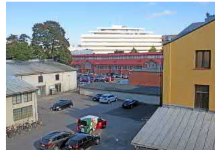
Kuva B.2 Näkymä kulmatalon takaporrashuoneen parvekkeelta
