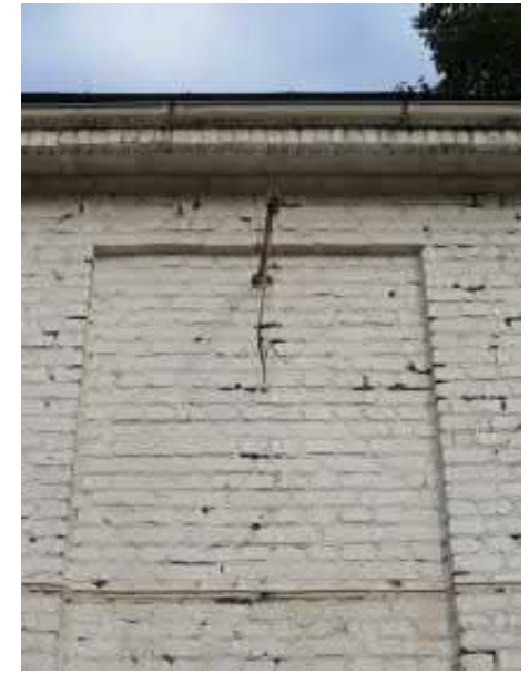
Kuva 6.8 2. kerroksen nostokoukku
