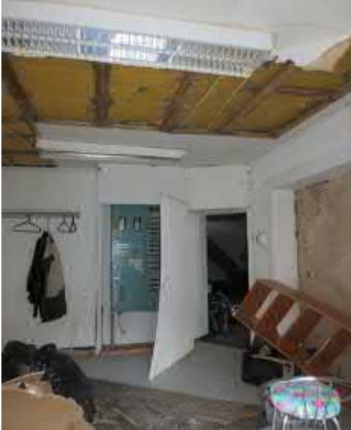
Kuva 5.19 Ent. pajan 1. kerroksen sisäänkäyntiäula
