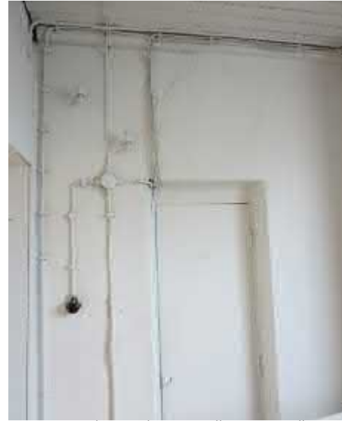
Kuva 3.53 Liike 32: alunperin ulkoseinä ollut seinä, nyk. liikkeen 32 takatilan väliseinä
