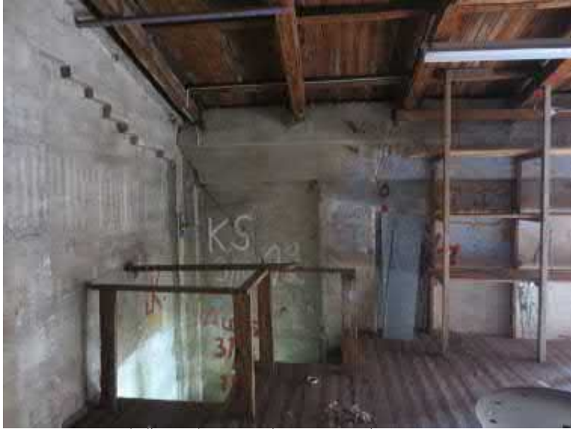
Kuva 6.11 Kauppahallin puoleisen päädyn varasto, 2. kerros
