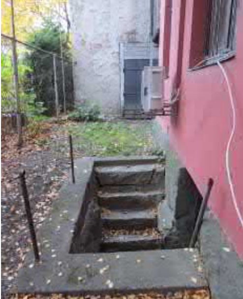
Kuva 3.31 Kellari/liike 33: pohjoispäädystä kellarin sisäänkäynti
