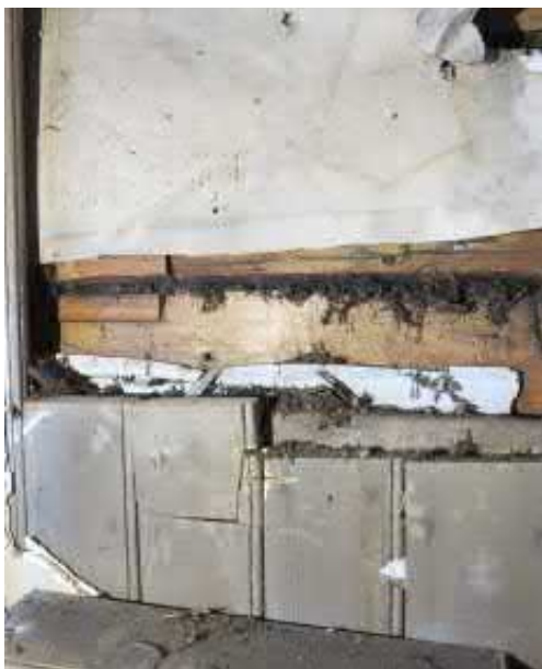
Kuva 4.23/4.24 Seinärakenne kulmatalon suuntaan: kipsilevy, helmiponttilauta, koolaus, tapetti, pinkopahvi, hirsi
