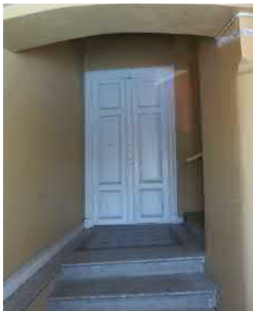
Kuva 3.61 Porrashuoneen ovi 1. kerroksessa
