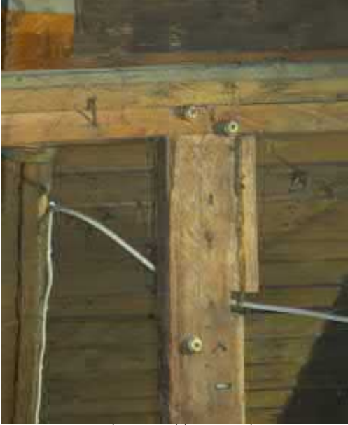
Kuva 4.61 Pystyhirsi ja sähköasennuksia
