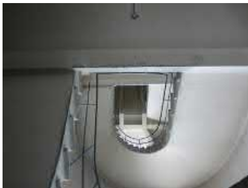
Kuva 1.25 Garnin pihanpuoleinen porrashuone
