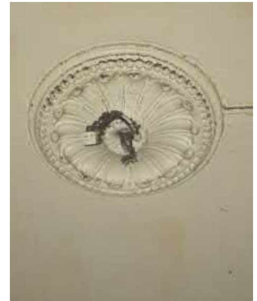
Kuva 3.90 As 35: porrashuoneen kattorosetti 2.krs
