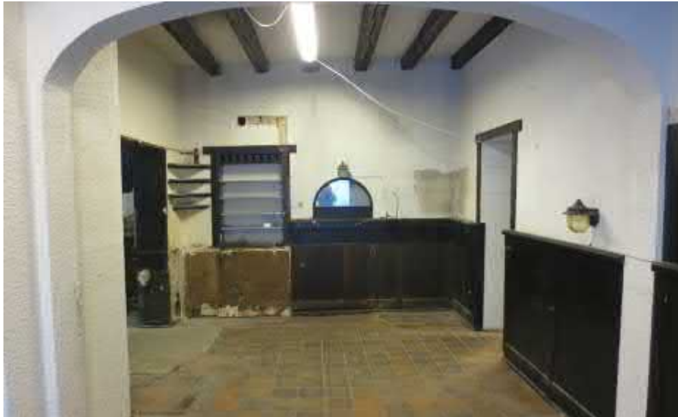
Kuva 4.33 Ravintolasalin 1 seinä vasten kylmiö/varastoa
