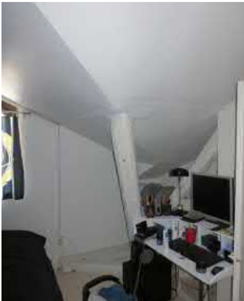
Kuva 3.110 Asunto 25: kattorakenteen tukihirsi
