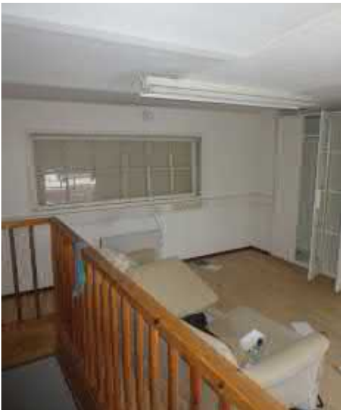
Kuva 5.21 Ent. pajan 2. kerroksen porrashuoneen ikkuna kauppahallin suuntaan
