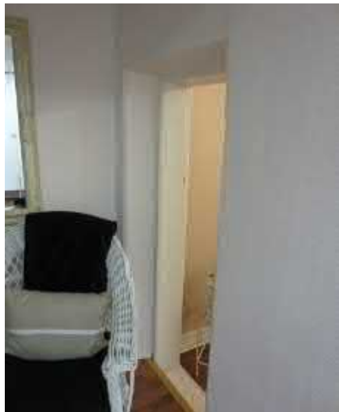
Kuva 3.52 Liike 31: alkuperäinen oviaukko
