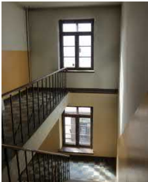
Kuva 2.19 Kulmatalon porrashuoneen ikkunoita
