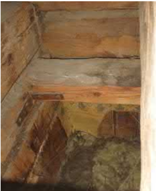
Kuva 4.63 Kulmatalon vastaisessa tilassa näkyvissä vanhaa tapettia alakaton yläpuolella
