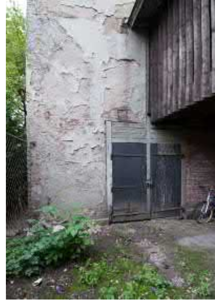
Kuva 5.15 Luhtiaitan 1. kerroksen alkuperäiset varaston ulko-ovet
