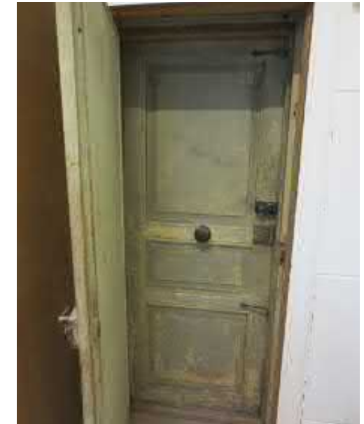
Kuva 3.56 Liike 33: alkuperäinen puuovi sisäpihan puoleiseen porrashuoneeseen
