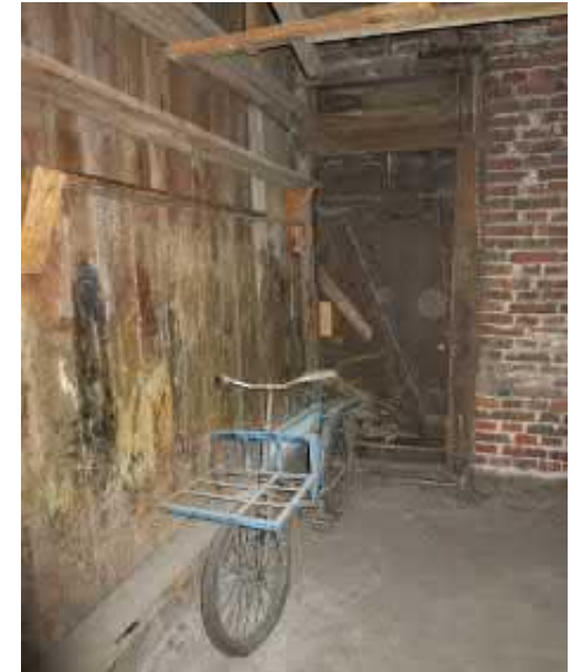
Kuva 5.18 Luhtiaitan 1. kerroksen varasto
