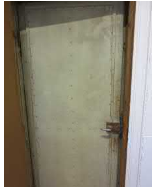
Kuva 3.55 Liike 32: alkuperäinen teräsovi sisäpihan puoleiseen porrashuoneeseen
