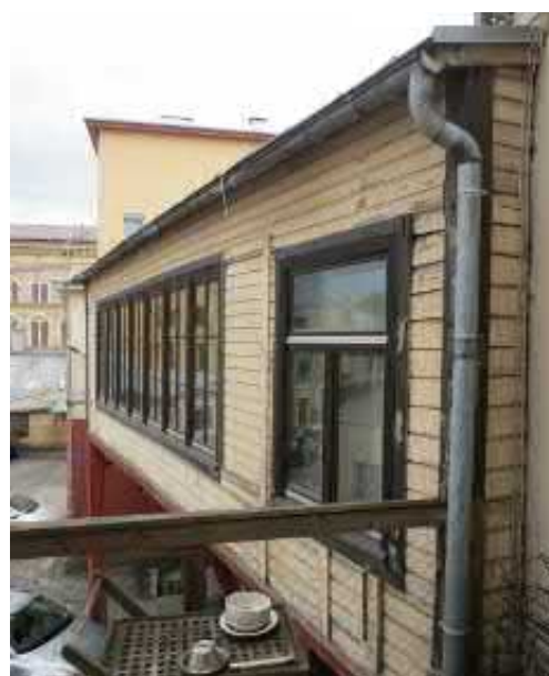
Kuva 3.18 Sisäpihan puoleisen erkkerin julkisivu
