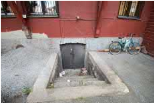
Kuva 3.23 Kellari/liike 30: sisäpihalla kellarin sisäänkäynti
