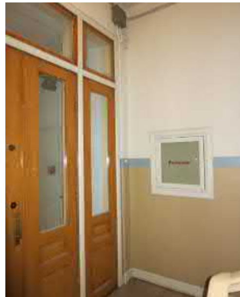
Kuva 1.21 Garnin porrashuone, 2. kerros - seinällä palopostin letkukaappi
