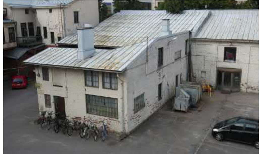
Kuva 5.1 Entisen pajan pääty sisäpihalle
