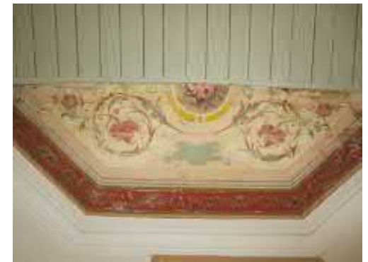
Kuva 3.98 As 35: entisen porrashuoneen säilynyt kattomaalaus
