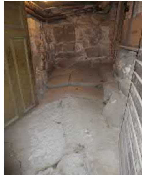
Kuva 3.21 Kellari/liike 29: kellarin betonilattia
