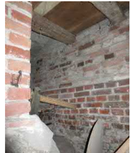
Kuva 3.38 Kellari/liike 33: kellarin pohjoispäätysseinä porrashuoneen alla
