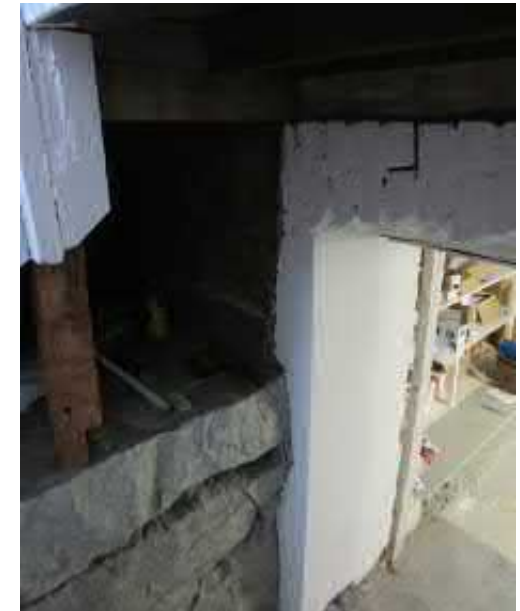
Kuva 3.30 Kellari/liike 32: kellarin kulkuaukko liikkeen 32 kohdalla
