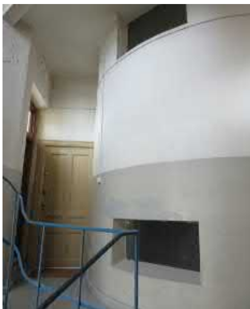
Kuva 1.27 Garnin pihanpuoleinen porrashuone, 2. kerros
