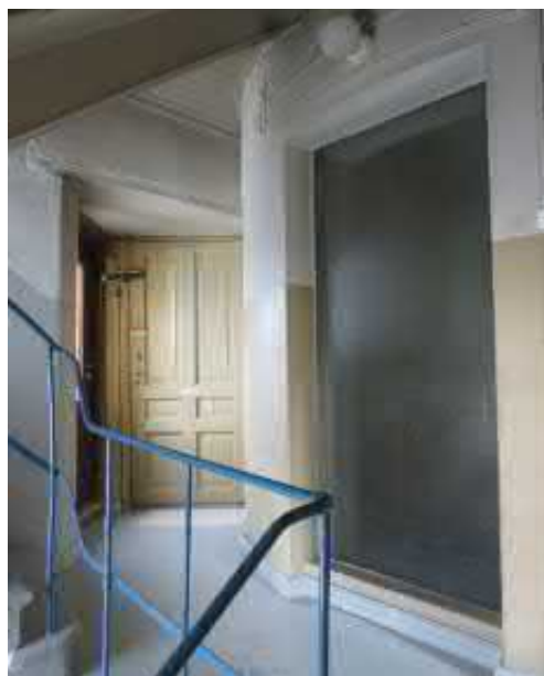
Kuva 1.28 Garnin pihanpuoleinen porrashuone, 3. kerros
