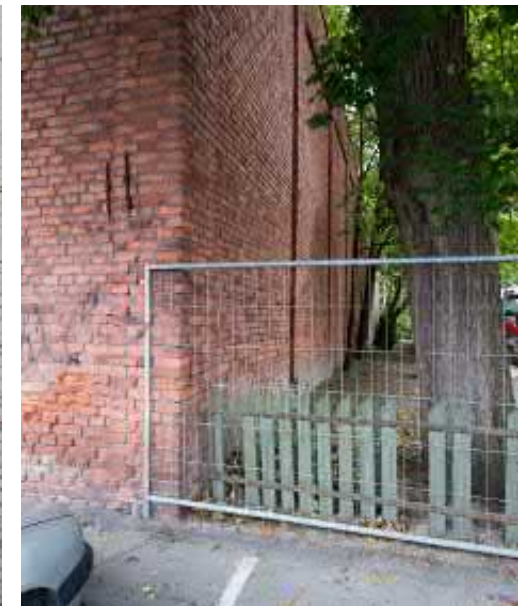
Kuva 6.10 Julkisivu ja tiilimuuri Ravintola Koulun suuntaan
