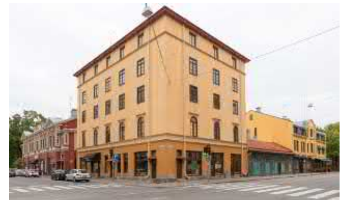
Kuva B.1 Näkymä Linnankadun ja Kristiinankadun kulmasta
