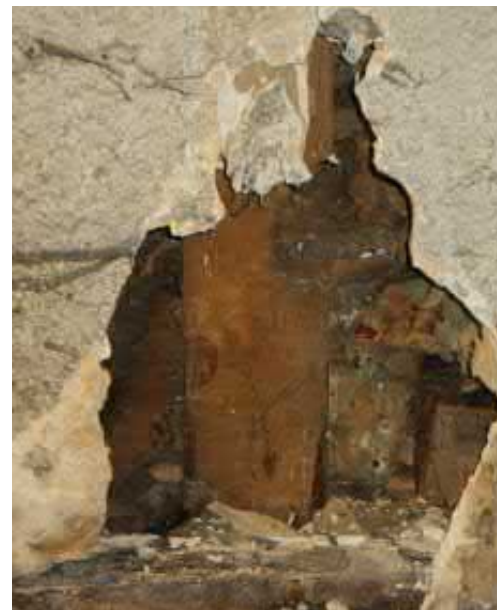
Kuva 4.36 Tarjoilutilan viereinen seinä avattu
