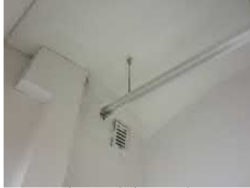
Kuva 3.50 Liike 31: vanha hormin ritilä
