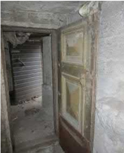
Kuva 3.33 Kellari/liike 33: varaston puupeiliöivi, taustalla kellarin ulko-ovi
