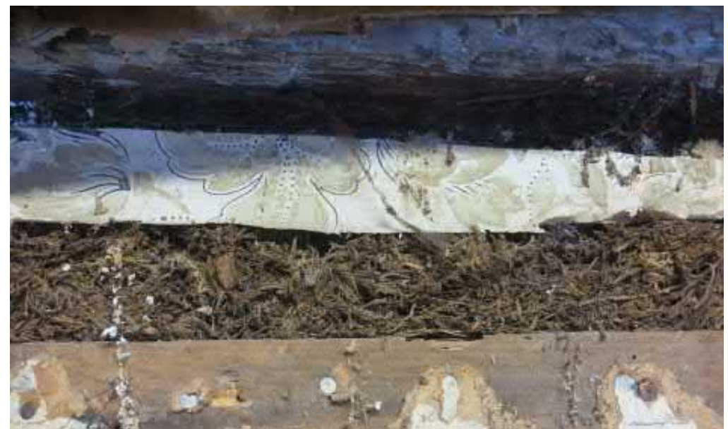
Kuva 4.32 Tarjoilutilan ja keittiön välisen seinän vanha tapetti
