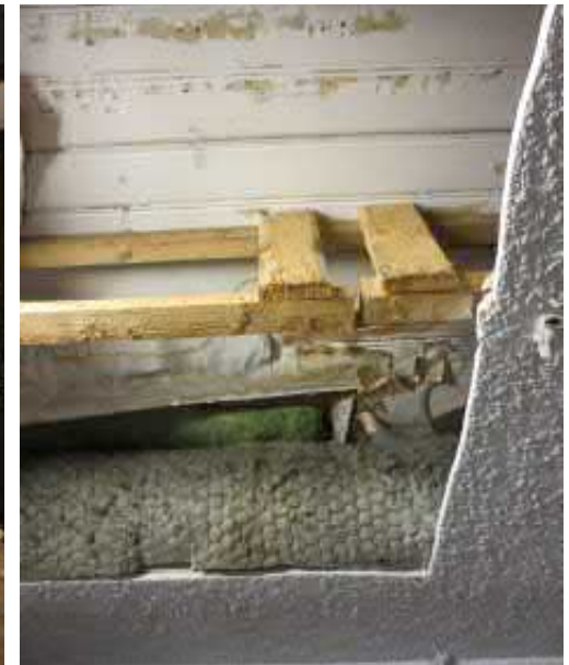
Kuva 4.43 Kabinetin alakatto avattu, austalla vanha helmiponttikatto
