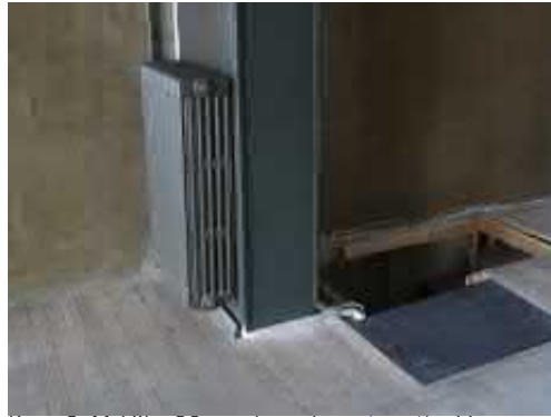
Kuva 3.41 Liike 29: vanha valurautapatteri ja kulkuaukko kellariin
