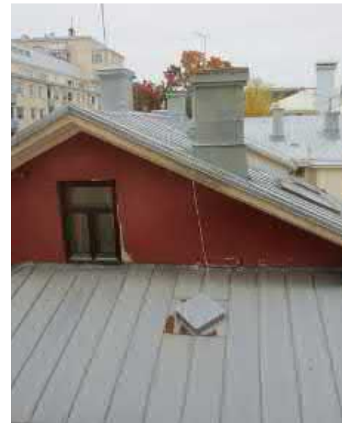
Kuva 3.13 Katiskan talon kattonäkymä
