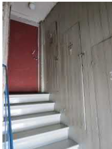
Kuva 1.29 Garnin pihanpuoleinen porrashuone, ullakkokerros
