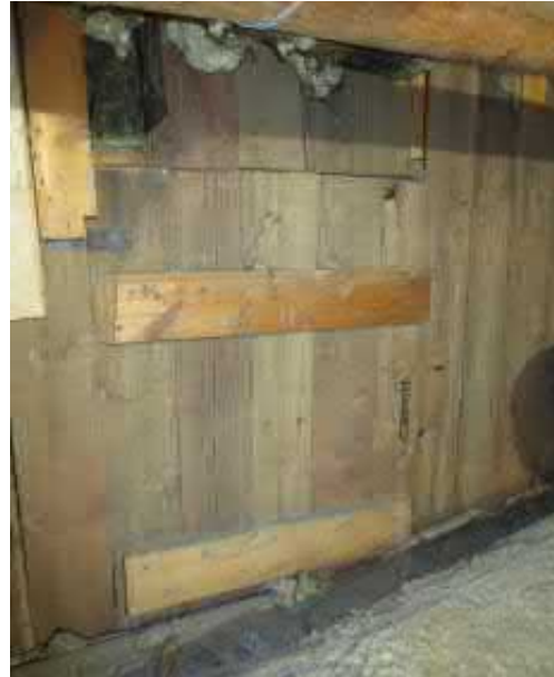
Kuva 4.56 Tarkastusluukku parven suuntaan
