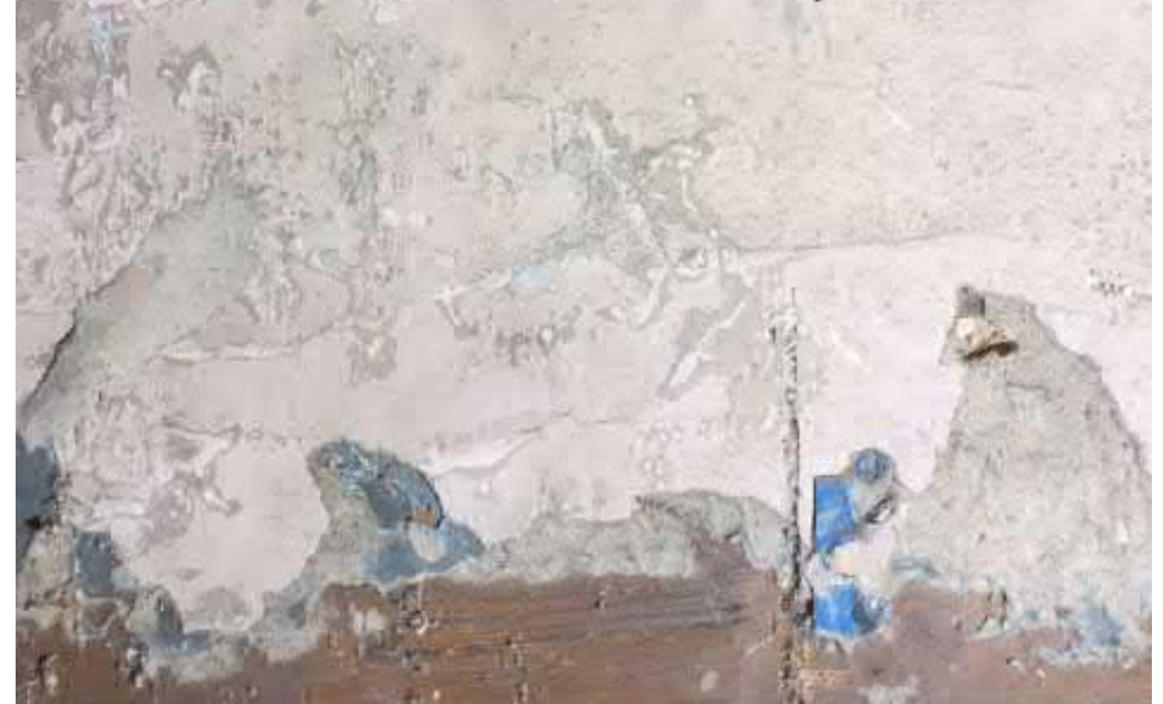
Kuva 4.47 Garnin vastaisen seinän vanhoja tapettikerroksia
