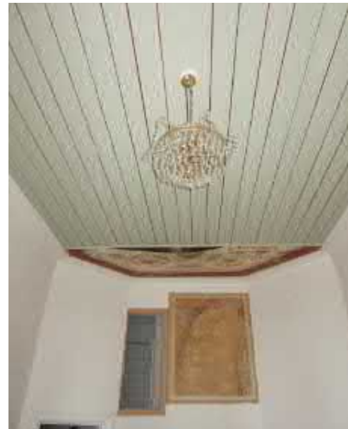
Kuva 3.97 As 34: entisen porrashuoneen katto
