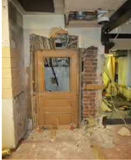
Kuva 4.49 Vanha varaston väliovi
