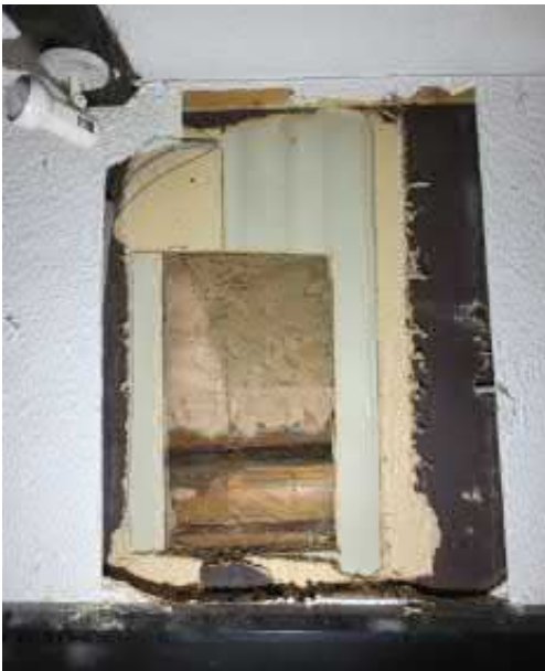
Kuva 4.45/4.46 Avattu seinää Garnin suuntaan, seinärakenne: kipsilevy, kolaus, huokoinen puukuitulevy, helmiponttilausta, hirsi
