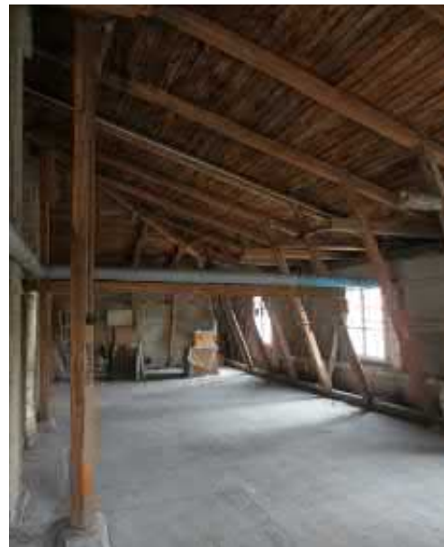
Kuva 2.31 Linnankadun puoleinen ullakko
