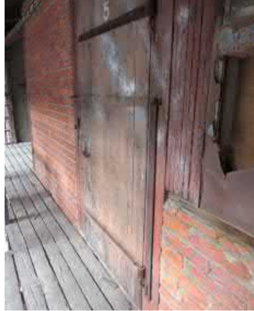
Kuva 5.12 Luhtikäytävän vanha ovi
