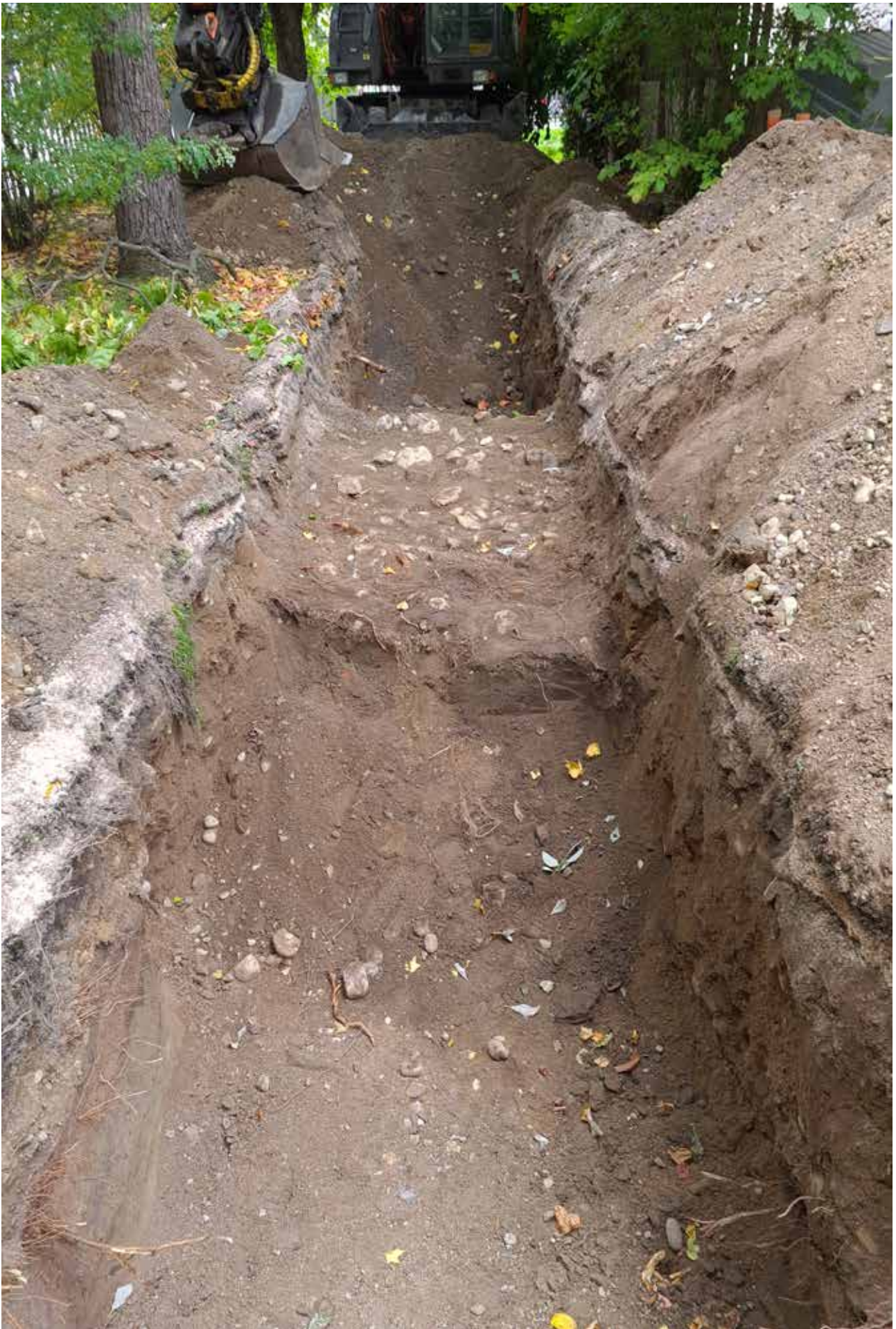
16. Koekuoppa 2, YK kaivannosta. Kaakosta. 23.9.2021 K.Uotila.
