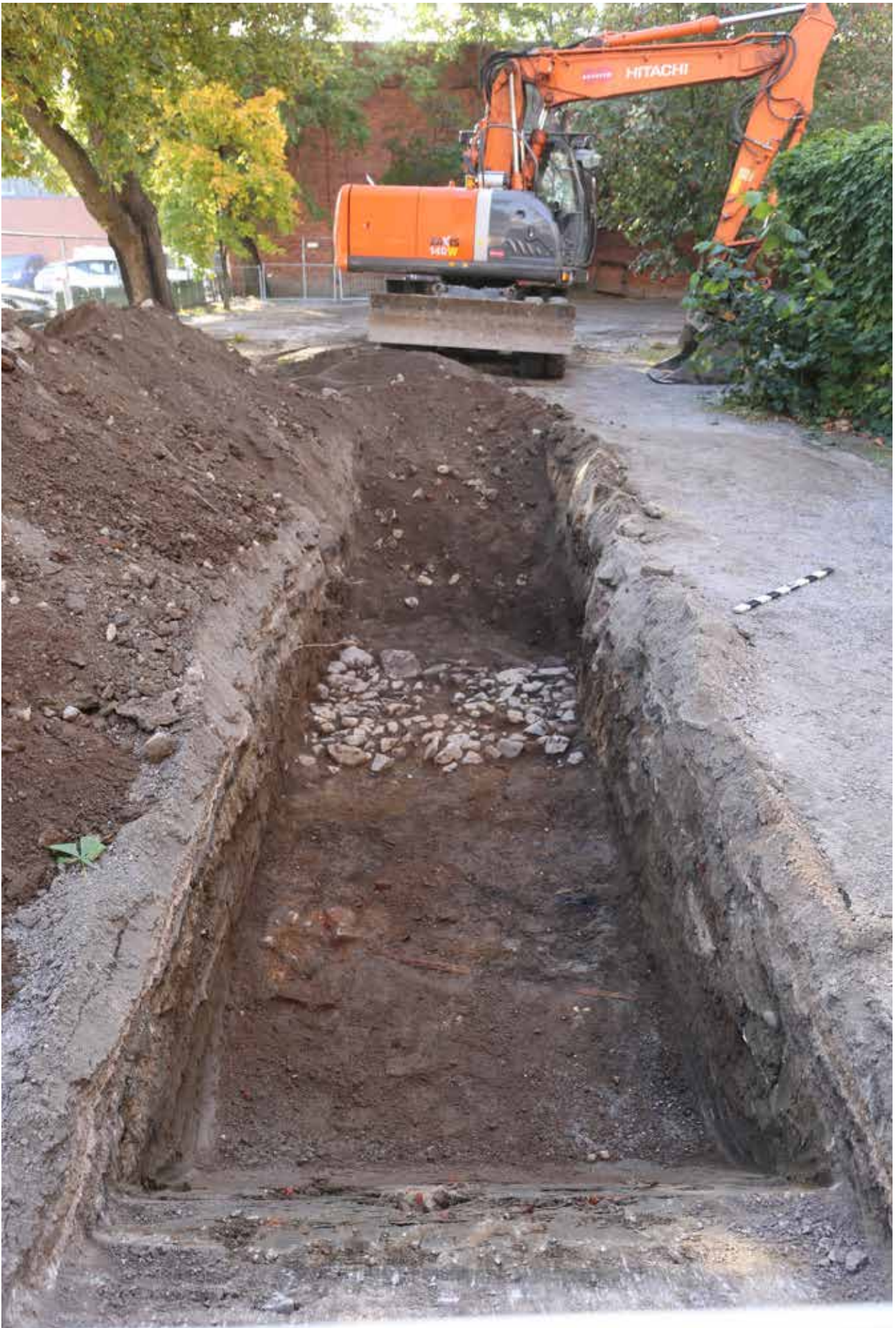
13. Koeoja 1, katukiveyksen R105 jäänteet esiin kaivettuna. Koillisesta. 22.9.2021 J. Joensuu.
