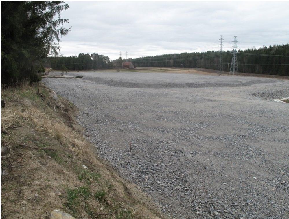
Kuva 5. Topinojan kaatopaikan eteläpuoleinen alue on pitkälti täytetty soralla tulevaa maankäyttöä silmällä pitäen, samalla on tuhoutunut vanha Maarian (nykyään Turun kaupungin puolella sijaitseva) ja Kaarinan välinen vanha rajamerkki. Arvioitu rajamerkin sijaintipaikka on merkitty puupaalulla. Itään.
