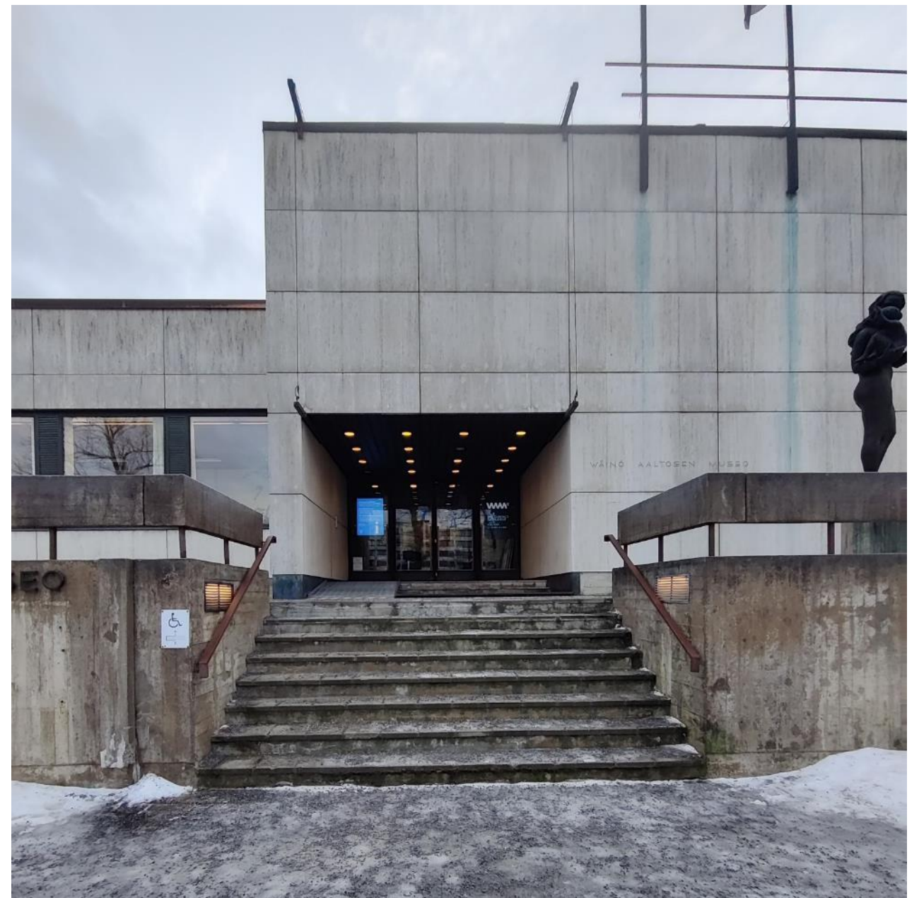
Kuva 75. Museon pääsisäänkäynti. Portaat on päällystetty betonilaatoin. Seinän travertiinipinnoite jatkuu nurkien yli sisäänkäyntisyvennykseen. (Kuva: Kivi Siik)
