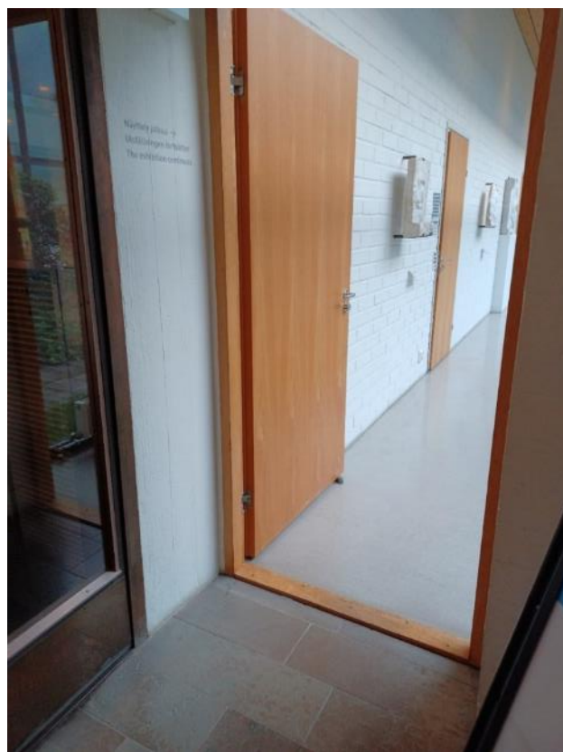
Kuva 112. (vasemmalla) Toimistosiiven aulan puoleinen ovi. (oikealla) Toimistohuoneen ovi. Lattian pintamateriaali ei ole alkuperäinen, sen sijaan tammipuiset laakaovet ovat.
