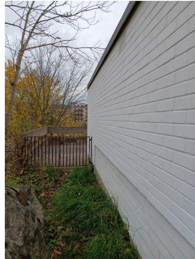
Kuva 151. Rakennuksen päädyssä on portti, josta pääsee kulkemaan etupuolen terassille.
