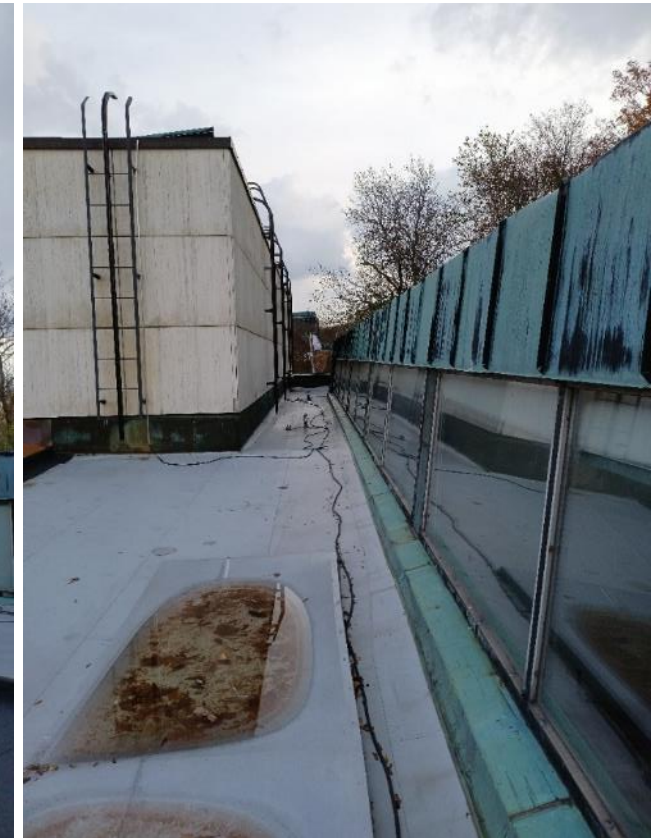
Kuva 63. Uutta ja vanhaa kuparilevyä veistossaliosan ja tasakaton liitoskohdassa.
