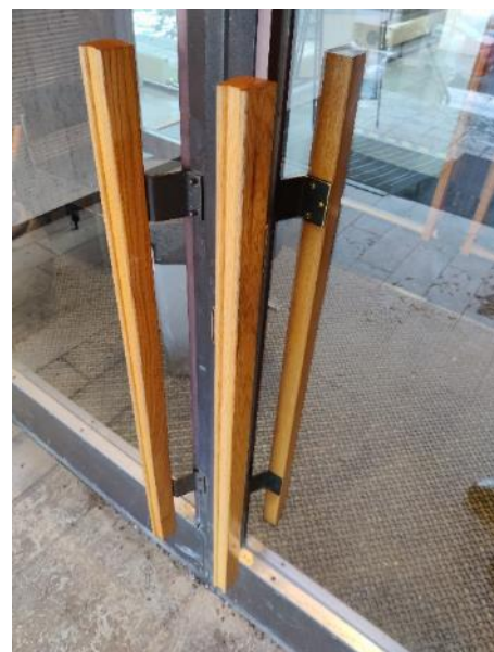
Kuva 77. Pitkät, tammipuiset vetimet. Sisäänkäyntisyvennyksen lattiapinta on laatoitettu Gotlannin kalkkikivellä. (Kuvat: Kivi Siik)
