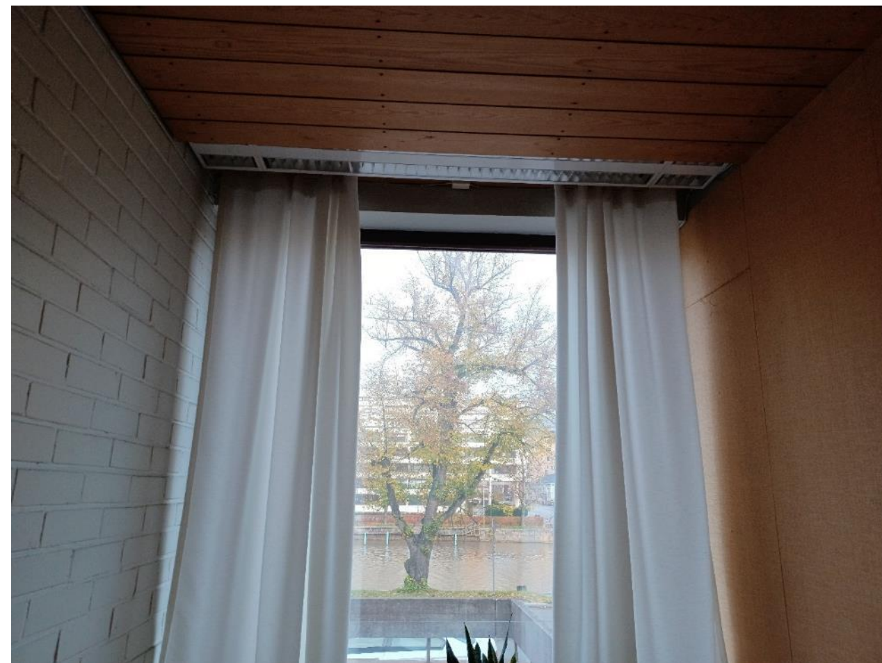
Kuva 113. Pienin huoneista sijaitsee sivusisäänkäynnin vieressä, ja ulkotilan puoleista seinää on eristetty kylmyyden vuoksi. Pinnassa on pellavainen kangastapetti.
