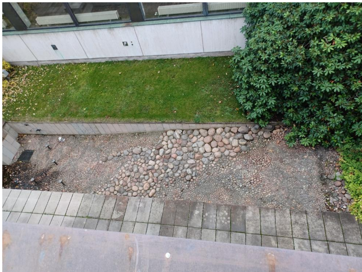
Kuva 59. Atriumpiha katolta kuvattuna. Vesialtaan kiveys on ladottu huolella, ja kivet puhdistetaan normaalisti joka vuosi.
