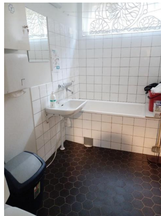
Kuva 159. Kylpyhuoneet ovat lähes alkuperäisessä kunnossa. Lattiat ovat perinteistä kuusikulmaista, tumman punaruskeaa (Pukkilan) klinkkeriä.
