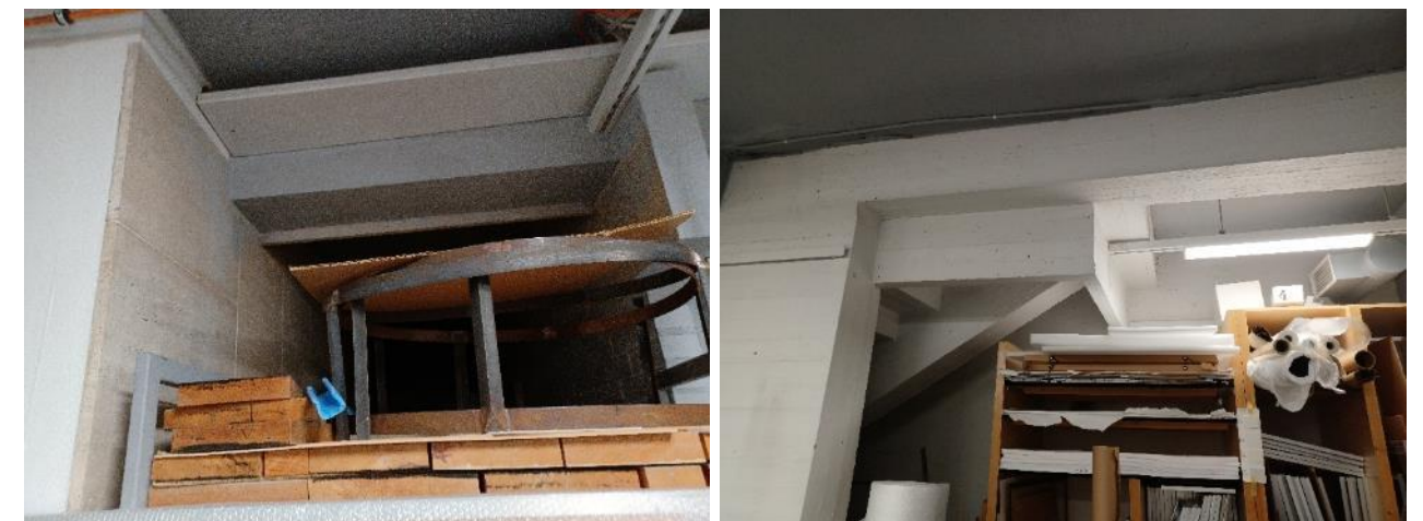
Kuva 32. Vanha portaikko travertiiniseinineen on nähtävissä kellarissa.
