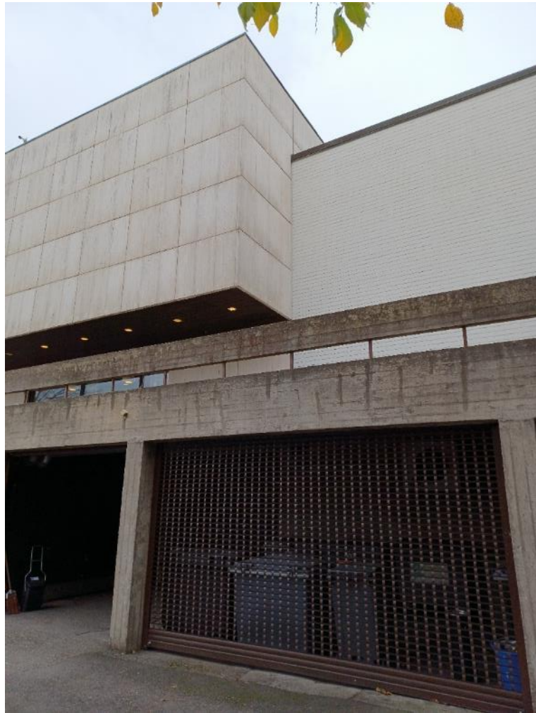
Kuva 54. Lounaispuolen julkisivua: ulosvedetty, travertiinipinnoitettu ylänäyttelysali, jonka alaosassa on kahvio. Tiiliseinän takana on akvaario, ja katutasossa kahvilan terassin alla on jätekatos 2000-luvulla asennetun kalteriseinän takana. Lautamuottiin betonista valettu kaide on päässyt huonoon kuntoon.
