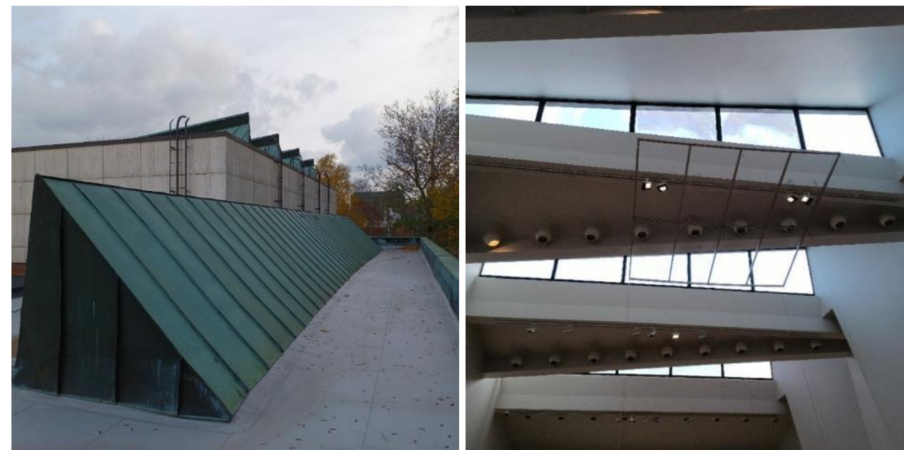
Kuva 72. Veistossalin (korotettu osa vasemmalla) ja gallerian kattoikkunat ulkopuolelta, ja (oikealla) veistossalin kattoikkunat sisältäpäin nähtynä.
