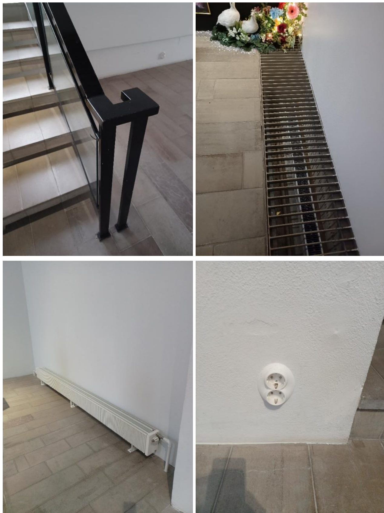
Kuva 110. Alkuperäistä ja uusittua. Näyttelytilojen yksityiskohtia: Ylhäällä vasemmalla gallerian portaikon kaidedetalji, oikealla alkuperäinen, lattiaan upotettu lämpöpatteri, alhaalla vasemmalla veistossalin uusittu lämpöpatteri ja oikealla uusittu, "uusvanha" pistorasia.
