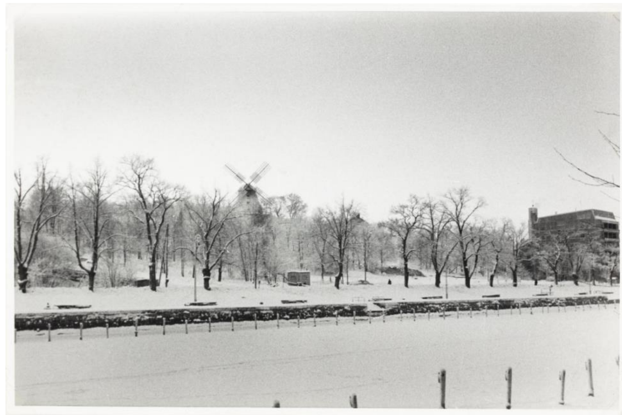
Kuva 14. Museon tontti ennen rakentamista vuonna 1964. (Turun museokeskus)
