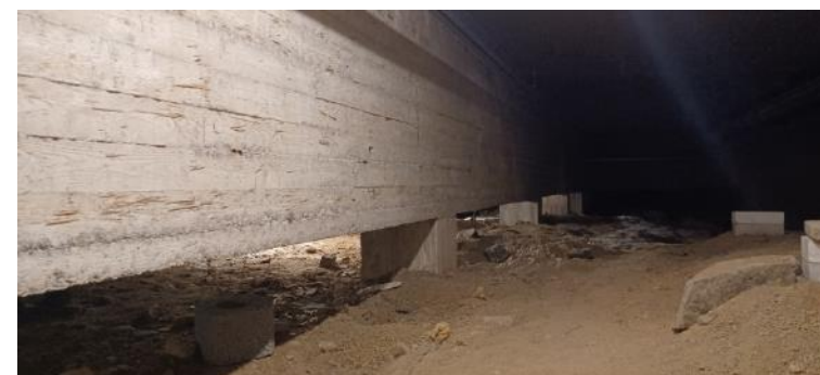
Kuva 52. Perustuksia ryömintätilassa. Muottilaudoitettu, raudoituksin vahvistettu betoni on paitsi julkisivun muurien, myös sokkeleiden rakennusaine.
