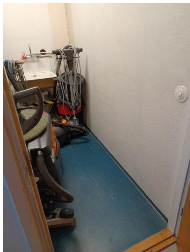
Kuva 130. Siivouskomeron lattiassa on jäljellä muovimattoja, joka on työntekijöiden muistikuvan mukaan todennäköisesti samaa kuin kahvilassa on ollut.
