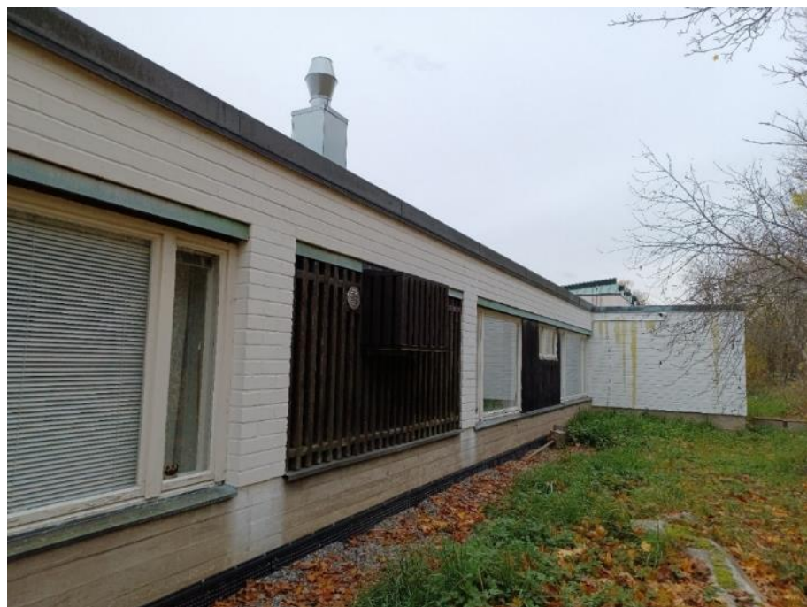
Kuva 157. Etelän puoleista julkisivua rakennuksen takana. Museon veistossalin kattorakenteet näkyvät kuvassa rakennuksen katon reunan yläpuolella oikealla.
