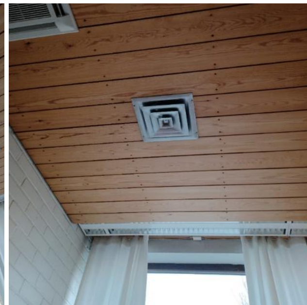
Kuva 114. Toimistohuoneiden puupaneloiduissa sisäkatoissa on nähtävissä uutta ja vanhaa ilmanvaihdotekniikkaa.
