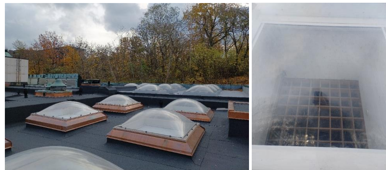
Kuva 73. Kuplaikkunat vesikatolta nähtynä. Näidenkin kaulukset on pellitetty kuparilla. Kuplaikkunasta näkyy puuristikko, jonka läpi valo siivilöityy näyttelysaliin.
