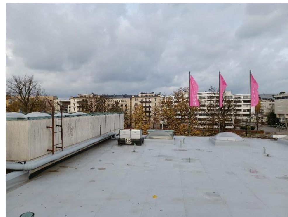
Kuva 65. PVC-muovilla pinnoitettua kattopintaa.
