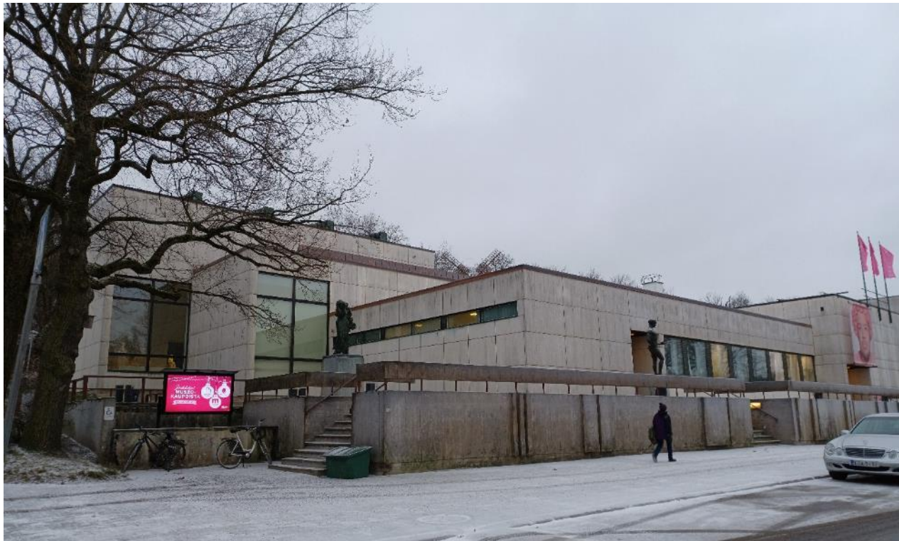
Kuva 55. Itäisen Rantakadun puoleista julkisivua pohjoisen suunnasta kuvattuna.
