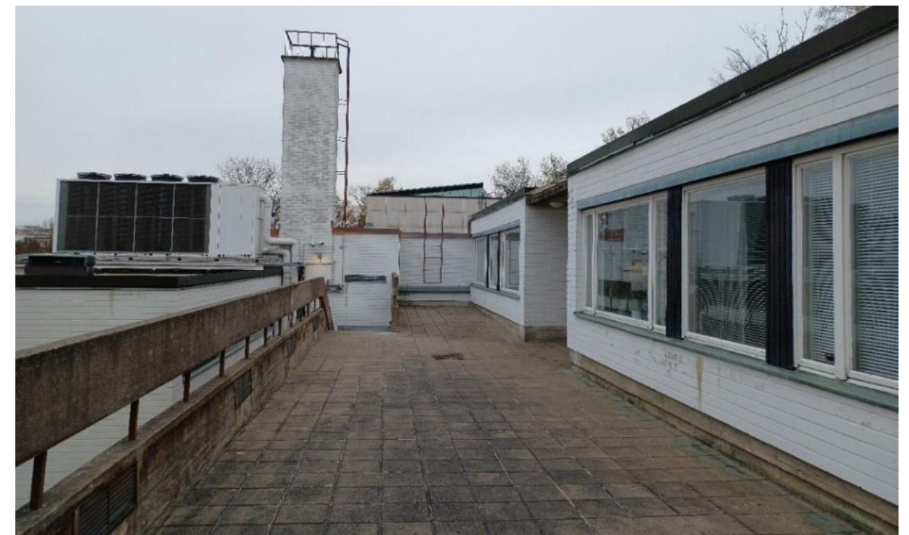
Kuva 148. Rakennuksen luoteispuolen julkisivua (oikealla). Takana keskellä museorakennuksen veistossali.
