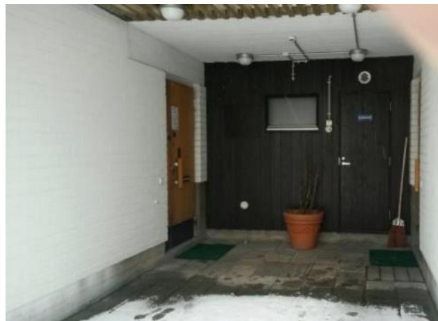
Kuva 154. Kuva sisäänkäynnistä vuodelta 2015, ennen tuulikaapin rakentamista.
