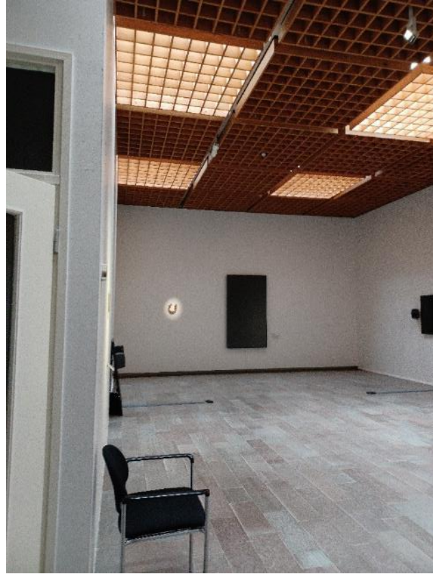
Kuva 105. Valo siivilöityy näyttelysaleihin katossa olevien puusäleikköjen kautta. Valonlähteenä toimivat joko valaisimet tai kuplaikkunoista tuleva luonnonvalo.
