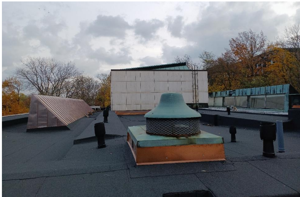
Kuva 62. (kuvat ylhäällä ja alhaalla) Kattorakenteita: mustaa bitumihuopaa ja ulkonevien ”kattolyhtyjen” uu- sia sekä jo hapettuneita eli tummineoita kuparipeltipintoja. Korkeamana erottuva travertiiniseinäinen raken- nusmassa on veistossali, ja sen päällä näkyy sahalaistaista, kuparipinnoitettua kattoikkunaa.
