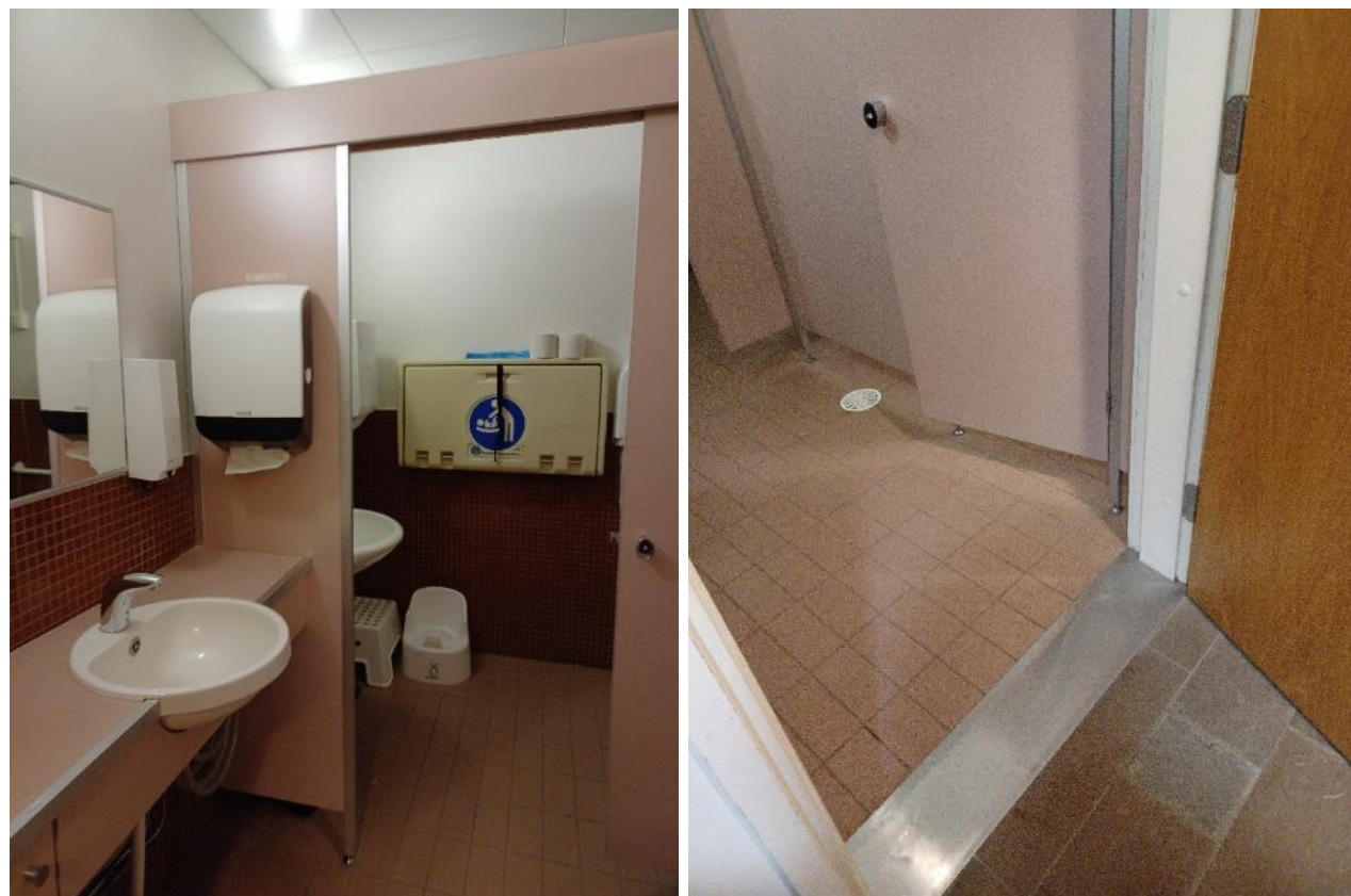
Kuva 129. Pääaulan naulakoiden vieressä olevat yleiset käymälätilat on uusittu 2000-luvulla. Sävyt eivät vastaa alkuperäisiä.
