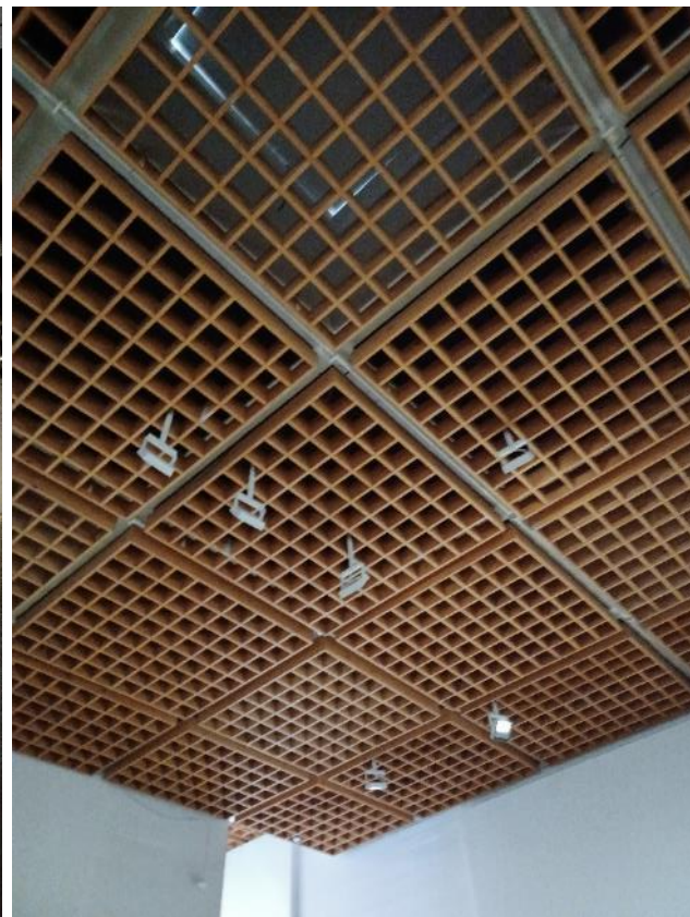
Kuva 106. (vasemmalla) Näkymä taaemmasta näyttelysalista kohti keskimmäistä galleriaa. (oikealla) Näyttelysalin kattoristikkoa, joiden päällä ovat kuplaikkunat on pimennetty.
