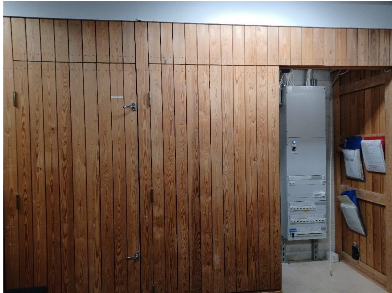
Kuva 147. Pintakäsitlemätön, höylätty puupanelointi toistuu museon tiloissa (vrt. toimistohuoneiden katot), ja kellaritiloihin siitä on tehty tyyliin sopiva, seinään upotettu komero, johon on piilotettu sähkötekniikkaa.
