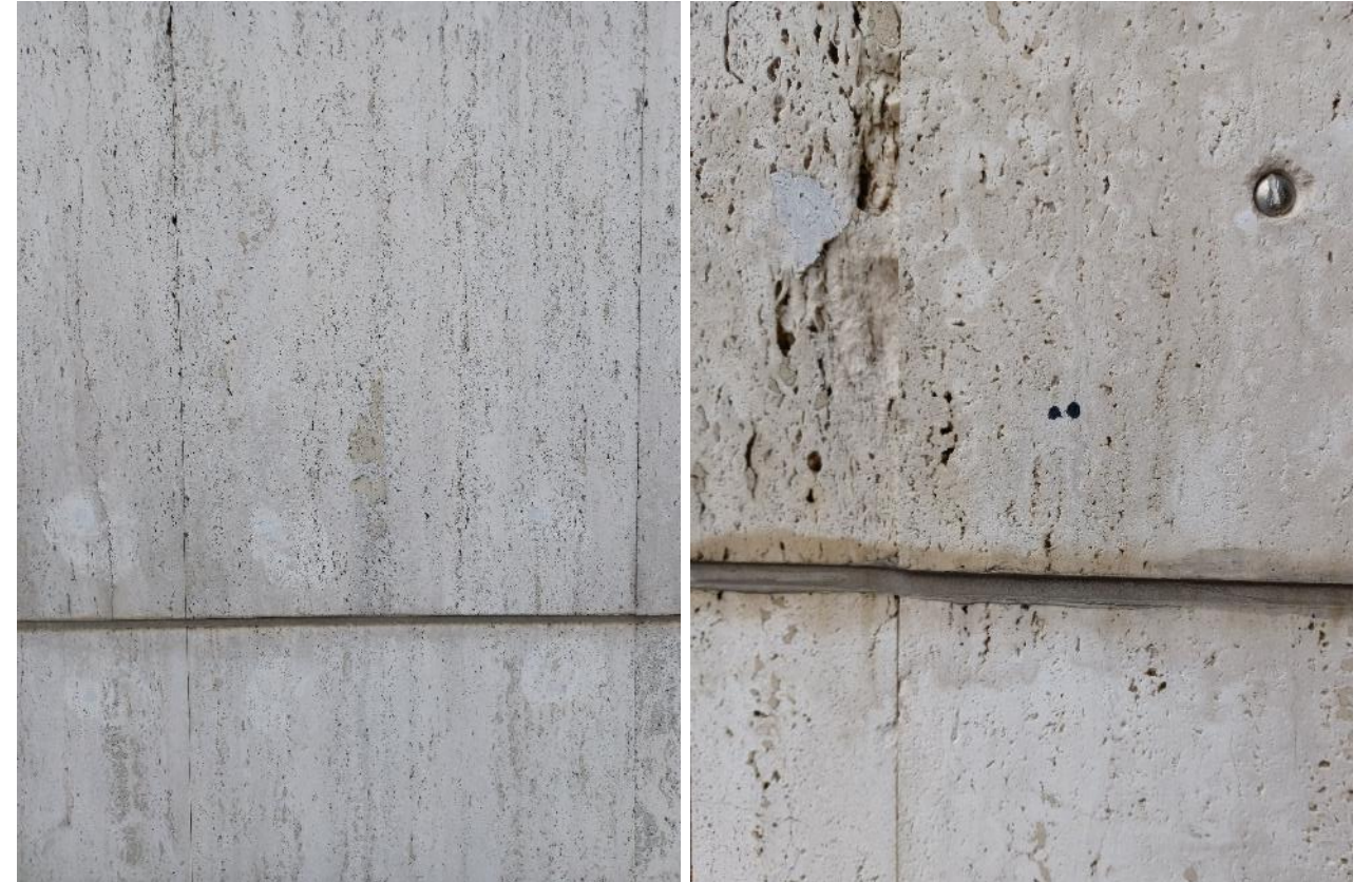
Kuva 56. Travertiinilevyt on kiinnitetty ruuvein. Ruuvinkannat on kitattu ja hiottu siloitteella, joka on hieman eri sävyistä kuin seinä. Kitatut kiinnityskohdat on hiottu, ja ne ovat jääneet seinäpintaa vaaleammiksi.
