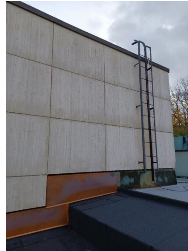
Kuva 63. Uutta ja vanhaa kuparilevyä veistossaliosan ja tasakaton liitoskohdassa.
