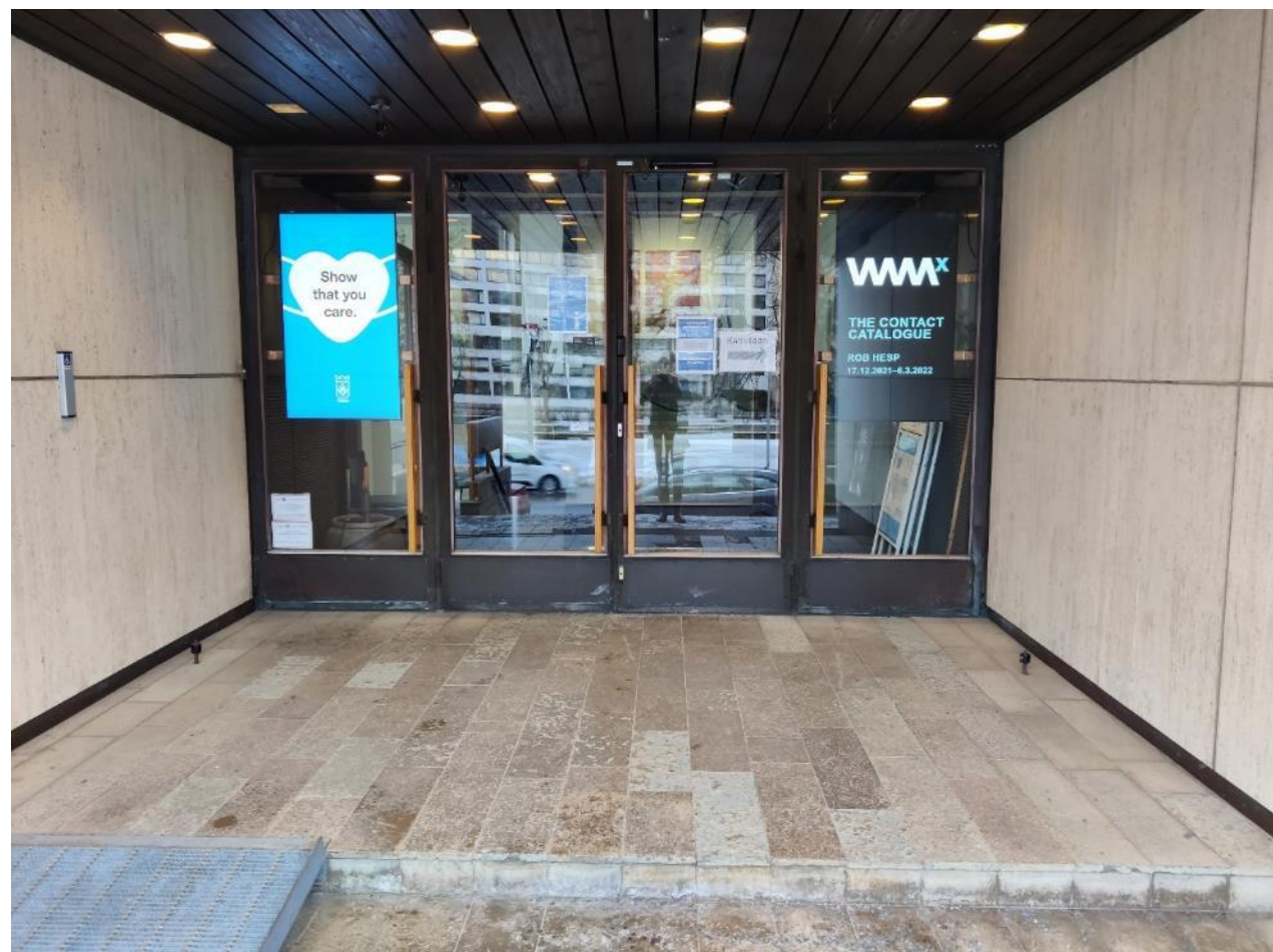
Kuva 76. Pääsisäänkäynti tummasävyisine lasiovineen. Travertiinipinta jatkuu nurkan yli syvennykseen, mutta tuulikaappien seinät on pinnoitettu kuparilevyin. (Kuva: Kivi Siik)
