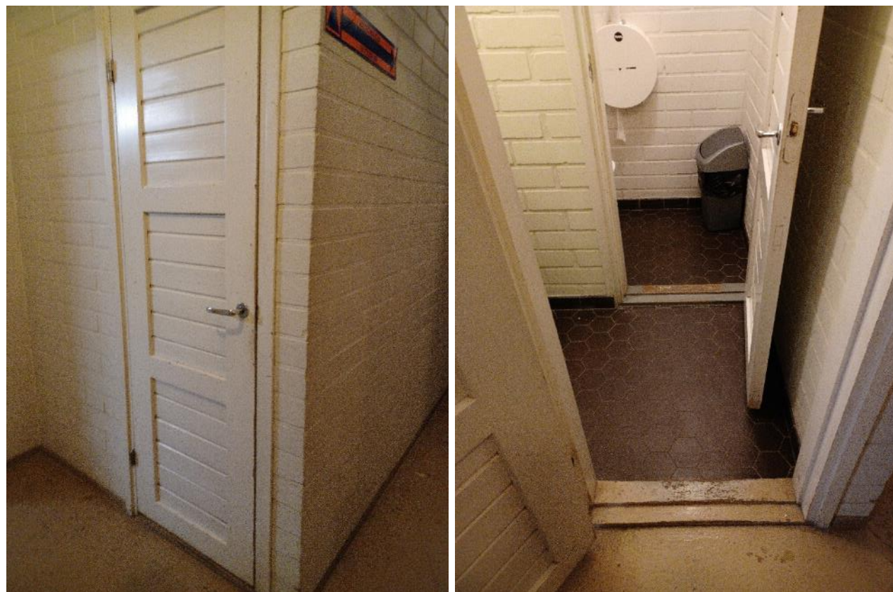
Kuva 138. Wc:n ovet ja pinnat ovat alkuperäisiä.
