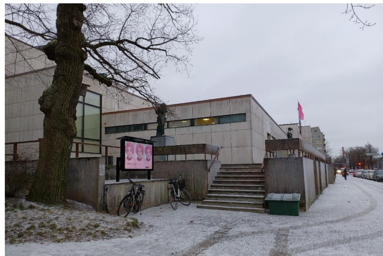
Kuva 174. Itäisen Rantakadun suuntainen näkymä museon pohjoisnurkalta. Kuvassa näkyvät portaat johtavat terassille ja sitä pitkin museon sisäänkäynnille.
