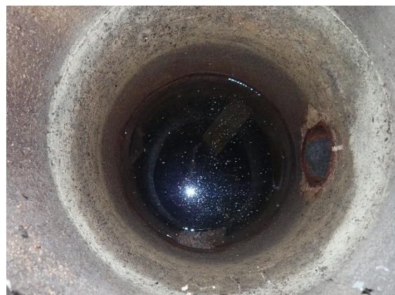
Kellarikerroksen sadevesijärjestelmän tarkastuskaiivosta havaittiin purkuputken olevan kokonaan veden pinnan alla.
