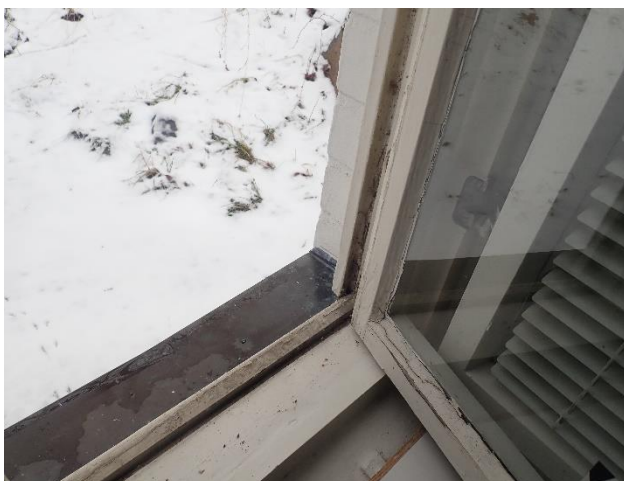
Ylärinteen puolelta ulkoseinärakenne on maanvastainen.
