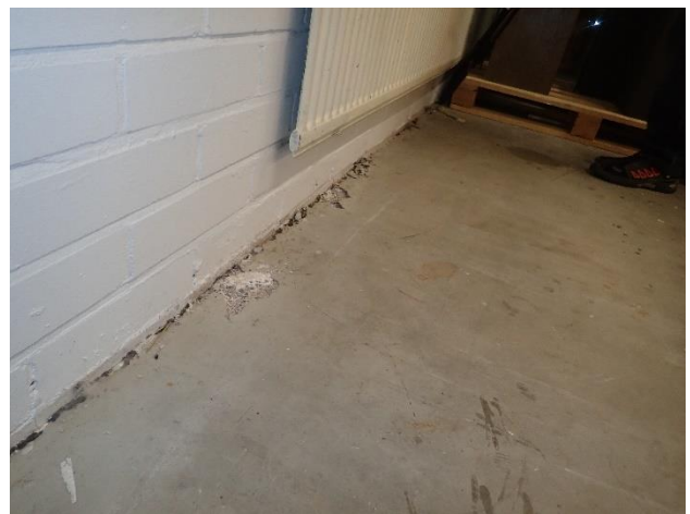
Kellarikerroksen tiloissa havaittiin kosteuden aiheuttamia jälkiä ja mm lattian rakenteen murtumaa.
