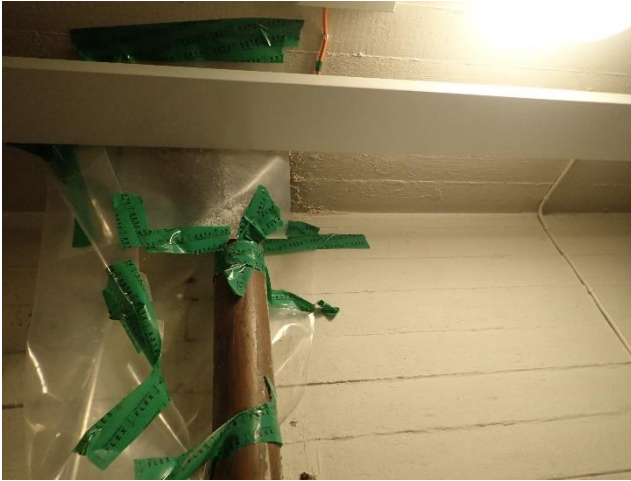
Katon vuotokohtia oli ”paikattu” teipillä ja muovilla sisäpuolelta. (kuva käytävältä tilan 137 ulkopuolelta)
