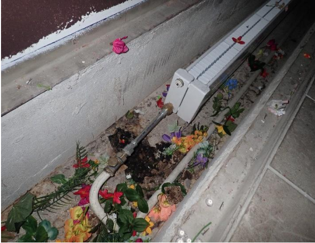
Lämpöpattereita on uusittu sitä mukaa kun niitä on rikkoutunut
