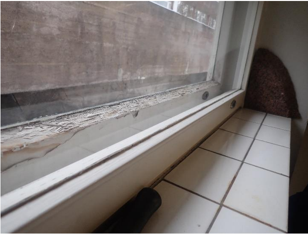
Toimistojen puupuitteiset ikkunat ovat huonokuntoisia (kuva tilasta 139A)
