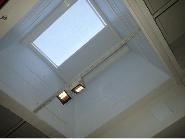
Kattoikkunoista havaittiin useasta kohdin kondenssi ja vuotoveden aiheuttamia vesijälkiä.
