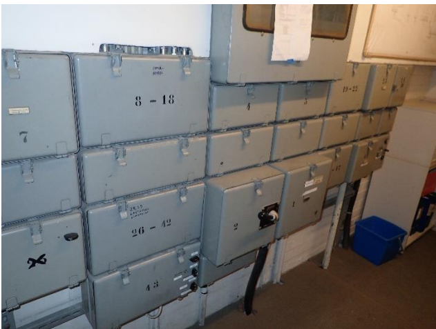
Sähkön syötön pääsähkökeskus on uusimatta mutta siinä ei ole havaittavaa vikaa.
