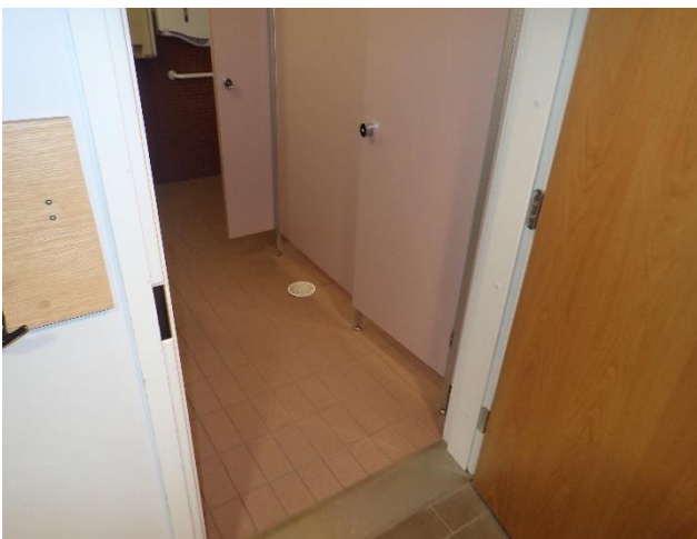
Museon asiakas wc:issä havaittiin voimakasta viemärin hajua. Hajua oli erityisesti naisten puolen wc:ssä.
