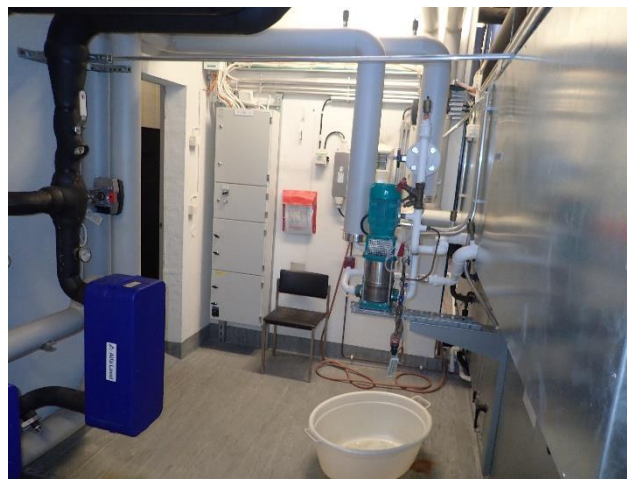
Osa tiloja palvelee suuret ilmanvaihtokoneet (2. kerroksen IV-konehuone)
