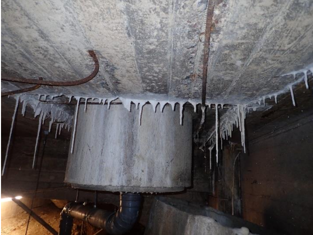
Rakennuksen alustaan johtuu sadevesiä terassin ja vuotavien sadevesiyhteiden kautta
