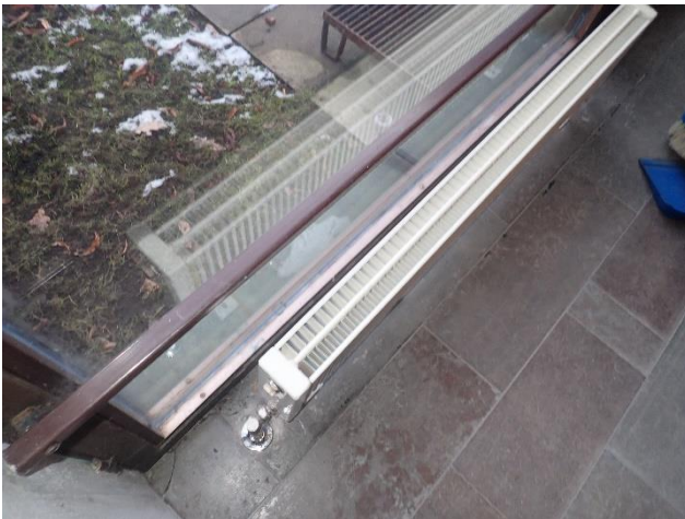
Sisääntuloaulan lattialaatoitus on paikoin rikki
