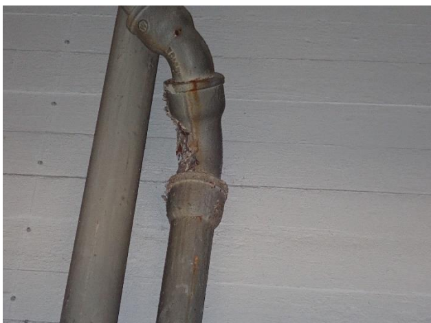
Osa viemäriputkista on vanhoja ja ne vuotavat (lämmönjakuhuone)
