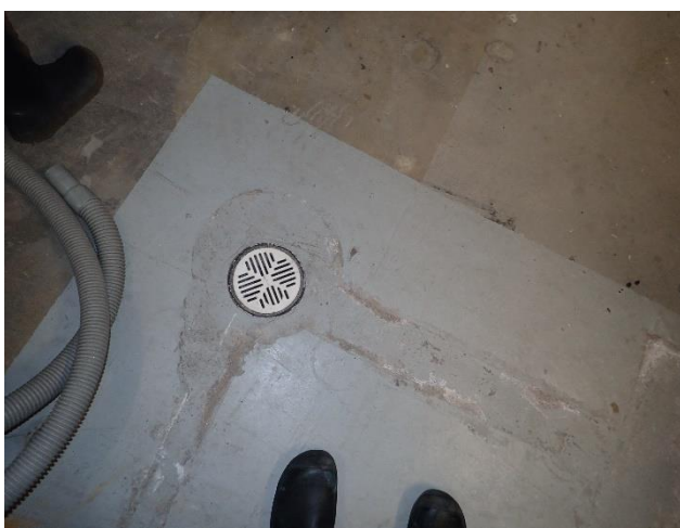
Kellarikerroksen lattiaan on tehty kaivo, josta tulvii välillä sadevettä tilaan
