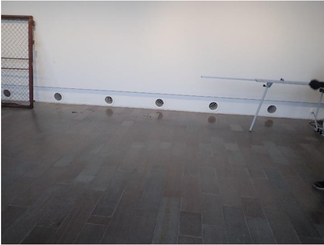
Näyttelytilan poistoilma on järjestetty lattian rajasta.
