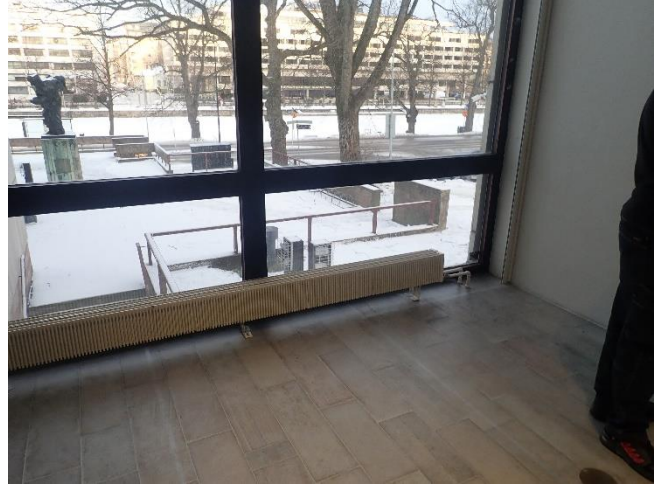
Ikkunapuitteen rakenne aiheuttaa kylmäsillan, johon kondensoituu vettä
