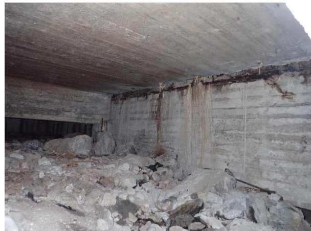
Sisemmässä sokkelissa havaittiin halkeilua ja veden aiheuttamia vaurioita
