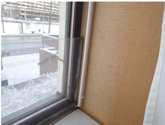
Toimistotilan vetoisuutta oli koitettu vähentää ikkunan eteen asennetulla pleksillä
