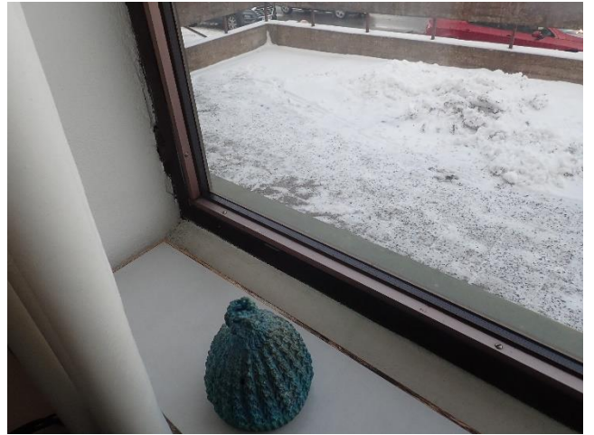
Teräspuitteisten ikkunoiden pielirakenne on lohkeillut (tila 112)
