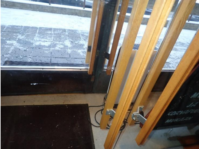
Kahvion tuulikaappiin muodostuu jäätä pakkasella. Erillisellä sähkölämmittimellä koitetaan estää jään syntymistä.
