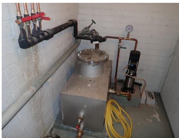
Atriumpihan vesiaiheen putkia ja pumppuja on uusittu
