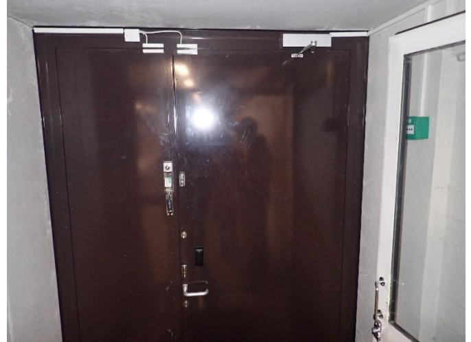
Kellarikerroksen uloskäynnin ovi on uusittu.
