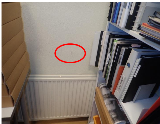
Kirjaston viereisen tilan seinässä havaittiin pinnonitteen hilseilyä
