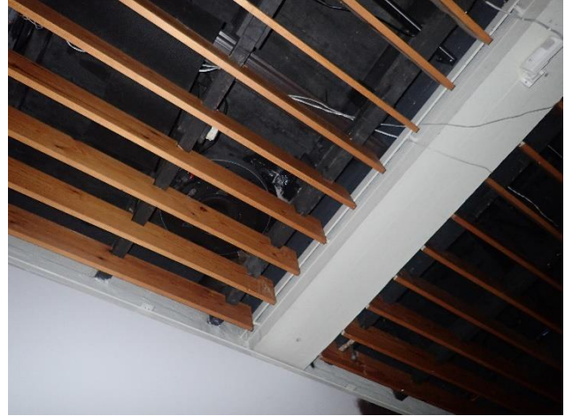
Vuotaneiden kattovesikaivojen vesivahinkoja ei ole korjattu vaikka kaivo ei enää vuotaisikaan..
