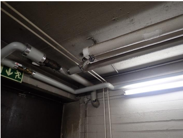
Vanhimmissa putkieristeissä saattaa olla asbestia. Osa putkistoista on uusittu
