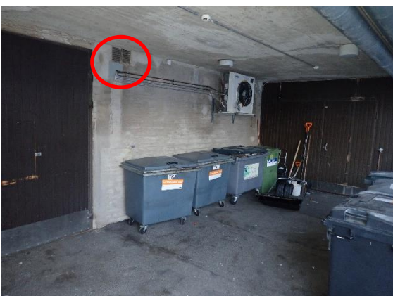
Raitisilmaventtiilit sijaitsevat jäteastioiden kanssa samassa katoksessa.
