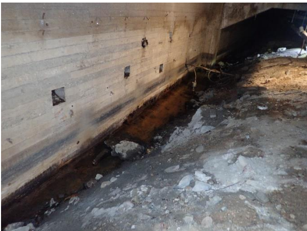
Ulkopuolisen sokkelirakenteen (Itäinen Pitkäkatu, terassin alla) sisäpuolelle kertyy vettä.
