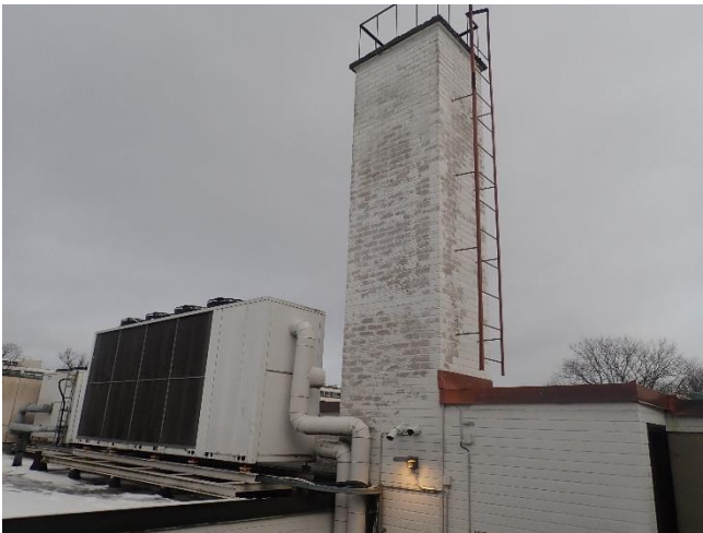
Talotikkaat ovat teräsrakenteisia.
