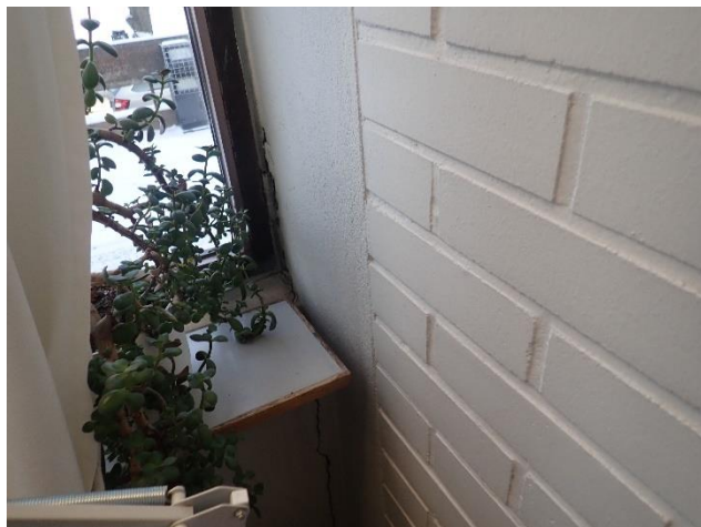
Yhden toimistohuoneen kohdalla ulkoseinässä on suuri halkeama.
