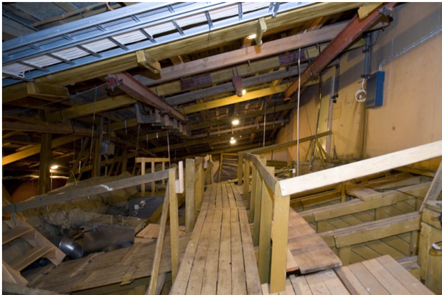
Yllä: Hissikatos ja varastolaajennus. TMK. Alla: Ullakko. TMK.
