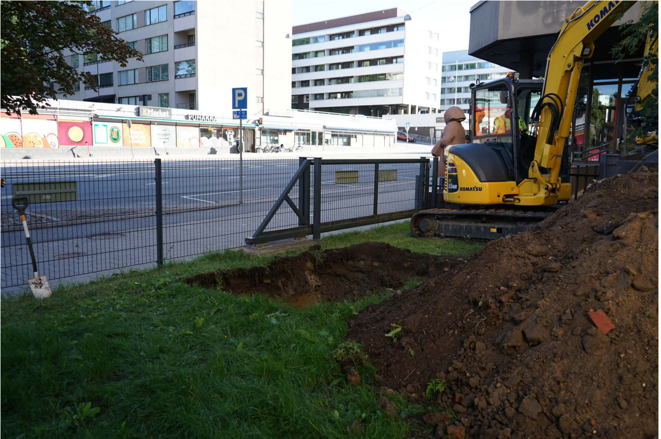
MuTu122027_1. Alue 6a. Yleiskuva, taustalla Hämeenkatu, kaivinkone pelastustien päällä. Etelästä, 12.7.2022, M. Helamaa.
