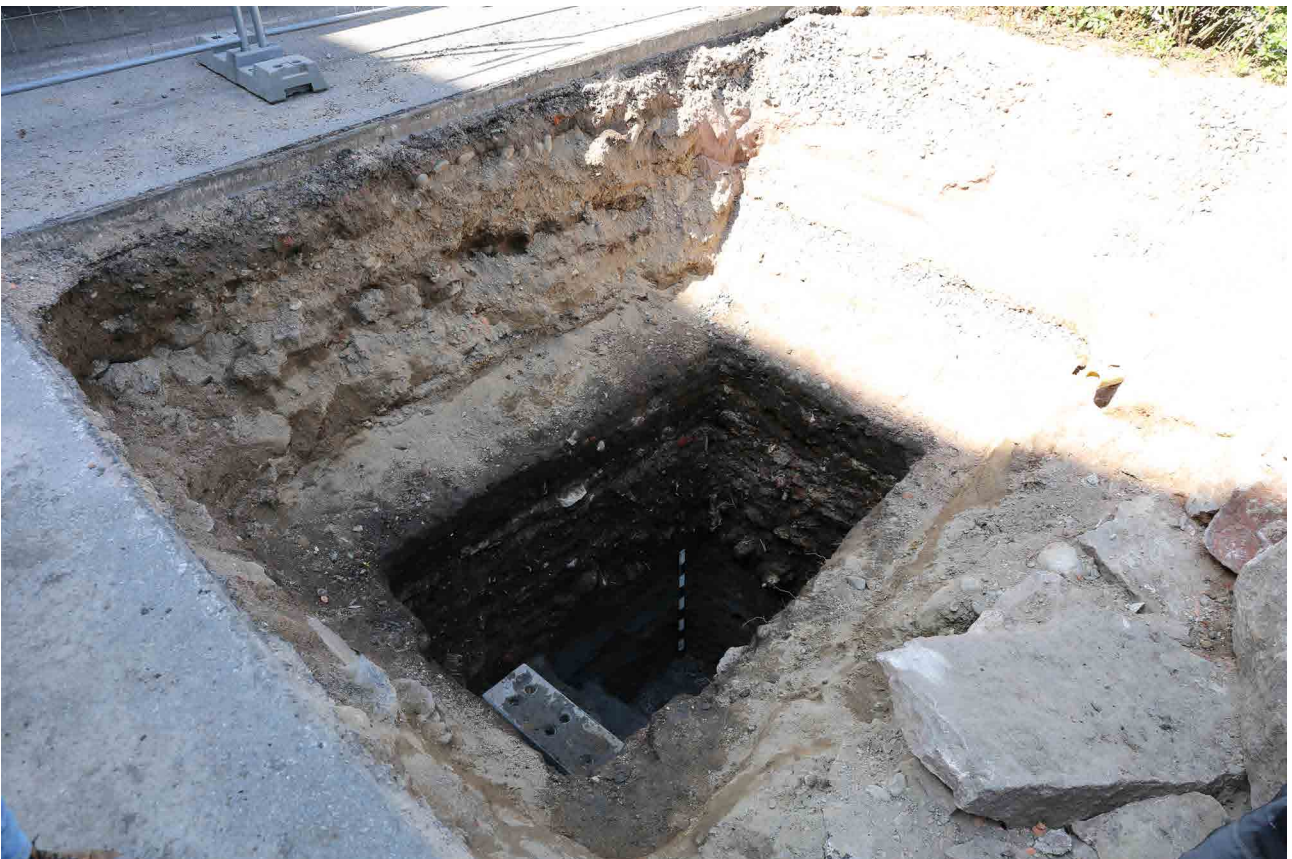
MuTu122029Dg_33: Koekuoppa pohjaan kaivettuna, etuoikealla kellarin R105 perustuskiviä. Idästä, M. Helamaa, 20.7.2022.
