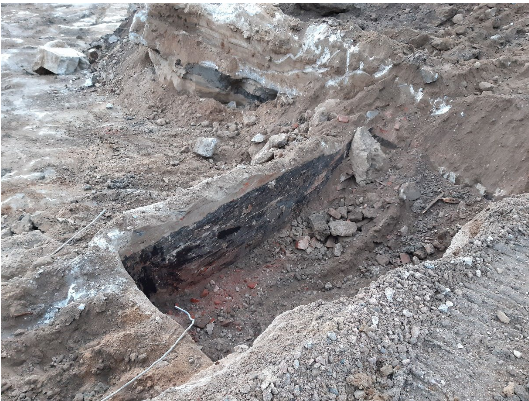
Kuva 02 – Betonisua perustuksia kunnostusalueen maaperässä
