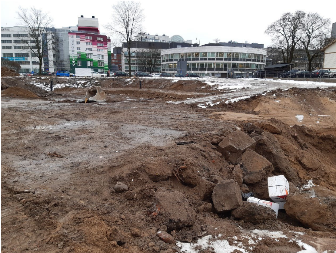
Kuva 04 – Maamassojen läjitysalue kiinteistön kaakkoisnurkassa
