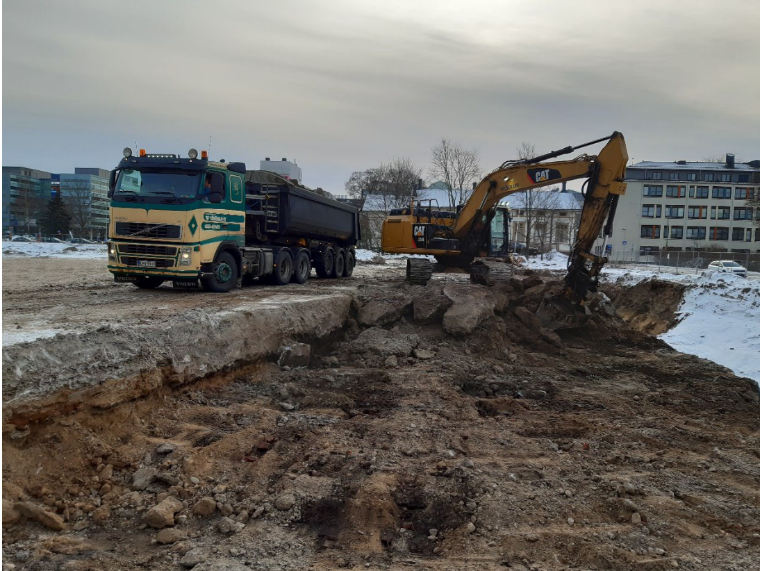
Kuva 03 – Maamassojen kuormaus käynnissä
