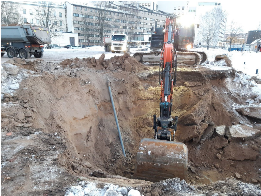
Kuva 01 – Lajitteleva kaivutyö käynnissä
