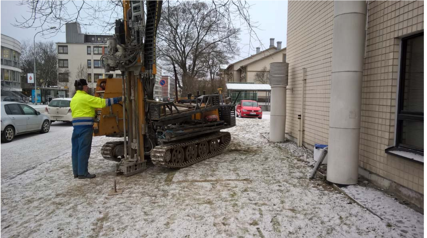
Kuva 3. Tutkimuspisteen FCG6 näytteenotto käynnissä varavoimakoneen polttoainesäiliön läheisyydessä (Sirkkalankatu vasemmalla).
