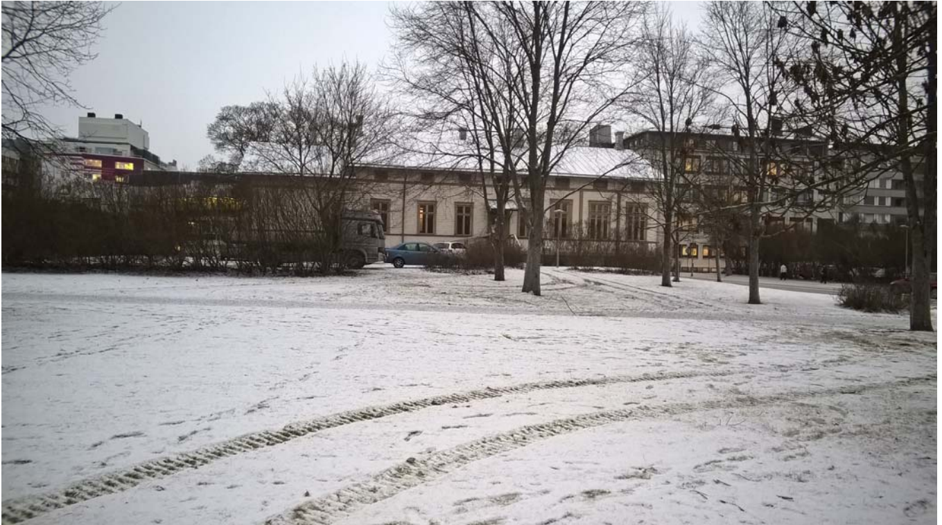
Kuva 1. Kiinteistö 853-1-36-4. Tutkimusalueen nurmialuetta ja Villa Medica -rakennus kuvattuna luoteesta.
